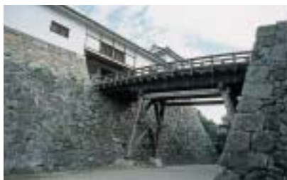
長浜城大手門を移築したものとされている天秤櫓(重文)。廊下橋は非常時は落とし橋になる。
