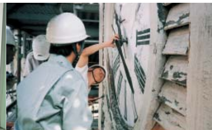
1995年から3年9か月かけて行なわれた修復では、建物の補強と同時に、時計機械の部品の洗浄・交換も行なわれた。下からのぞきこむのが井上さん。(写真/札幌市)
