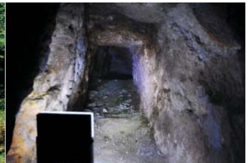
龍源寺間歩の壁面にある直径1mにも満たない横穴。銀鉱脈に沿って掘り進んでいった「ひ押し坑」の跡で、左右の壁面に20数坑ある。100m下の「永久坑」に降りる竪穴もある。
