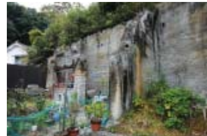
温泉津で見た、岩を削ってつくった住居の跡。温泉津の町は、急傾斜の山の間の狭い谷筋に山裾を削ってわずかな土地を確保している。
