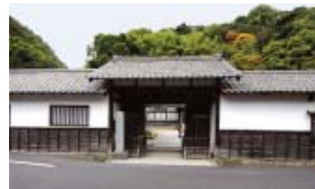
大森の町並みの北東側にある大森代官所跡。現在は石見銀山資料館として、石見銀山の調査研究、資料の保存管理・公開展示などを行なっている。
