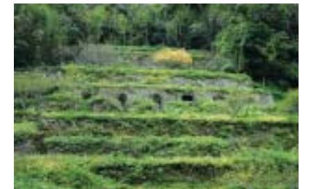
清水谷製錬所跡。明治26年に建設されたが、わずか1年半で閉鎖された。だからこそ、伝統的技術の遺構が破壊から免れたともいえる。トロッコ道などの跡も残る。
