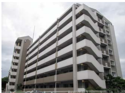
■ アーベインルネス梅光園7、8号ほか(福岡) 超速硬化塗り床材(スプレータイプ)「スプレーユータック」R-1工法/455㎡ 施工/㈱ダイニチ
