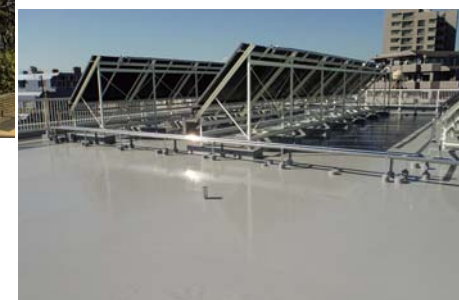
■住吉文化センター外壁及び屋上防水等改修工事(東京) 外装用微弾性塗料「シルビアサーフ」+建築外装用塗料 「シルビアWF-400」/1,900㎡ 金属面用プライマー「エボラ#1プライマー」+建築外 装用塗料「シルビアNADウレタン」/460㎡ 建築用塗膜防水材「ブルーフロンバリュー」X-2遮熱ト ップコート工法/1,200㎡ 設計/府中市役所 建設/㈱敏鉄工 施工/㈱営建企画事務所
