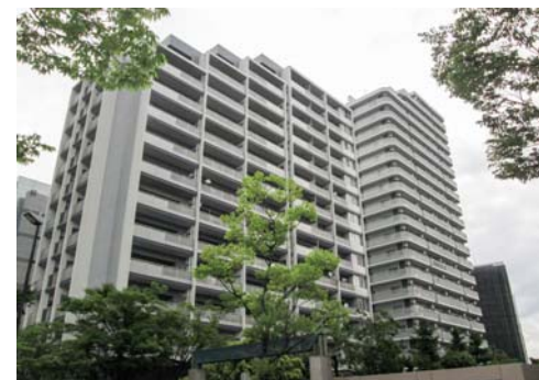
■ シーサイドももちセンターステージ2号ほか(福岡) 建築用塗膜防水材「ブルーフロン」PM-EW2.0WG/1,743㎡ 施工/㈱デシマ工業
