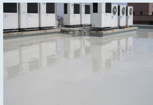
▲ブルーフロンAS活性化材で施工された屋上
