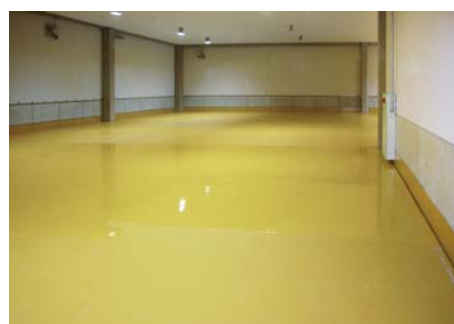
■共栄テクシード塗床工事(和歌山) 塗り床材「ユータックコンプリート」CPS-3S工法/840㎡
