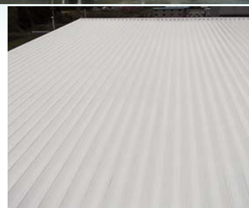
■富士産業北上工場(岩手) 金属面用遮熱プライマー「エポラ#2遮熱プライマー」+屋根用遮熱塗料「パラサーモシリコン」/3,000㎡ 施工/㈱ヤエトシ
