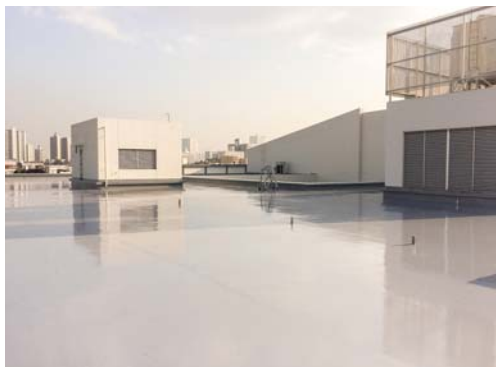
■幸市民館・図書館外壁塗装その他改修工事(神奈川) 建築用塗膜防水材「ブルーフロンエコ」X-1工法/2,140㎡ 建築用塗膜防水材「ブルーフロンエコ」X-1工法(機械固定)/282㎡ 建築用塗膜防水材「ブルーフロンエコ」X-2工法(立上がり)/772.1㎡ 施工/大和塗装㈱
