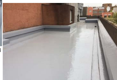
■消防研究センター大規模火災実験棟主実験場(西側)正面 玄関屋上、(東側)観測室屋上防水工事(東京) 建築用塗膜防水材「ブルーフロン」X-1/1,000㎡ 建築用塗膜防水材「ブルーフロン」X-2立上がり/220㎡ 施工/光栄技建工業㈱
