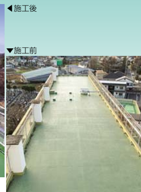
■秩父県土整備事務所庁舎屋上防水改修工事(埼玉) 超速硬化塗膜防水材(スプレータイプ)「NTスプレータイプS」NKD-SS30S/ 880㎡ 超速硬化塗膜防水材(スプレータイプ)「NTスプレータイプS」X-2/233㎡ 施工/㈱日本アステック
