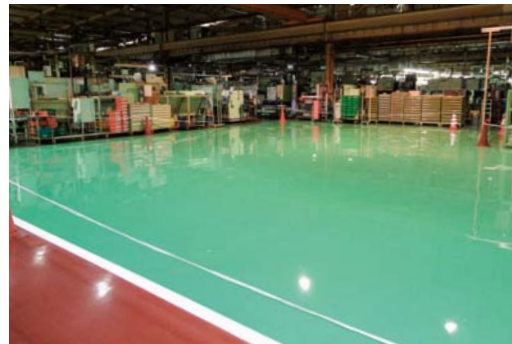
■光洋機械工業結崎工場(大阪) 塗り床材「ユータックE-30N」樹脂モルタル流し展べ工法/250㎡ 建設/㈱三栄建設 施工/アサヒカラコン㈱
