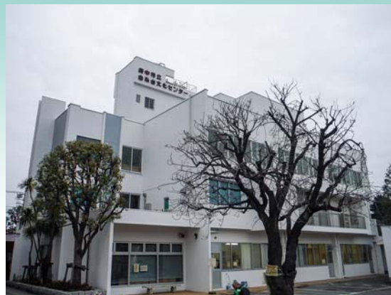
■白糸台文化センター外壁及び屋上防水等改修工事(東京) 外装用微弾性塗料「シルビアサーフ」+建築外装用塗料「シルビアWF-400」/1,800㎡ 建築用塗膜防水材「ブルーフロンバリュー」X-2遮熱トップコート工法/720㎡ 設計/府中市役所 建設/㈱営建設 施工/㈱営建企画事務所
