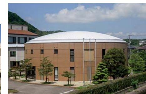
■石見高等看護学院(大講義棟)外壁改修等工事(島根) 建築用塗膜防水材「ブルーフロンエコ」X-2工法/163㎡ 屋根用塗料「リリーフNADシリコン」/645㎡ 施工/寺戸工業㈱
