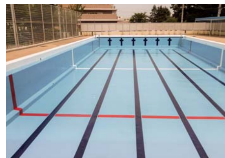
■板橋区立上板橋第二中学校プール改修工事(東京) プール用塗料「プールエース」コンクリート・モルタル製 プール標準施工仕様/450㎡ 施工/㈱大向塗装
