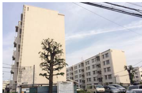
■(市営)久末住宅(1・2号棟)屋上防水改修工事(神奈川) 建築用塗膜防水材「ブルーフロンエコ」X-1工法(PKD-E3OWS工法)/610㎡ 施工/㈱イマムラ
