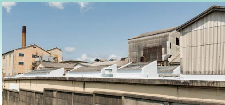
■ ダイワポウレロン屋上防水工事(島根) 超速硬化塗膜防水材(スプレータイプ)「NTスプレータイプS」PK-Q30S第1期工事/2,710㎡、第2期工事/1,454㎡、第3期工事/1,910㎡ 施工/寺戸工業(株)
