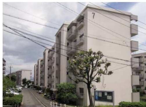
■ 野間台住宅大規模改修工事(福岡) 建築用塗膜防水材「ブルーフロン」PG-E30WG他/2,000㎡ 建設/㈱飯田工務店 施工/㈱ハクシン工業
