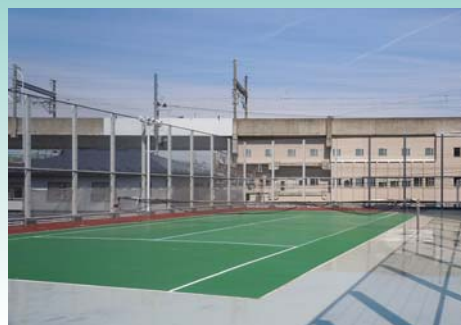
■パレ・ロワイヤルマンションテニスコート(岩手) 塗り床材「ユータックFエコ」+「ユータックFT」/700㎡ 施工/㈱TERUI
