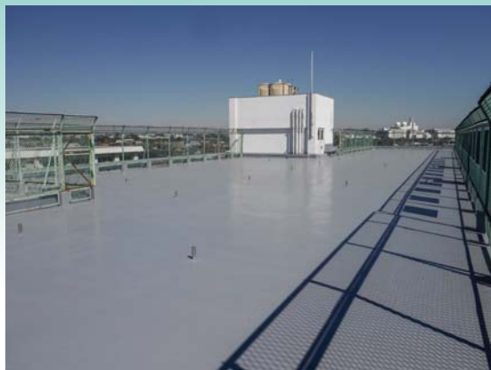
■府中第八中学校屋上防水改修工事(東京) 建築用塗膜防水材「ブルーフロンバリュー」X-1遮熱トップコート工法/1,500㎡ 建築用塗膜防水材「ブルーフロンバリュー」X-2遮熱トップコート工法/350㎡ 設計/府中市役所 建設/田丸屋建設㈱ 施工/㈱営建企画事務所
