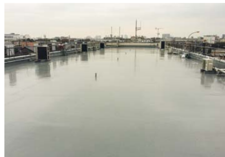
■塩浜営業所屋上防水改修工事(神奈川) 建築用塗膜防水材「ブルーフロンエコ」X-1工法(PKD-E3OWG工法)/669㎡ 建築用塗膜防水材「ブルーフロンエコ」X-2工法(立上がり)/195㎡ 施工/㈱村田塗装工業所
