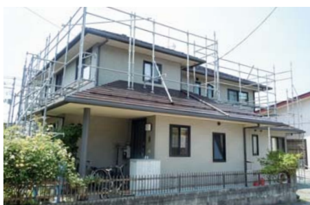
■宇井邸(山形) 金属面用遮熱プライマー「エボラ#2遮熱プライマー」+ 屋根用遮熱塗料「パラサーモシリコン」/700㎡ 施工/㈱太田塗装店
