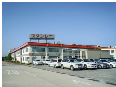
■スタンレー鶴岡工場(山形) 塗り床材「ユータッククリーンE」/900㎡ 建設/㈱藤井工務店 施工/㈱加藤塗装店
