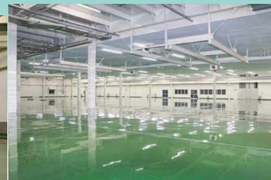
■シービー化成新築工事(広島) 塗り床材「ユータックE-30N」/2,500㎡ 塗り床材「ユータックE-40」/2,500㎡ コンクリート表面強化材「NTクリスタルハードナー」/2,000㎡ 施工/㈱井上塗装工業
