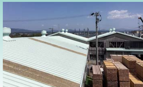
■ 石橋木工所折半屋根塗装工事(福岡) 屋根用遮熱塗料「スーパーパラサーモシリコンS」金属屋根下地仕様/2,000㎡ 建設/㈱ニシイ 施工/秋山塗装店
