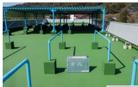
■ 海洋水産棟内外部大規模改造工事(大分) 建築用塗膜防水材「ブルーフロンバリュー」平場X-1工法、立上がりX-2工法/613㎡ 建設/㈱佐々木工務店 施工/大分サンダイン(株)
