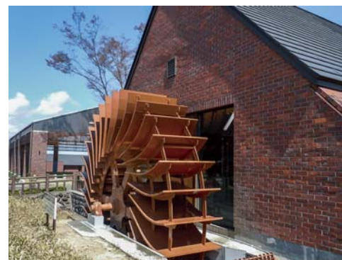
■四季の里水力発電(福島) 塗り床材「ユータックR」/650㎡ シルビアEプライマー+ユータックR2回+シルビアSP ヨゴレガード 施工/㈱中川水力
