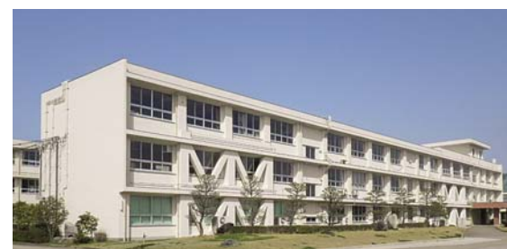
■益田翔陽高等学校大規模修繕(管理棟)工事(島根) 建築外装用断熱塗料「NTダンネツコート」艶消し仕上げ/2,507.7㎡ 超速硬化塗膜防水材(スプレータイプ)「NTスプレータイプS」X-2工法/1,720㎡ 施工/寺戸工業㈱
