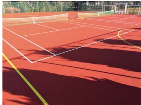
■藤沢市某工場テニスコート(神奈川) 塗り床材「ユータックUグラウンドコート」アスコン面仕様/1,266㎡ 建設/大藤工業㈱ 施工/小田塗装工業㈱
