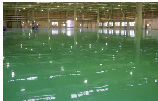
■某O工場(愛知) 塗り床材「ユータックE-30N」流し展べ工法/6,750㎡ 塗り床材「ユータックE-30N」流し展べ防滑工法/550㎡ 設計・建設/山旺建設㈱ 施工/ナカ工塗装㈱、小田建塗工業㈱
