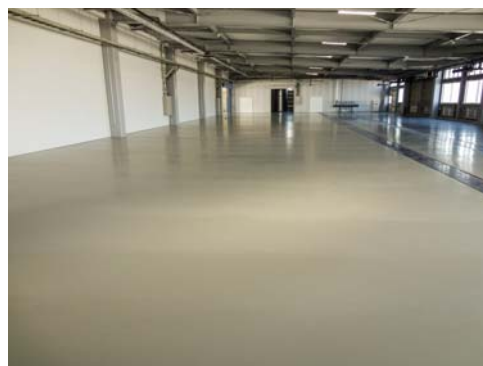
■日吉染業(和歌山) 塗り床材「ユータックコンプリート」CPS-3F工法/1,400㎡ 建設/三友工業㈱ 施工/㈱サカイヤ、アサヒカラコン㈱
