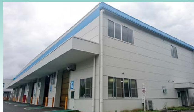
■文化シャッター掛川工場(静岡) 建築外装用断熱・遮熱塗料「NTダンネツベース」+外壁用遮熱塗料「水性パラサーモ外壁用」仕上げ/3,700㎡ 施工/㈱弘信
