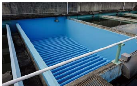
■多気浄水場上下水道改修工事(三重) 水道用コンクリート水槽内面保護塗料「ガードブルーF」コーティング工法/250㎡ 建設/㈱上田新工業 施工/ライニング技術工業㈱
