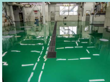
■大阪トヨタ泉北店(大阪) 塗り床材「ユータックE-30N」ハード流し展べ工法/300㎡ 建設/トヨタT & S建設㈱ 施工/アサヒカラコン㈱
