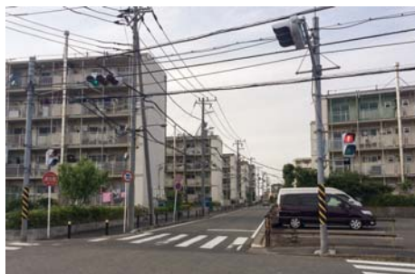
■(市営)久末住宅(6～8号棟)屋上防水改修工事(神奈川) 建築用塗膜防水材「ブルーフロンエコ」X-1工法(PKD-E3OWS工法)/860.7㎡ 施工/㈱テクノアート・イシヤマ
