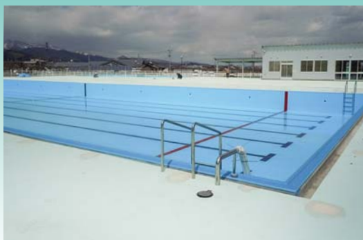
■河北町プール(山形) プール用塗料「プールエース」クッション遮熱防滑工法/2,000㎡ コンクリート・モルタル製プール工法/600㎡ 設計/山形県庁 施工/㈱ナカムラ
