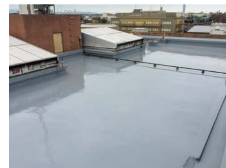
■消防研究センター大規模火災実験棟主実験場(西側)正面 玄関屋上、(東側)観測室屋上防水工事(東京) 建築用塗膜防水材「ブルーフロン」X-1/1,000㎡ 建築用塗膜防水材「ブルーフロン」X-2立上がり/220㎡ 施工/光栄技建工業㈱
