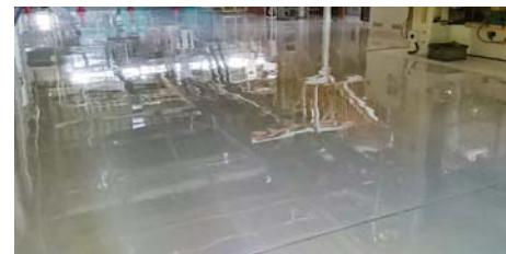
■日本特殊塗料愛知工場製造4課(愛知) 塗り床材「ユータックE-30N」樹脂モルタル流し展べ工法/400㎡ 施工/㈱愛知レジン
