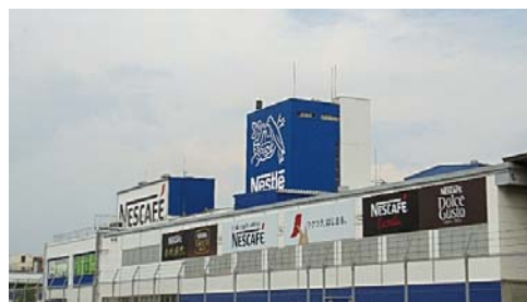
■ネスレ姫路(兵庫) 塗り床材「ユータックE-30N」ハード流し展べ工法/1,200㎡ 建設/㈱竹中工務店 施工/㈱タナカ美建
