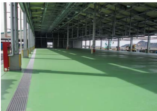
■ 長崎魚市場新築工事(長崎) 塗り床材「ユータックE-30N」ハード流し展べ防滑工法/3,500㎡ 建設/㈱上滝 施工/㈱ヒロシヨウ技建
