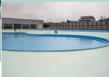
■河北町プール(山形) プール用塗料「プールエース」クッション遮熱防滑工法/2,000㎡ コンクリート・モルタル製プール工法/600㎡ 設計/山形県庁 施工/㈱ナカムラ
