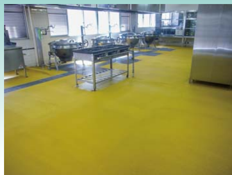
■箕面支援学校厨房床改修工事(大阪) 塗り床材「ユータックコンプリート」CPM-3N工法/130㎡ 施工/㈱アクティ商会
