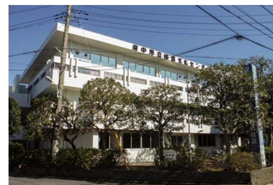
■住吉文化センター外壁及び屋上防水等改修工事(東京) 外装用微弾性塗料「シルビアサーフ」+建築外装用塗料 「シルビアWF-400」/1,900㎡ 金属面用プライマー「エボラ#1プライマー」+建築外 装用塗料「シルビアNADウレタン」/460㎡ 建築用塗膜防水材「ブルーフロンバリュー」X-2遮熱ト ップコート工法/1,200㎡ 設計/府中市役所 建設/㈱敏鉄工 施工/㈱営建企画事務所
