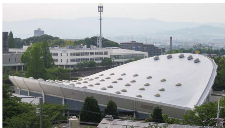
■パナソニックアリーナ(大阪) シート防水材用上塗塗料「ノンリクコート」/4,300㎡
