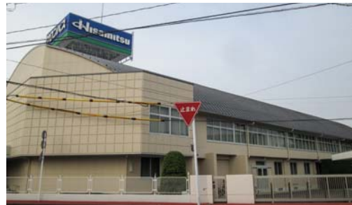
■ 久光製薬鳥栖工場体育館屋根(佐賀) 屋根用遮熱塗料「パラサーモシリコン」/1,000㎡ 施工/長家塗装(株)
