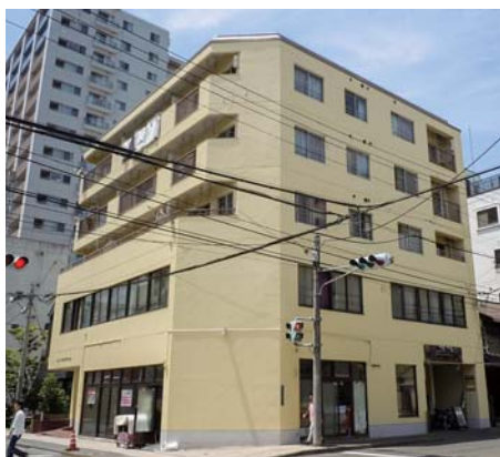
■第3今野興業ビル(宮城) 高弾性外壁防水塗料「ハイブルーフ」/2,000㎡ 建築用塗膜防水材「ブルーフロンバリュー」/400㎡ 施工/㈱東北ペイント(旧名:東北塗料)
