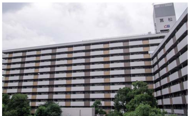
■ UR笠松団地1、2、3号棟新規工事(福岡) 建築用塗膜防水材「ブルーフロン」PM-EW2.0WG/1,941㎡ 施工/㈱デシマ工業
