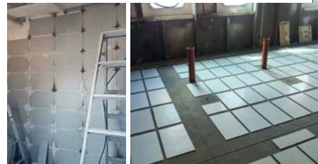
▲施工例（左が壁用、右は床用）
