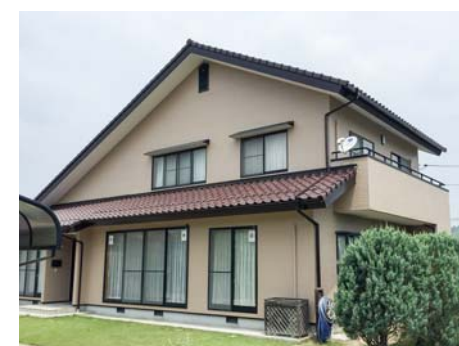
■K様邸(島根) 建築外装用ハイブリッド無機塗料「シルビアセラティーN」/300㎡ 施工/㈱イトーケミカル
