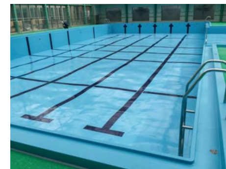
■都立府中けやきの森学園プール棟その他改修工事(東京) プール用塗料「プールエース」クロス入りライニング工法 /900㎡ 建設/㈱CMC 施工/遠藤塗工㈱
