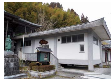
■ 専光寺納骨堂屋上防水工事(大分) ポリマーセメント系塗膜防水材「ブルーフロンアクア」AQ-1N工法/140㎡ 施工/吉本
