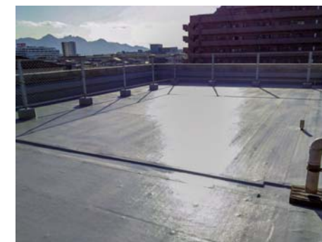
■某施設屋上防水改修工事(広島) 超速硬化塗膜防水材(スプレータイプ)「NTスプレータイプS」NK-SS30G工法/181.6㎡ 超速硬化塗膜防水材(スプレータイプ)「NTスプレータイプS」NM-SS20G立上がり工法/95.8㎡ 施工/聡明工業㈱
