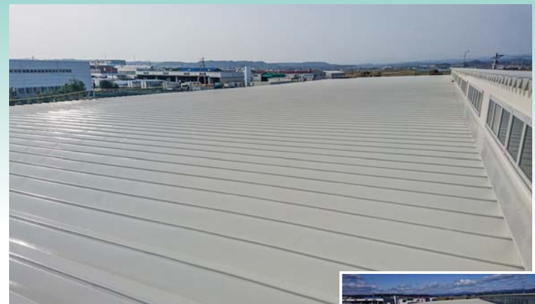
■スリーエス物流袋井営業所(静岡) 屋根用塗料「リリーフNADウレタンN」/6,030㎡ 建設/大和情報サービス㈱ 施工/佐野塗装㈱
