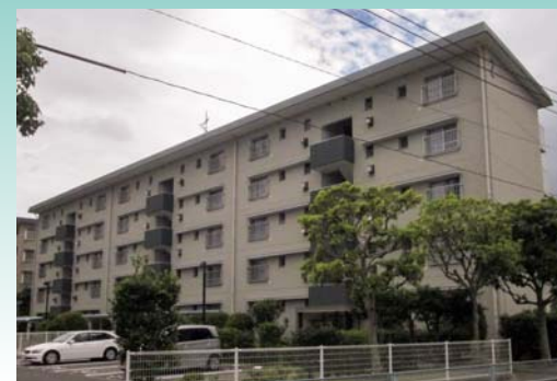
■ 田島団地1、2、3号棟(福岡) 建築用塗膜防水材「ブルーフロン」PM-EW2.0WG/1,374㎡ 施工/㈱こざき
