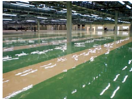
■ジェイテクト亀山(三重) 塗り床材「ユータックE-30N」流し展べ工法/8,000㎡ 建設/㈱三栄建設 施工/アサヒカラコン㈱
