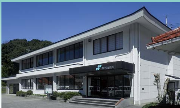
■ 石西地区農業共済組合屋根及び外壁改修工事(島根) 屋根用遮熱塗料「パラサーモン」/477㎡ 外装用微弾性塗料「シルビアサーフ」+建築外装用塗料「シルビアWU-200」/395.4㎡ 軒裏天井用塗料「シルビアクリーン」/191㎡ 施工/寺戸工業(株)
