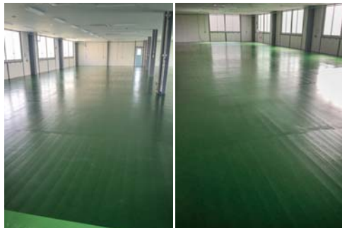
■湊製作所新築工事(神奈川) 塗り床材「ユータッククリーンE」コーティング工法/460㎡ 塗り床材「ユータックE-30Nローラー用」コーティング工法/1,151㎡ 建設/㈱エス・ケイ・ディ 施工/㈱牛川塗装工業
