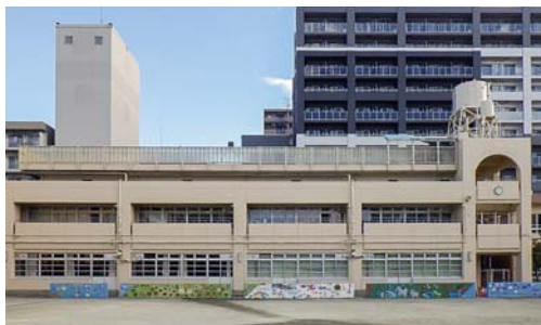
■川崎小学校外壁塗装改修その他工事(2期)(神奈川) 建築用塗膜防水材「ブルーフロンエコ」X-1工法(PKD-E3OWS工法)/470㎡ 建築用塗膜防水材「ブルーフロンエコ」X-2工法(平場)/60㎡ 建築用塗膜防水材「ブルーフロンエコ」X-2工法(立上がり)/46.6㎡ 施工/㈱マミヤ
