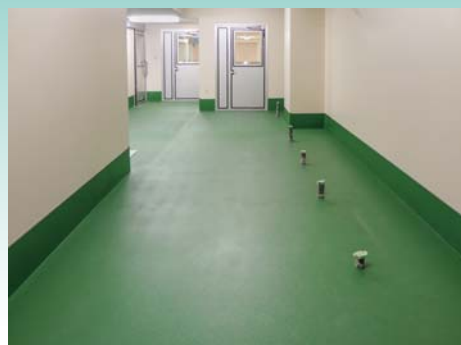
■八尾市志紀小学校厨房(大阪) 塗り床材「ユータックE-30N抗菌」防滑工法/300㎡ 建設/三栄建設㈱ 施工/アサヒカラコン㈱
