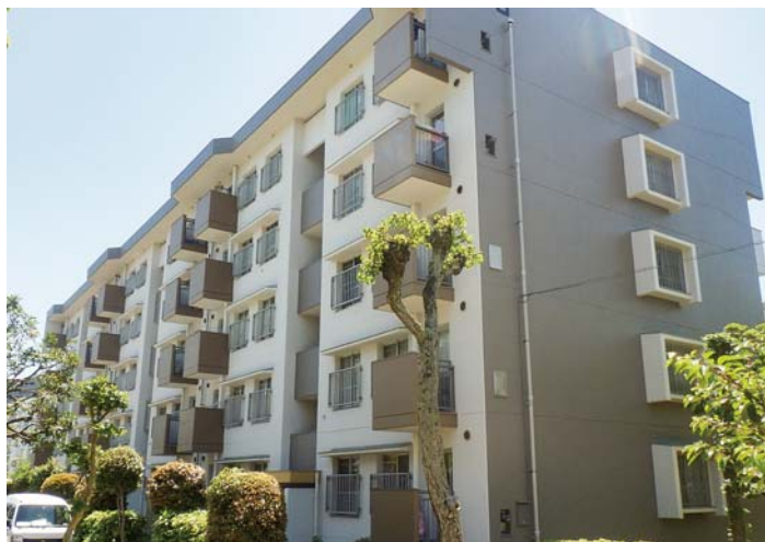
■ 香椎若葉団地外壁修繕その他工事(福岡) 建築用塗膜防水材「ブルーフロン」PM-EW2.0WG/3,000㎡ 施工/㈱デシマ工業
