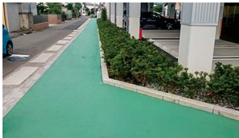
■神奈川スバル平塚店リニューアル工事(外部歩行路・駐車場床)(神奈川) 塗り床材「ユータックテクノ」上塗りコーティング工法/約300㎡ 施工/㈱三ケ木塗装店
