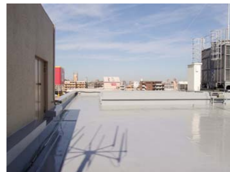
■ 某ショッピングセンター屋上防水改修工事(福岡) 建築用塗膜防水材「ブルーフロン」PN-V30G/700㎡ 施工/㈱安河内工業
