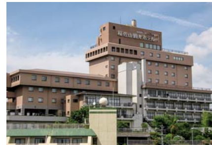
■ 稲佐山観光ホテル南館屋上、EV室屋根防水工事(長崎) 建築用塗膜防水材「ブルーフロン」X-2工法/346.4㎡ 施工/㈱中央塗料商会
