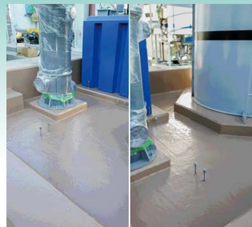
■野田村バイオマス(岩手) 塗り床材「ユータックVE-100」/200㎡ 施工/㈱前田塗装
