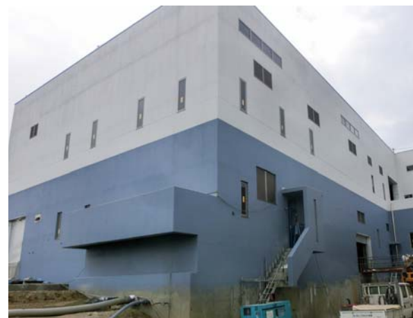
■和歌山市汚泥再生処理センター(和歌山) 防食被覆材「タフバリア#150」A-4工法/650㎡ 防食被覆材「タフバリア#150」B-4工法/5,400㎡ 防食被覆材「タフバリア#150」C-4工法/1,500㎡ 防食被覆材「タフバリア#150」D-4工法/1,900㎡ 塗り床材「ユータックE-30N」/2,500㎡ 塗り床材「ユータックE-40」/1,100㎡ 塗り床材「ユータックVE-100」/200㎡ コンクリート表面強化材「NTクリスタルハードナー」/1,100㎡ 建設/三井造船環境エンジニアリング㈱、三友工業㈱ 施工/㈱サカイヤ
