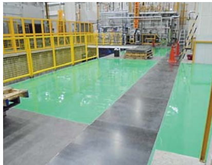
■ジェイテクト国分(大阪) 塗り床材「ユータックE-30N」流し展べ工法/200㎡ 建設/㈱三栄建設 施工/アサヒカラコン㈱
