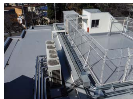
■四谷文化センター屋上等改修工事(東京) 建築用塗膜防水材「ブルーフロンバリュー」X-1遮熱ト ップコート工法/100㎡ 建築用塗膜防水材「ブルーフロンバリュー」X-2遮熱ト ップコート工法/530㎡ 設計/府中市役所 建設/荒井建設㈱ 施工会社/㈱営建企画事務所
