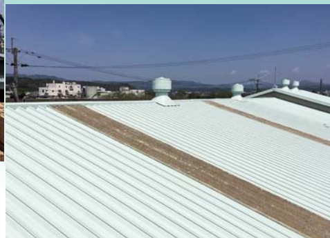
■ 石橋木工所折半屋根塗装工事(福岡) 屋根用遮熱塗料「スーパーパラサーモシリコンS」金属屋根下地仕様/2,000㎡ 建設/㈱ニシイ 施工/秋山塗装店
