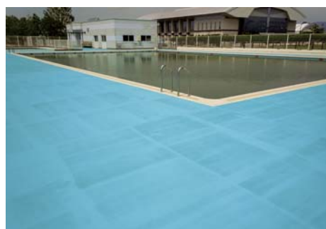
■鶴岡市立藤島小学校プールサイド(山形) 下地調整剤「NTカチオンタイトF」+プール用塗料「プ ールエース」防滑工法(コンクリート・モルタル)/600㎡ 施工/㈱太平堂塗装
