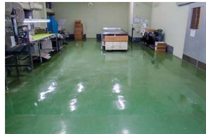
■ 志免町某工場床改修工事(福岡) 塗り床材「ユータックE-30Nローラー用」塗り替え工法/75㎡ 施工/㈱松本塗装店
