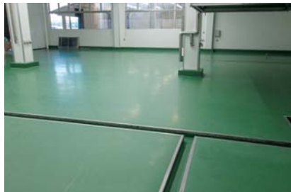
■ 山口酒造増築工事(福岡) 塗り床材「ユータックコンプリート」CPS-3N工法/400㎡ 施工/㈱駿河コーポレーション
