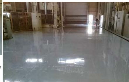
■日本特殊塗料愛知工場製造4課(愛知) 塗り床材「ユータックE-30N」樹脂モルタル流し展べ工法/400㎡ 施工/㈱愛知レジン
