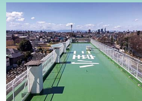
■さいたま市立三室小学校屋上改修工事(埼玉) 建築用塗膜防水材「ブルーフロン」X-1、X-2/2,900㎡ 施工/㈱南雲建装
