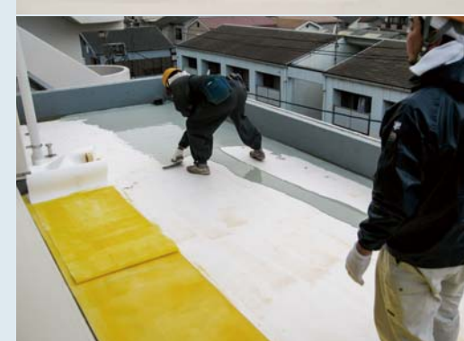
▲ブルーフロンエコONEの施工
