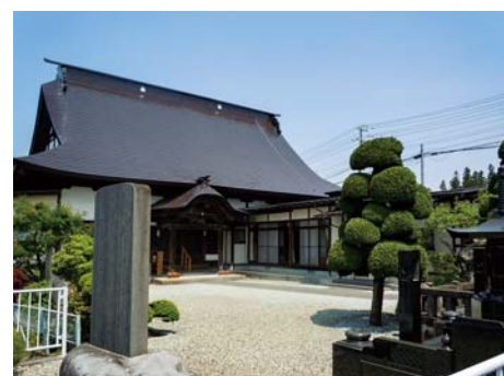
■常林寺(山形) 金属面用遮熱プライマー「エボラ#2遮熱プライマー」+ 屋根用遮熱塗料「パラサーモシリコン」/900㎡ 施工/㈱太田塗装店
