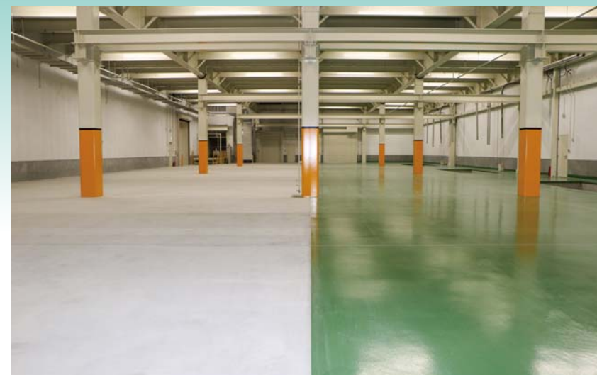
■シービー化成新築工事(広島) 塗り床材「ユータックE-30N」/2,500㎡ 塗り床材「ユータックE-40」/2,500㎡ コンクリート表面強化材「NTクリスタルハードナー」/2,000㎡ 施工/㈱井上塗装工業
