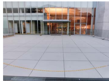
■某市交流会館エントランス塗り床改修(岐阜) 塗り床材「ユータックテクノ」コーティング防滑工法/250㎡ 施工/㈱本多塗装店
