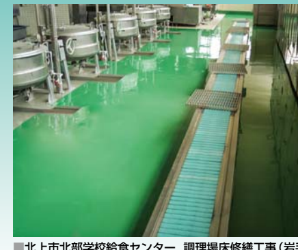
■北上市北部学校給食センター 調理場床修繕工事(岩手) 塗り床材「ユータックスーパーFハード」/248.4㎡ 塗り床材「ユータックコンプリーツG」/26.2㎡ 施工/㈲ヤエトシ
