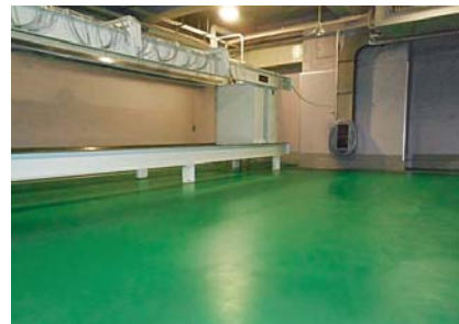
■秋田酒類製造株式会社 床改修工事(秋田) 塗り床材「ユータックコンプリート」CPS-3F工法/300㎡ 施工/三建塗装株式会社
