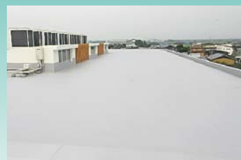
■(仮称)刈谷市立特別支援学校建設工事に伴う既設南、北校舎 屋上防水改修工事(愛知) 建築用塗膜防水材「ブルーフロンバリュー」X-2工法/2,154㎡ 建築用塗膜防水材「ブルーフロンバリューNS」(立上がり)/298.1㎡ 設計/㈱加藤建築事務所 建設/サンエイ(株) 施工/新生建工(株)
