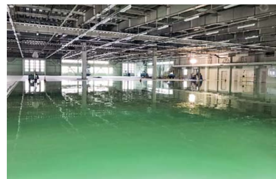
■株式会社北陸製作所 塗り床工事(福井) 塗り床材「ユータックE-30N」/5,000㎡ 建設/小倉建設株式会社 施工/株式会社山本塗装店、アサヒカラコン株式会社
