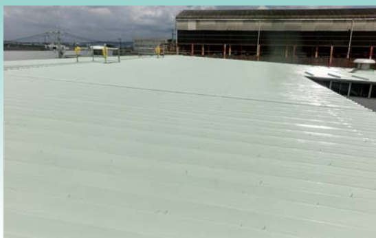
■豊田市某工場屋根(愛知) 金属面用遮熱プライマー「エボラ#2遮熱プライマー」、建築屋根用遮熱塗料「パラサーモシリコン」ライトグリーン/3,600㎡ 施工/㈱大野工機
