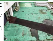
■秩父国際カントリークラブ ベランダ防水改修工事(埼玉) 超速硬化塗膜防水材(スプレータイプ)「NTスプレータイプS」機械固定工法 3.0mm厚、 建築用塗膜防水材用上塗り塗料「ブルーフロンGRトップ」仕上げ NN-SS30G工法/700㎡ 施工/株式会社日本アステック
