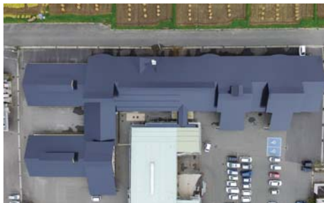
■平成28年度福祉の里めざみ 施設改修工事(山形) 建築屋根用遮熱塗料「パラサーモフッ素」/約3,200㎡ 建設/樋口建設株式会社 施工/株式会社建築テクノ
