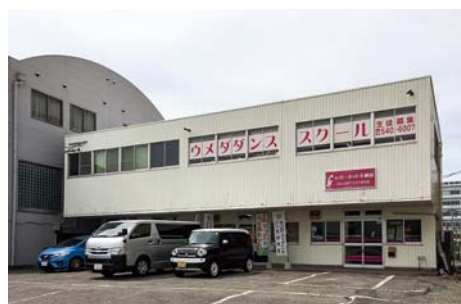
■ホワイトオフィス 外壁改修工事(大分) 建築屋根用遮熱塗料「パラサーモシリコン」/450㎡ 建築外装用遮熱塗料「パラサーモシリコン外壁用」/500㎡ 施工/㈱有永塗装
