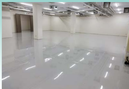
■某精密機械工場床新設工事(秋田) 塗り床材「ユータックE-30Nローラー用」コーティング工法/1,500㎡ 施工/株式会社共立塗装
