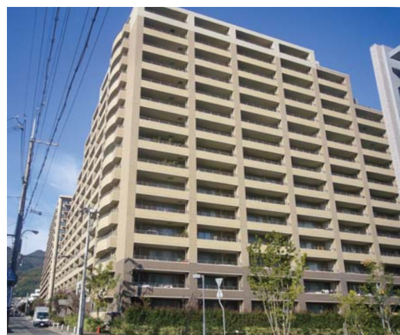
■エルヴェール神戸 本山アーバンライフ 大規模修繕工事(兵庫) 外装用微弾性塗料「シルビアサーフ」 建築外装用塗料「シルビアWS-300」/7,000㎡ 建築外装用塗料「シルビアノキクリーン」/8,000㎡ 建築用塗膜防水材「ブルーフロン」/750㎡ 施工/ニットクメンテ(株)大阪支店
