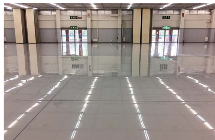
■某展示床改修工事(広島) 塗り床材「ユータックE-30N」薄膜流し展べ工法/2,640㎡ 施工/ヤマグチ(有)
