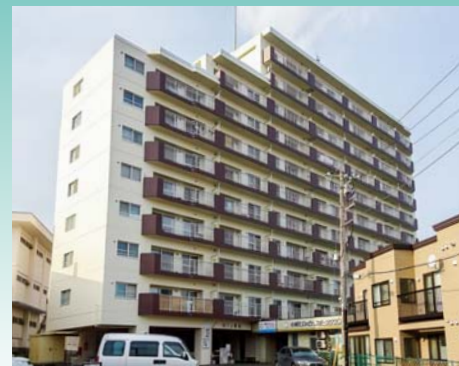
■ロジェ若松 大規模修繕工事(北海道) 外装用微弾性塗料「シルビアサーフ」、 高弾性外壁防水塗料「ハイブルーフ」上塗り/3,756㎡ 建築用塗膜防水材「フルーフロンバリュール」/542㎡ 施工/㈱星塗装工業
