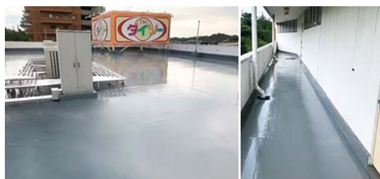
■ダイソー伊川谷店(兵庫) 建築用塗膜防水材「ブルーフロンエコ」PN-E30G工法 屋上/778㎡ バルコニー/112㎡ 施工/オーエム建工(株)
