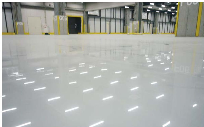
■ヤマト運輸株関西ゲートウェイターミナル新築工事(大阪) 塗り床材「ユータックE-30N」ハード流し展べ工法/28,000㎡ 施工/アサヒカラコン(株)
