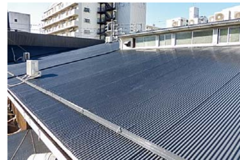
■港興産ビル、港興産ビル3号館 屋根改修工事(神奈川) 建築屋根用遮熱塗料「パラサーモン」/1,200㎡ 施工/株式会社青柳組
