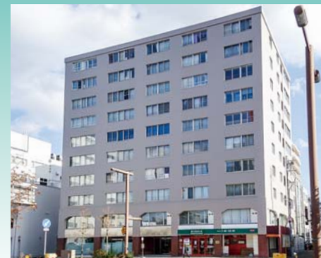
■サンハイツ南5条 大規模修繕工事(北海道) 外装用微弾性塗料「シルビアサーフ」、 高弾性外壁防水塗料「ハイブルーフ」上塗り/2,170㎡ 施工/㈱星塗装工業
