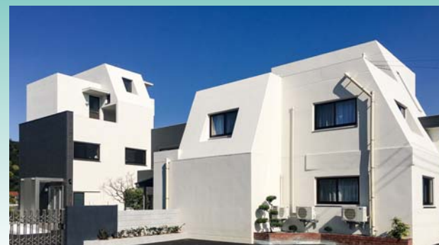
■I邸 改修工事(島根) 建築外装用断熱塗料「NTダンネツコート」W断熱大波工法 遮熱仕様、建築外装用遮熱塗料「シルビアセラティーンN」/600㎡ 施工/㈱板持塗装店
