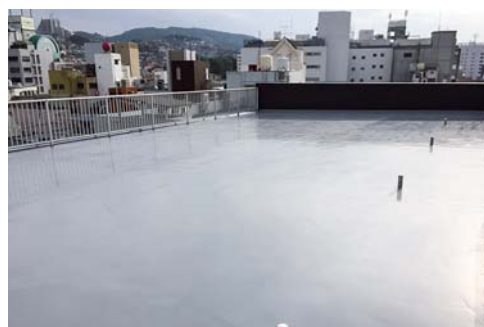
■セントラルビル 屋上防水改修工事(長崎) 建築用塗膜防水材「ブルーフロンバリュー」X-1工法/400㎡ 施工/㈱ヌリケン・プラス
