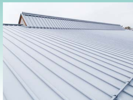
■能代市立東雲中学校体育館(秋田) 鋼板屋根用厚膜カラー塗料「マッキンレー」/2,200㎡ 施工/滝沢塗装
