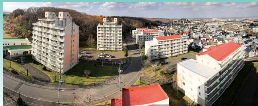
■パークヒルズ北広島団地 第2回目大規模修繕工事(北海道) 建築外装用遮熱塗料「シルビアセラティーンN」/10,874㎡ 施工/㈱星塗装工業
