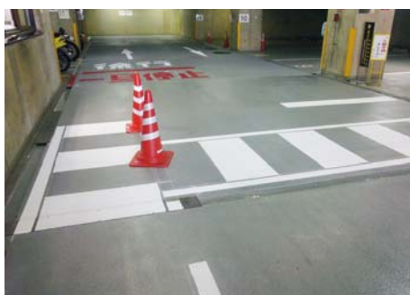
■積水化学株式会社京都技術研究所(京都) 塗り床材「ユータックE-30N」流し展べ防滑工法/300㎡ 施工/㈱クレスコ
