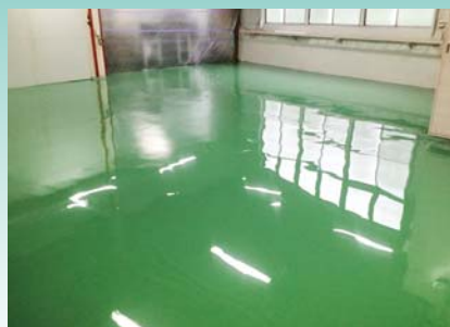
■某機械加工工場塗り床改修工事(愛知) 塗り床材「ユータックE樹脂モルクリヤー」+混合珪砂、塗り床材「ユータックE-30N」/100㎡ 施工/名古屋富士丸(株)
