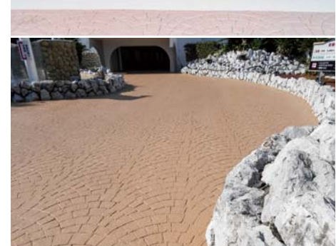
■ホテルソフィア(静岡) 建築外装用塗料「シルビア1液ハイブリッドセラ」/2,500㎡ 塗り床材「ユータックE-30ECO」防滑仕上げ/1,100㎡ 塗り床材「水性ユータックFT」コーティング防滑工法/400㎡ 施工/株式会社戸川塗装工芸
