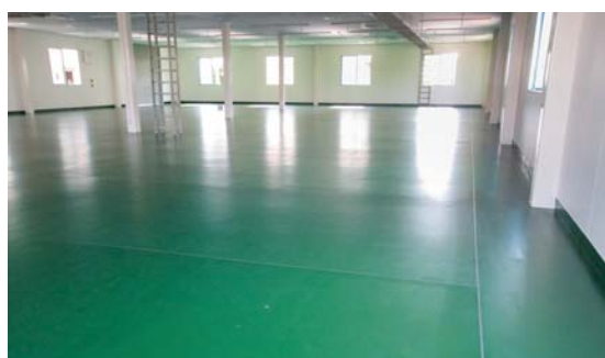
■某電子部品工場床新築工事(佐賀) 塗り床材「ユータッククリーンE」コーティング工法/600㎡ 建設/㈱北洋建設 施工/大和塗装(株)、シンエイ
