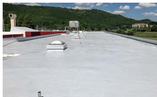
■特別養護老人ホーム小松の里 省エネ改修工事(鹿児島) 超速硬化塗膜防水材(スプレータイプ)「NTスプレータイプS」ND-SS30S/1,900㎡ 建設/中央建設(株) 施工/鹿児島ビルド(有)
