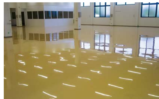
■株式会社エヌエスティー新社屋 塗り床工事(静岡) 塗り床材「ユータックE-30N」流し展べ工法/1,093㎡ 建設/株式会社中村組 施工/日装工業株式会社、小田建塗装工業株式会社
