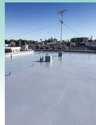
■某屋上防水工事(千葉) 建築用塗膜防水材「ブルーフロンバリュー」X-1工法/600㎡ 施工/株式会社東レビシオン
