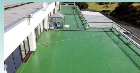
■秩父国際カントリークラブ ベランダ防水改修工事(埼玉) 超速硬化塗膜防水材(スプレータイプ)「NTスプレータイプS」機械固定工法 3.0mm厚、 建築用塗膜防水材用上塗り塗料「ブルーフロンGRトップ」仕上げ NN-SS30G工法/700㎡ 施工/株式会社日本アステック
