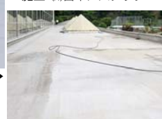
■取方体育館 屋根防水改修工事(埼玉) 超速硬化塗膜防水材(スプレータイプ)「NTスプレータイプS」機械固定工法 3.0mm厚、 建築用塗膜防水材用上塗り塗料「ブルーフロンGRトップ」仕上げ NN-SS30 G工法/395㎡ 超速硬化塗膜防水材(スプレータイプ)「NTスプレータイプS」密着立上がり工法 2.0mm厚、 建築用塗膜防水材用上塗り塗料「ブルーフロンGRトップ」仕上げ NN-SS20 G立上がり工法/75㎡ 施工/株式会社日本アステック
