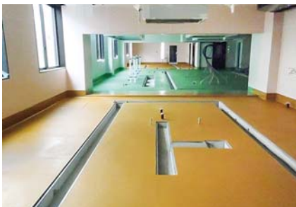
■独立行政法人国立病院機構富山病院 外来診療棟等建て替え整備工事(富山) 塗り床材「ユータックコンプリート」CPS-3N、「ユータックE-40」/420㎡ 建設/松井建設株式会社 施工/島倉塗装工業株式会社、株式会社マエダ化研
