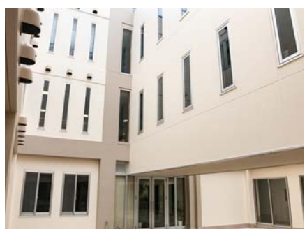
■アコラス中庭外壁改修工事他(三重) 建築外装用塗料「シルビアセラティーンN」/450㎡ 施工/㈱土谷塗装工業所
