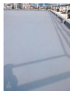
■㈱ムーンスター(福岡) 建築用塗膜防水材「ブルーフロンアクア」AQ-1WF遮熱工法/731㎡ 施工/九州エポック
