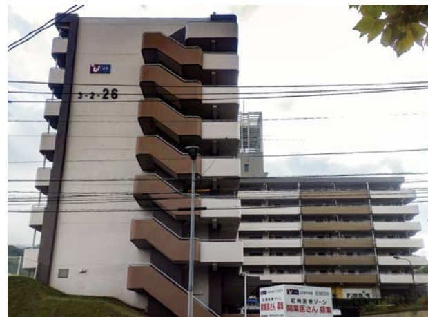
■UR紅梅団地 外壁修繕その他調査工事(福岡) 建築用塗膜防水材「ブルーフロンエコDX」PM-D2.0DG/3,400㎡ 建築用塗膜防水材「ブルーフロンエコDX」PN-D4.5UR/525㎡ 施工/日本総合住生活(株)、デシマ工業(株)
