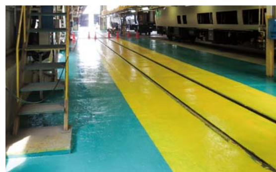
■某車両整備工場床新築工事(福岡) 塗り床材「ユータックRマイルド」コーティング工法/500㎡ 施工/従業員塗装
