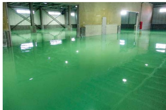
■ウェルフィ・ローマン(株) 塗り床工事(大阪) 塗り床材「ユータックE-30N」/2,800㎡ 施工/古賀工業(株)
