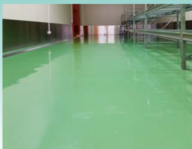
■某工場倉庫新設工事(秋田) 塗り床材「ユータックE-30Nローラー用」コーティング工法/400㎡ 建設/株式会社組 施工/株式会社加賀昭塗装
