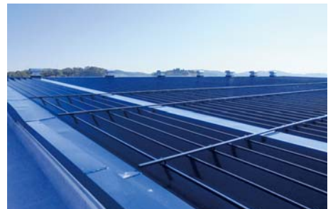
■株式会社キューソー流通システム本宮営業所(福島) 建築屋根用遮熱塗料「パラサーモシリコン」/4,200㎡ 建設/前田建設工業株式会社 施工/株式会社ワタナベ建築
