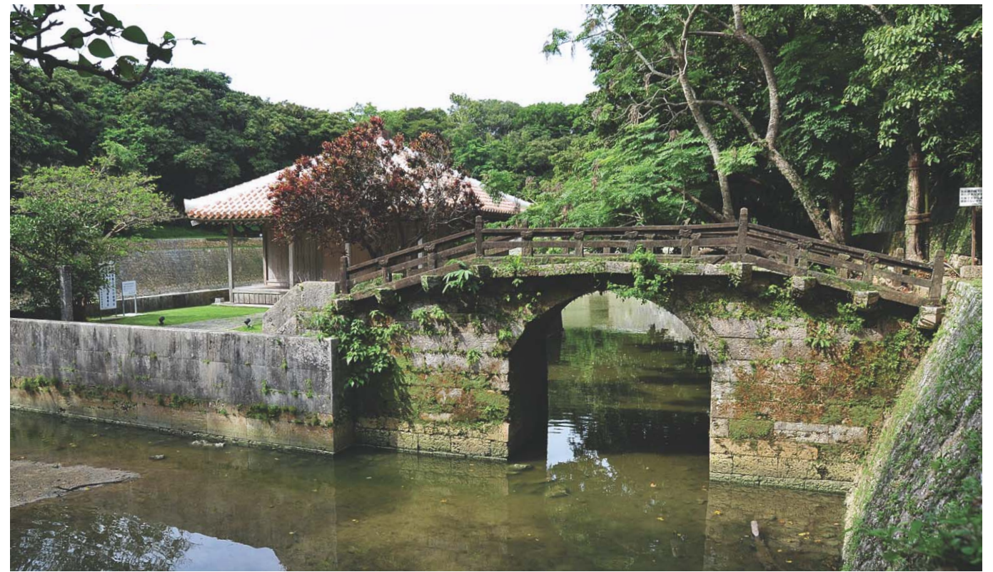
▲国の重要文化財に指定されている、琉球石灰岩による切石積みのアーチ橋、天女橋。円鑑池に築かれた中之島に設けられた弁財天堂に至る参道で、中国南部地方によく見られる駝背橋の特徴をもつ。欄干は細粒砂岩で造られ、見事な蓮の彫刻などが施されている。
