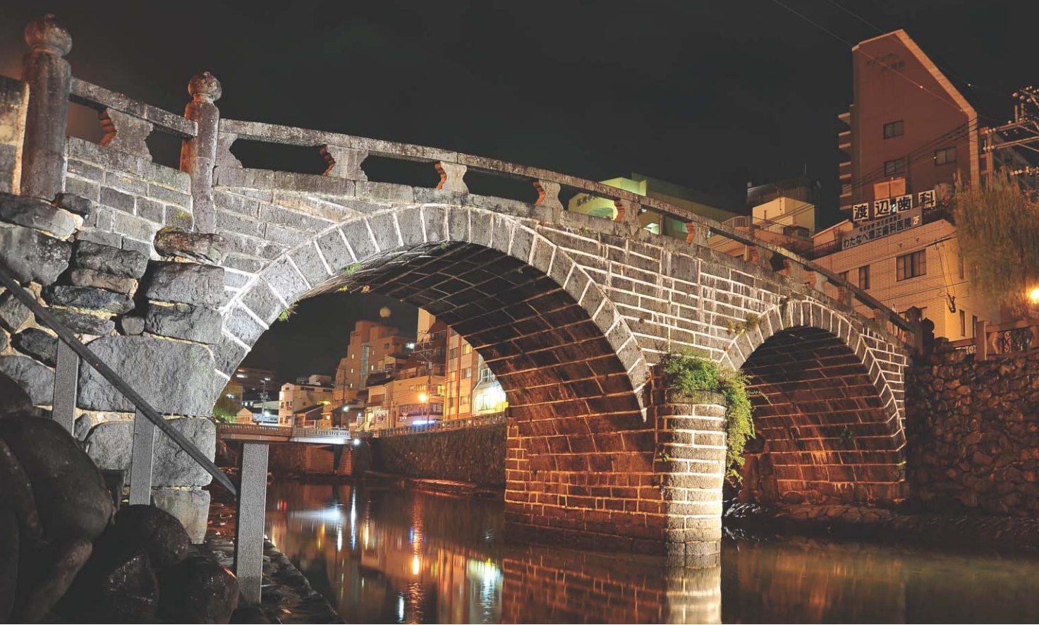
▲数百年に一度ともいわれた1982年の長崎大水害でも全壊をまぬがれた長崎眼鏡橋。目地を補強している漆喰の白が際立つ。橋の名はアーチが川面に映ると眼鏡のように見えることからつけられた(右)。国の重要文化財に指定されている。
