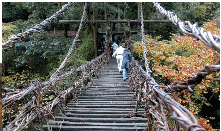
▲国と徳島県の重要有形民俗文化財に指定されている、三好市の「祖谷のかずら橋」。吉野川上流の日本三大秘境のひとつ、祖谷渓谷に重さ約5トンのシラクチカズラを編んで作られた吊橋で、長さ45m、幅2m、水面からの距離は14m。渡るときに大きく揺れ、眼下の景色は足が震えるほど。以前は渓谷地帯の唯一の交通施設だった。なお、日本三奇橋のうち、神橋ではなくこのかずら橋をそのひとつに数えることもある。
