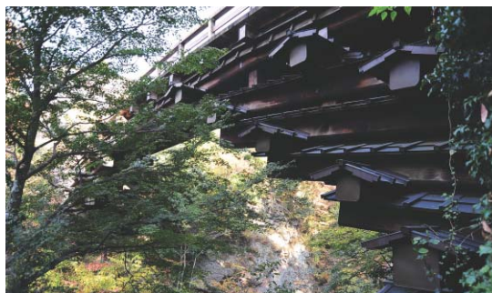
▲橋脚なしで橋を渡す技術が発揮された猿橋は、4層の笏木で支えられている。雨による腐食から保護するため、笏木や横の柱の上に設けた屋根も風情がある(左)。神橋の橋脚は鳥居の形をしている。黒漆塗の主桁の断面は縦80cm、横68cmもの太さだ(右)。
