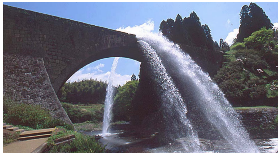
▲1854(嘉永7)年、惣庄屋・布田保之助を中心に、種山石工たちの技術を駆使して造られた、日本の石橋技術の集大成ともいえる通潤橋。熊本県上益城郡山都町(旧矢部町)の谷に架けられた農業用水の水路橋で、全長75.6m、橋幅6.3m、橋高20.2m。国の重要文化財に指定されている。
