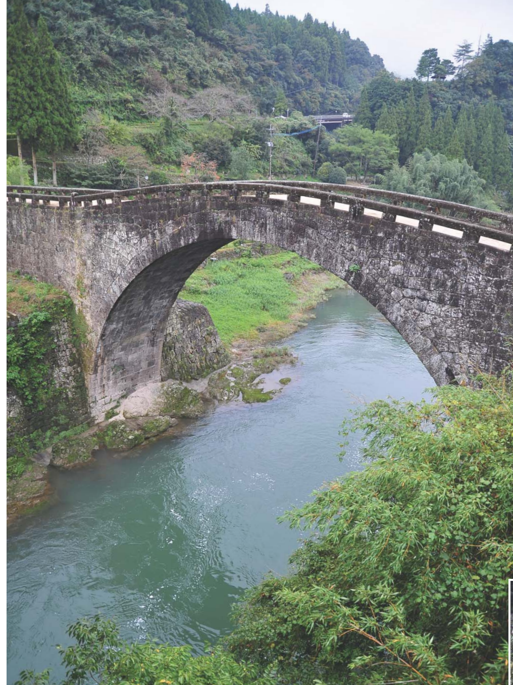
▲熊本県美里町緑川に架けられている霊台橋。惣庄屋・篠原善兵衛の要請により、種山石工の卯助と近隣在住の石工72名、大工の伴七の設計で1846(弘化3)年に着工し、わずか6~7カ月で完成させた。全長89.86m、道幅5.45m高さ16.32mで、単一アーチの石橋としては日本最大を誇る。国の重要文化財に指定されている。
