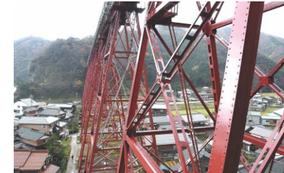
▲すべての構築物はその機能や美観を維持するための保護が必要である。その一助となっているのが塗料だ。鉄道ファンだけでなく、山陰地方を訪れる観光客にも人気がある「余部鉄橋」(国の近代土木遺産Aランク：国の重要文化財に相当)にも、当社品ではないが、塗料が使われている。余部鉄橋は全長309.42m、高さ41.45m、11基の橋脚、23連の鉄桁をもつ、トレスル式鉄橋としては日本最大規模の橋。日本海からの風が吹きつけ、橋脚が錆びやすいため、防錆処理と塗装を兼ねて数年おきに塗り替えが行なわれてきた。1909(明治42)年12月に着工、1912年3月1日に開通して以来、多くの人々に親しまれてきた鶯色(さび色2号)と独特な構造は、塗料によって保持されているのだ。なお、余部鉄橋は強風による列車の運休や事故防止のため取り壊しが決まり、南側に新たにコンクリート橋が設置されることになった。2011年春の完成に向けて、2007年3月から架替工事が進められている。
