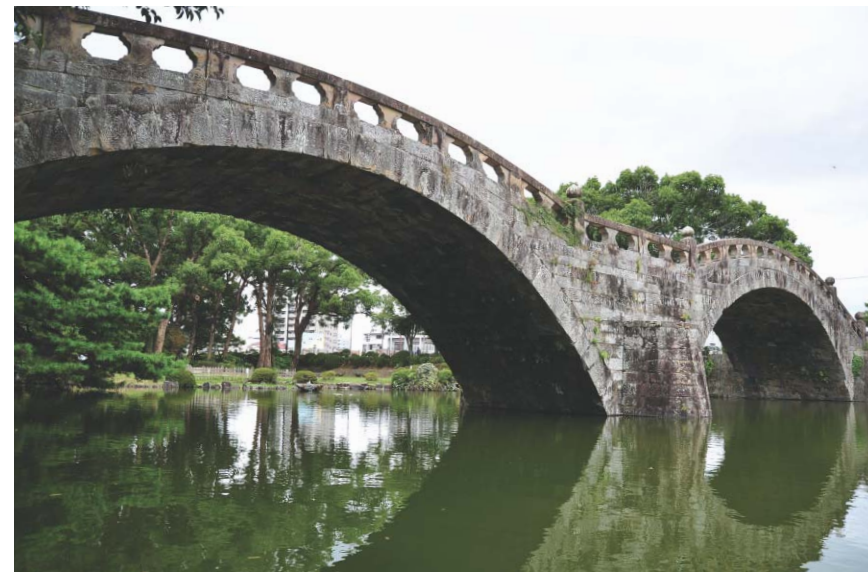
▲国の重要文化財に指定されている、琉球石灰岩による切石積みのアーチ橋、天女橋。円鑑池に築かれた中之島に設けられた弁財天堂に至る参道で、中国南部地方によく見られる駝背橋の特徴をもつ。欄干は細粒砂岩で造られ、見事な蓮の彫刻などが施されている。
