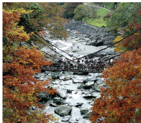
▲国と徳島県の重要有形民俗文化財に指定されている、三好市の「祖谷のかずら橋」。吉野川上流の日本三大秘境のひとつ、祖谷渓谷に重さ約5トンのシラクチカズラを編んで作られた吊橋で、長さ45m、幅2m、水面からの距離は14m。渡るときに大きく揺れ、眼下の景色は足が震えるほど。以前は渓谷地帯の唯一の交通施設だった。なお、日本三奇橋のうち、神橋ではなくこのかずら橋をそのひとつに数えることもある。
