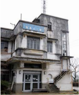
屋島山上駅 (香川・屋島ケーブル＝休止中)
