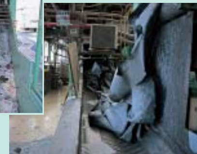
平塚工場の制振材再生ライン
