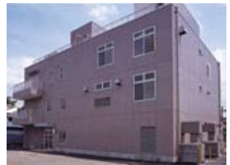
開発センター（塗料技術棟）
