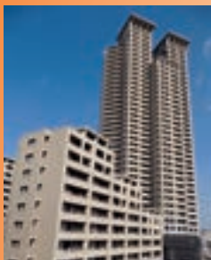
▲ ニットクメンテ(株)による マンション改修工事
