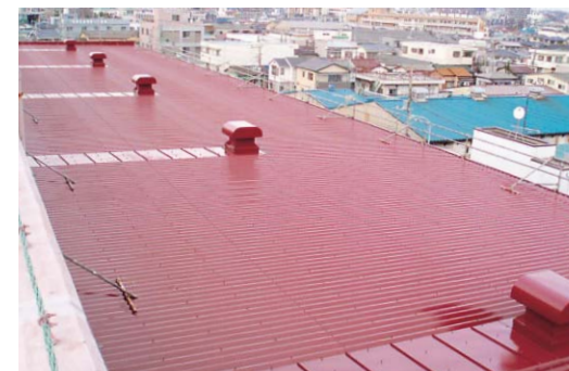
▲屋根用遮熱塗料「パラサーモシリコン」採用例 (明治図書出版(株)川口流通センター)
