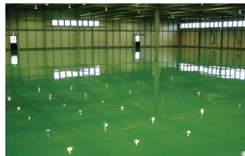
▲床用塗料(塗り床材)「ユータックE-30N」採用例 (ユニオン機工(株)三郷新工場)
