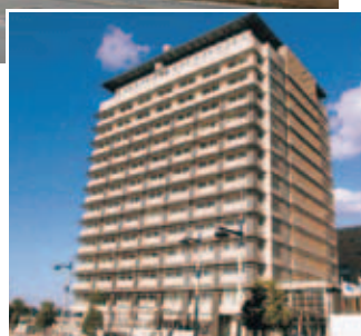
▲光触媒塗料「エヌティオ」採用例（高 松地方合同庁舎 A 棟）
