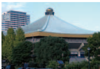
▲防水材専用遮熱塗料「ノンリークコート遮熱」採用例(日本武道館)
