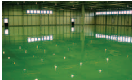
▲床用塗料（塗り床材）「ユータックE-30N」採用例 （ユニオン機工㈱三郷新工場）
