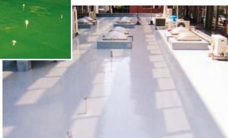
▲防水用塗料「ブルーフロンエコシステム」採用例 (麻布台ビル)
