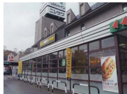
▲ガラス用遮熱塗料「NTサーモバランス」採用例(ドールベルシャイン伊那店)
