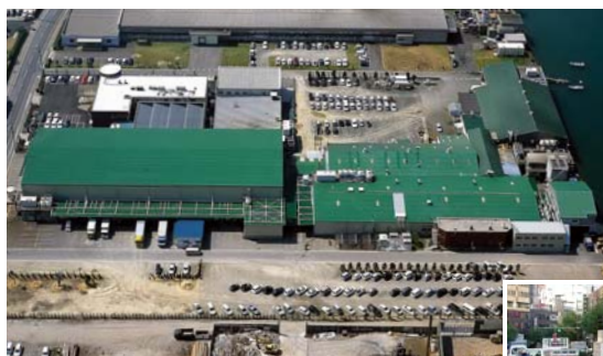
▲屋根用遮熱・断熱塗料「パラサーモシールド」採用例(サヌキ畜産加工協同組合)
