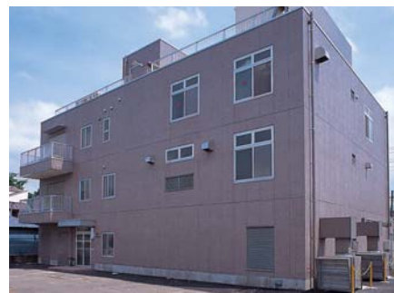
▲開発センター 塗料技術棟
