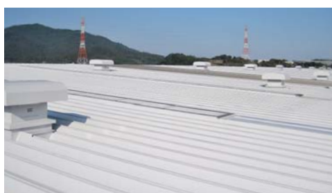
▲屋根用遮熱・断熱塗料「パラサーモシリコン」 採用例 (萩原工業(株)里庄工場)
