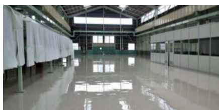
▲床用塗料(塗り床材)「ユータックE-30N」採用例(三菱重工業(株)岩塚工場第5工場)
