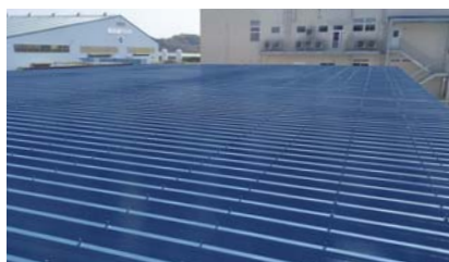
▲屋根用遮熱・断熱塗料「パラサーモシールド」 採用例（株大島造船所 第一ハウス）
