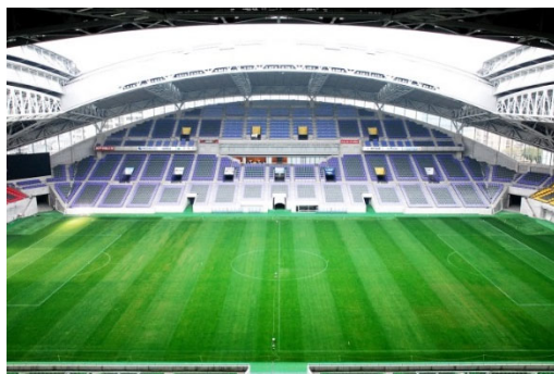
制振材「イーディケルM-3500SS」が採用された「ノエビスタジアム神戸」(ドーム屋根部分)
