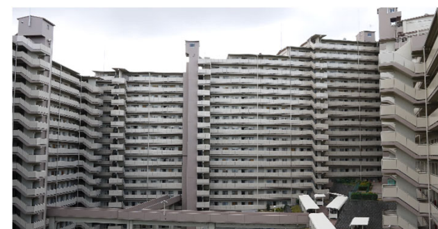
ニットクメンテ(株)によるマンション改修工事
