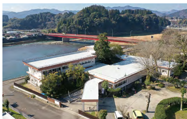
■令和元年度人吉生産性向上協創拠点整備外壁改修工事(熊本) 建築用塗膜防水材「ブルーフロン」X-1工法/635.7㎡ 建築用塗膜防水材「ブルーフロン」X-2工法/1,047.4㎡(立上り254㎡) 施工/㈱米田塗装店
