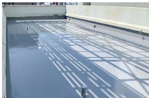
■某ホテル屋上防水改修工事(広島) 建築用塗膜防水材「ブルーフロンエコ」PN-H30S、PD-H30S/140㎡ 施工/エヌ・ティーテック㈱
