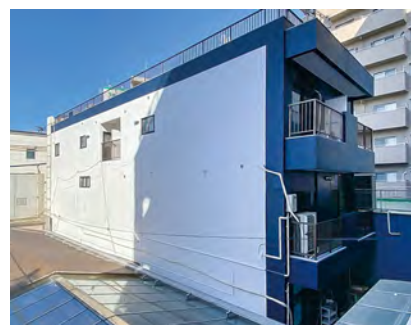
■勝呂ビル外壁改修工事(長崎) 建築外装用塗料「ハイブルーフ」上塗りフッ素仕上げ 施工/㈱スリケン・プラス
