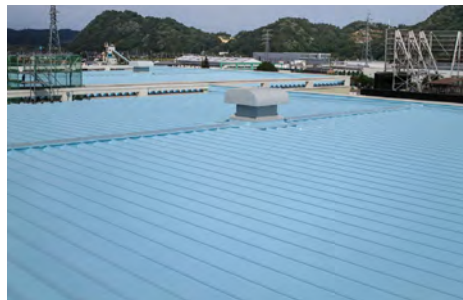
■古賀オール東北支店(宮城) 屋根用遮熱塗料「パラサーモフッ素」/15,000㎡ 建設/ケーアンドイー㈱ 東北支店 施工/㈱建装テクノ
