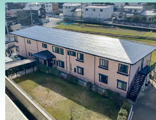
■大分市某クリニック屋根改修工事(大分) 万能下塗り塗料「エポラオールプライマー」ホワイト遮熱 +屋根用遮熱塗料「パラサーモシリコン」 ココナツ/424㎡ 施工/㈱佐藤塗工
