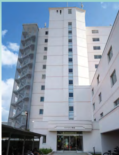
■スカイビル高台Ⅰ(北海道) 建築外装用塗料「ハイフルーフ」/1,378.7㎡ 施工/㈱星塗装工業
