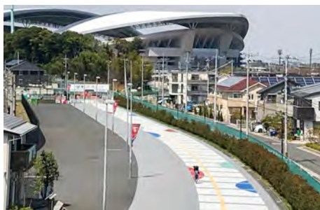
■埼玉スタジアム2002公園施設整備工事(埼玉) 塗り床材「ユータックテクノONE」/7,200㎡ 建設/斉藤建設工業㈱ 施工/世紀東急工業㈱
