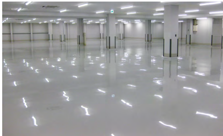
■門真物流センター(大阪) 塗り床材「ユータックE-30N」ハード流し展べ工法/6,800㎡ 建設/雄健建設㈱ 施工/アサヒカラコン㈱
