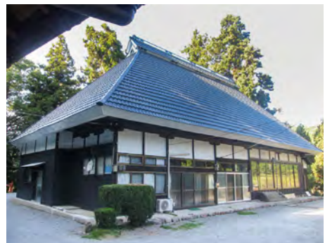
■丸小野寺改修工事(福岡) 万能下塗り塗料「エボラオールプライマー」+屋根用塗料「リリーフNADシリコン」/500㎡ 施工/水江塗装
