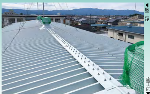
■三光滋賀工場(滋賀) 屋根用遮熱塗料「パラサーモシールド」(パラサーモシリコン仕上げ)/850㎡ 施工/㈱コーケン
