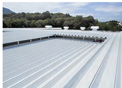
■テクノハマ 工場および事務棟屋根塗装工事(愛知) 屋根用遮熱塗料「パラサーモシリコン」 工場屋根/7,982.1㎡ 事務棟屋根/1,297㎡ 建設/㈱眞栄 施工/㈱市川塗工店
