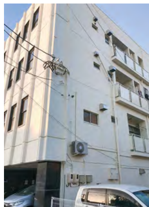
■バステルクボ外壁改修工事(山口) 建築外装用塗料「シルビアセラティ-N」/800㎡ 施工/㈱日光
