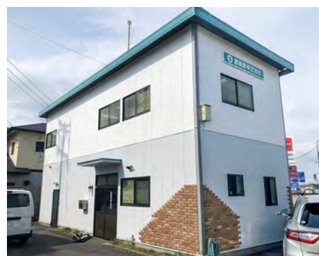
■営産業事務所外壁塗装工事(熊本) 建築外装用塗料「シルビアセラティーN」/150㎡ 建設・施工/営産業(株)
