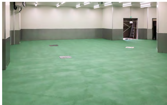
■CCS冷凍倉庫(大阪) 塗り床材「ユータックコンプリート」CPL-6N(新パウダー)/200㎡ 建設/㈱三共冷熱 施工/㈱マエタ化研
