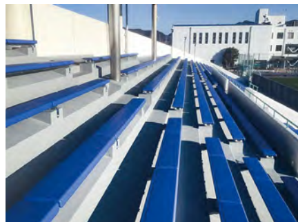
■某球技場メインスタンド棟改修工事(兵庫) 超速硬化塗膜防水材「NTスプレータイプH」NS-SH30UTR/NS-SH20UTR立上り 建設/㈱ホリエ 施工/棚田建材㈱姫路営業所
