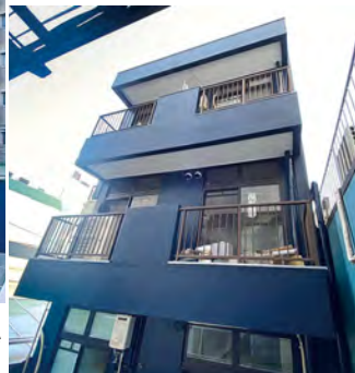
■勝呂ビル外壁改修工事(長崎) 建築外装用塗料「ハイブルーフ」上塗りフッ素仕上げ 施工/㈱スリケン・プラス
