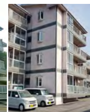
■タウンパーク寿(鹿児島) 建築外装用塗料「シルビアセラティーN」/800㎡ 建設・施工/㈱アリドメ
