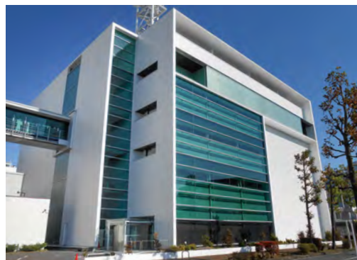
■SBS放送センター(静岡) 建築外装用塗料「シルビア1液ハイブリッドセラ」/3,500㎡ 建設/静鉄建設㈱ 施工/岡田工業㈱
