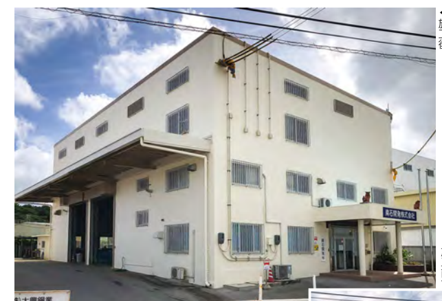
■カミヤマ美研 西原貸倉庫外壁改修工事(沖縄) 建築外装用塗料「シルビアセラティーN」/790㎡ 建設・施工/㈱オキナワ技研
