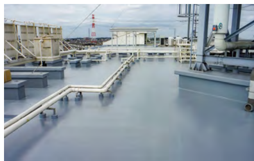
■船橋二和病院中病棟(東側部分)屋上防水改修工事(千葉) 超速硬化塗膜防水材「NTスプレー」NN-SS30WS工法/1,300㎡ 建設・施工/㈱うつくしき塗装
