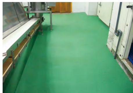
■山梨罐詰(静岡) 塗り床材「ユータックコンプリート」CPL-8N工法/300㎡ 建設/㈱ティ・シー・アイ 施工/㈱マイスター技研
