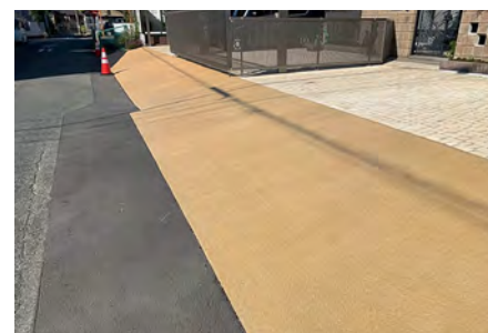
■原塗装店自宅前通路(愛知) 塗り床材「ユータックオリゴマー」景観舗装工法/60㎡ 施工/㈱大幸
