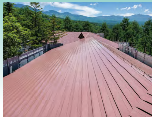
■夢科東急リゾートヴィラ大規模修繕工事(長野) 建築屋根用遮熱塗料「パラサーモシリコン」1D棟/1,032㎡ 1F棟/1,104㎡ 元請/日之出建工㈱ 施工/㈱五十鈴
