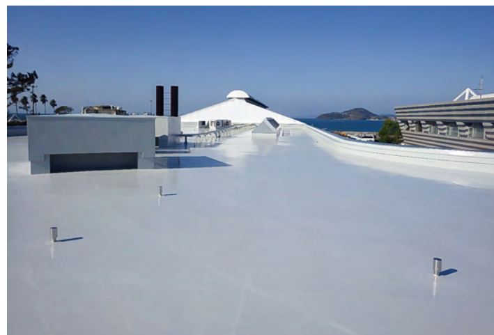
■水産研究センター本館棟他屋上防水改修工事(熊本) 建築用塗膜防水材「ブルーフロン」X-1工法/4,071.9㎡ 施工/営産業(株)
