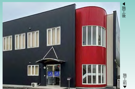
■佐賀市某店舗塗装改修工事(佐賀) 建築外装用塗料「シルビアNADシリコン」/700㎡ 屋根用塗料「ピチューロン」/600㎡ 施工/庄司塗装
