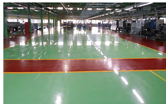
■磯貝製作所西尾工場新築床工事(愛知) 塗り床材「ユータックE樹脂モルクリヤー」(4mm厚) + 塗り床材「ユータックE-30N」(平滑1.5mm、防滑1.5mm)/2,200㎡ 建設・施工/㈱筒井施工
