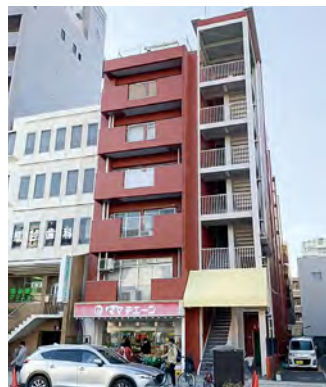
■某マンション外壁塗装(広島) 建築外装用塗料「シルビアWS-300」/1,800㎡ 施工/㈱長崎塗装店
