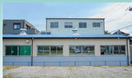
■神谷精密外壁工事(愛知) 屋根用遮熱塗料「パラサーモシールド」(パラサーモフッ素仕上げ)/853㎡ 外装用微弾性断熱塗料「NTダンネツベース」+建築外装用遮熱塗料「パラサーモシリコン外壁用」/300㎡ 建設・施工/㈱第一塗装店
