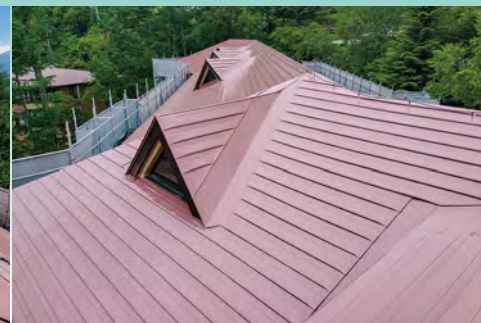
■夢科東急リゾートヴィラ大規模修繕工事(長野) 建築屋根用遮熱塗料「パラサーモシリコン」1D棟/1,032㎡ 1F棟/1,104㎡ 元請/日之出建工㈱ 施工/㈱五十鈴
