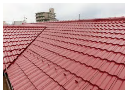
■戸建住宅屋根(愛知) 屋根用塗料「NTスラリー瓦塗り替え工法」/180㎡ 施工/名倉塗装
