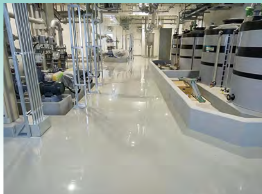
■当麻浄水場建築主体工事(北海道) 塗り床材「ユータックE-30ECO」ハード流し展べ工法/479㎡ 塗り床材「ユータックVE-100」2プライミング工法/122㎡ 塗り床材「ユータックWE-400N」コーティング工法/187㎡ 建設/大野・西森経常建設共同企業体 施工/㈱アイ・ディー・エフ
