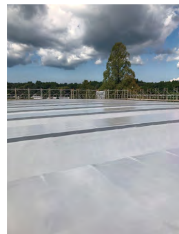
■曾教2~8財部小学校屋内運動場非構造部材耐震化改修工事(鹿児島) 建築用塗膜防水材「ブルーフロンエコHG」X-2相当仕様/875㎡ 設計/春田設計 建設/㈱山田建設 施工/㈱有明塗装店
