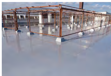
■千葉県警察学校生徒寮屋上防水改修工事(千葉) 建築用塗膜防水材「ブルーフロンバリュー」X-1工法/1,160㎡ 建築用塗膜防水材「ブルーフロンバリュー」X-2工法/298㎡ 施工/大和興業㈱
