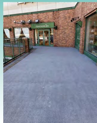
■長崎市某商業施設通路改修工事(長崎) カラー舗装材「ユータックUグラウンドコート」(ユータックFT仕上げ)/85㎡ 施工/㈱丸菱工業
