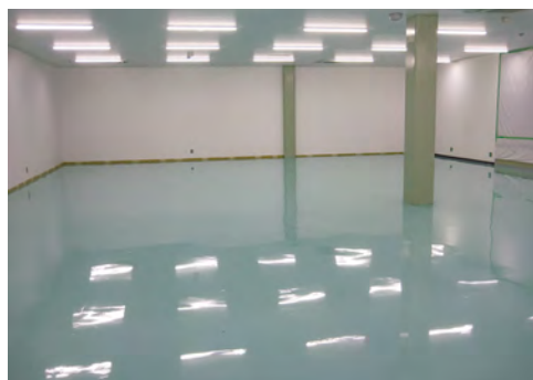
■某工場拡張工事(岡山) 塗り床材「ユータッククリーンE厚膜」SD-1工法/287㎡ 施工/山樹エンジニアリング㈱
