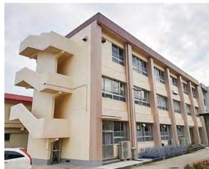
■長門石小学校教室棟外壁改修工事(福岡) 外装用断熱塗料「NTダンネツコート」+建築外装用遮熱塗料「水性パラサーモ外壁用」/825㎡ 施工/コモダ塗装㈱
