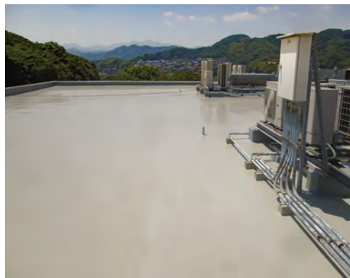
■九州職業能力開発大学校C棟屋上防水改修その他工事(福岡) 塗膜防水材「ブルーフロン」PK-HG30G/1,000㎡ 施工/エイケン塗装工業
