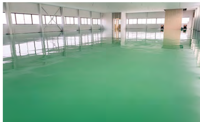
■旭製作所床改修工事(愛知) 塗り床「ユータックE-30N」樹脂モルタル流し展べ工法/1,000㎡ 施工/㈱愛知レジン
