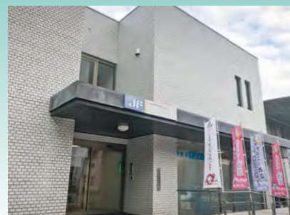
■佐伯市某組合建物外壁改修工事(大分) 建築外装用塗料「タイルレシスト」標準工法/100㎡ 施工/広津留塗装
