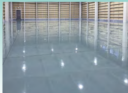
■㈱サンジェニックス砺波工場(富山) 塗り床材「ユータックE-30Nローラー用」コーティング工法/400㎡ 施工/㈱北陸装研
