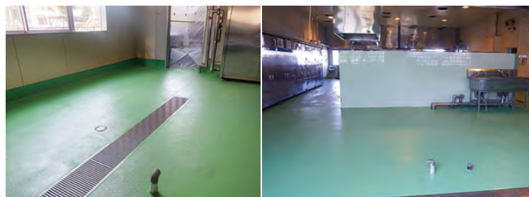
■玖珠町某学校給食センター(大分) 塗り床材「ユータックE-30N」ハード流し展べ防滑工法/300㎡ 施工/梶原塗装(有)
