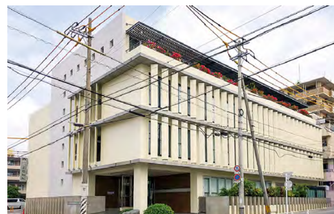
■医療法人がじまる会糸数病院外壁改修工事(沖縄) 建築外装用塗料「シルビアセラティーN」/2,350㎡ 建設・施工/㈱オキナワ技研
