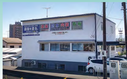
■大和塗装事務所外壁塗装工事(佐賀) 建築外装用塗料「シルビアセラティーN」/250㎡ 施工/大和塗装(株)
