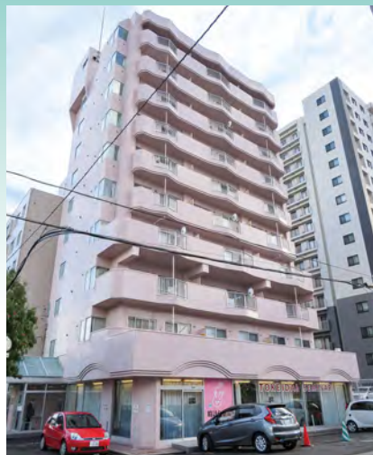
■サンシャイン夢似(北海道) 建築用塗膜防水材「ブルーフロン」PM-V20G工法/754㎡ 施工/㈱星塗装工業
