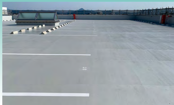
■某屋上駐車場防水改修工事(広島) 超速硬化塗膜防水材「NTスプレータイプH」NC-SH30UTR/1,155㎡ 超速硬化塗膜防水材「NTスプレータイプH」NC-SH20UTR立上り/152㎡ 施工/㈱ポリテクノ
