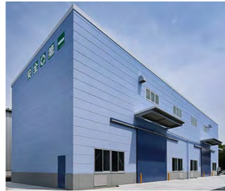
■株式会社 加西工場新設工事(兵庫) 高弾性外壁防水塗料「ハイブルーフ」標準工法ハイブルーフ上塗フッ素仕上げ/960㎡ 施工/株式会社
