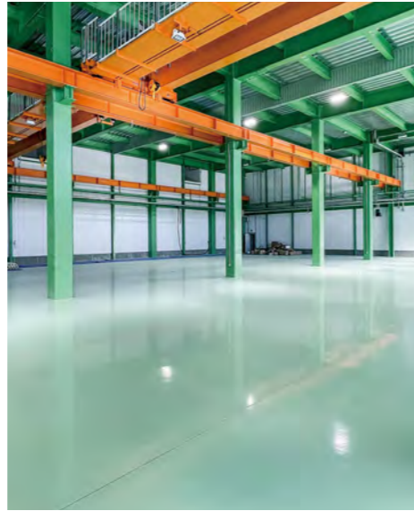
■自動車関連部品成型工場新築工事(愛知) 塗り床材「ユータックE-40」コーティング工法/5,000㎡ 施工/株式会社
