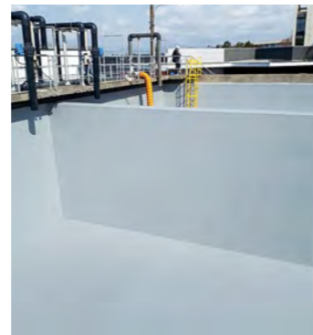
■某工場防食工事(熊本) 防食被覆材「タフバリア#200」C-5工法 /970㎡ 施工/株式会社河川コーポレーション
