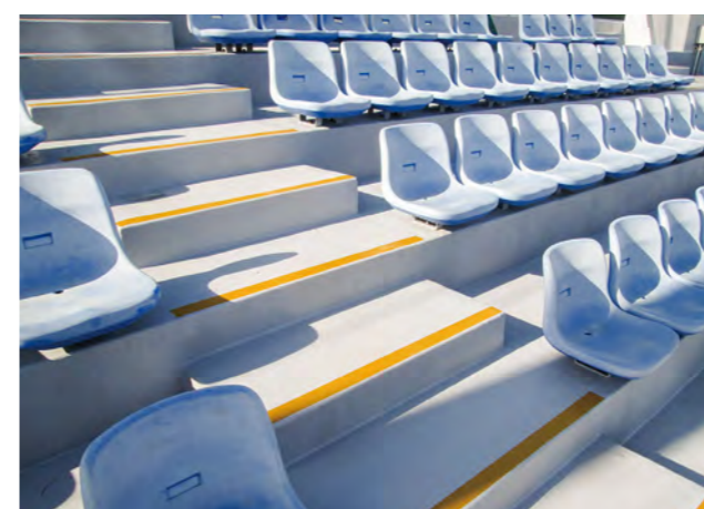
■鳥栖市民球場スタンド・内装改修工事(建築工事)(佐賀) FRP防水材「タフシール」TS-I工法/870㎡ 建設/今泉建設㈱ 施工/林保冷工業㈱
