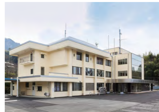
■鳥取市用瀬町総合支所外壁塗装工事(鳥取) 弾性タイプ断熱塗料「NTダンネツコート」建築外装用遮熱塗料「水性パラサーモ外壁用」/1,291㎡ 施工/株式会社
