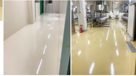
■株式会社 八尾久宝寺給食センター新築工事(大阪) 水性硬質ウレタン樹脂系塗り床材「ユータックコンプリート」CPG-4F工法/1,220㎡ 水性硬質ウレタン樹脂系塗り床材「ユータックコンプリート」CPGL-6N工法/190㎡ 建設/中川企画建設株式会社 施工/アサヒカラコン株式会社
