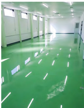
■某倉庫塗り床工事(熊本) 塗り床材「ユータックE-30N」ハード流し 展べ工法(U-76)/1,200㎡ 施工/株式会社河川コーポレーション
