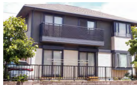
■周南市某戸建外壁改修工事(山口) 建築外装用塗料「シルビアセラティー-N」 半艶仕上げ/200㎡ 施工/㈱日光
