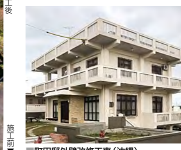
■町田邸外壁改修工事(沖縄) 建築外装用塗料「シルビアセラティーン」 /806.4㎡ 建設・施工/株式会社河川コーポレーション
