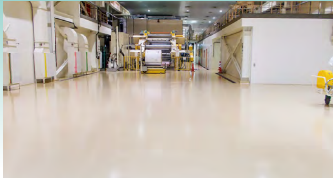
■三菱製紙北上事業所 5RC棟1RL床塗装工事(岩手) 塗り床材「ユータッククリーンE厚膜」SD-1工法/252㎡ 塗り床材「ユータッククリーンE」SD-2工法/1,118㎡ 建設/三菱製紙エンジニアリング(株) 施工/㈱TERUI
