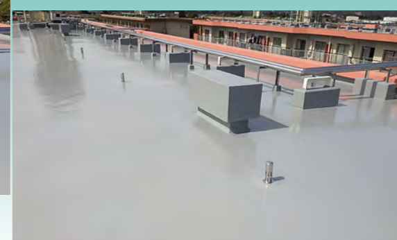
■宮崎県宮永山団地屋上防水改修工事(宮崎) 建築用塗膜防水材「ブルーフロンバリュウ」X-1工法/1,167㎡ 建設・施工/有エイエフ工業
