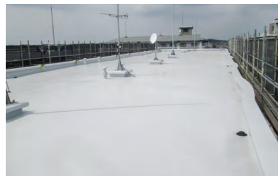
■レフティヒルズ奈多屋上防水改修工事(福岡) 建築用塗膜防水材「ブルーフロンエコHG」PM-HG20S工法/670㎡ 施工/㈱コウケン工業
