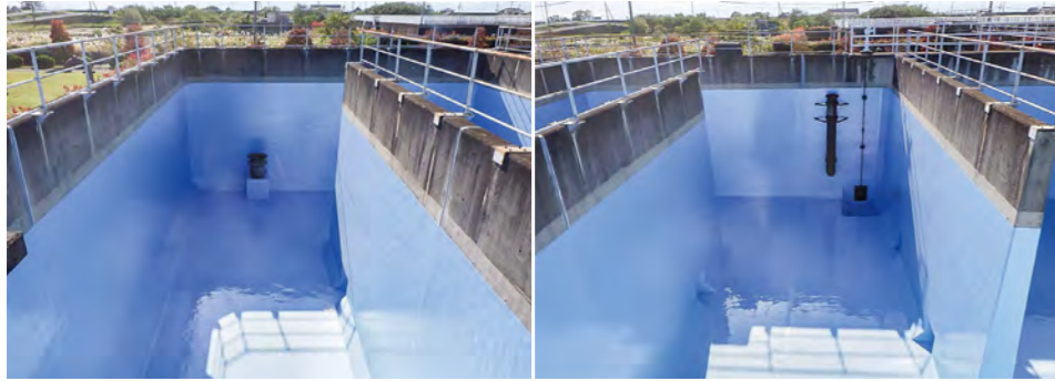
■東毛工業用水道(群馬) 水道用コンクリート水槽内面保護塗料「ガードブルーF」/2,000㎡ 施工/㈱サンテック
