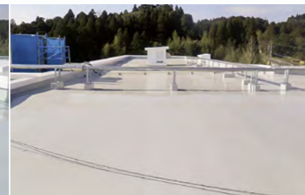
■宮崎県宮永山団地屋上防水改修工事(宮崎) 建築用塗膜防水材「ブルーフロンバリュウ」X-1工法/1,167㎡ 建設・施工/有エイエフ工業
