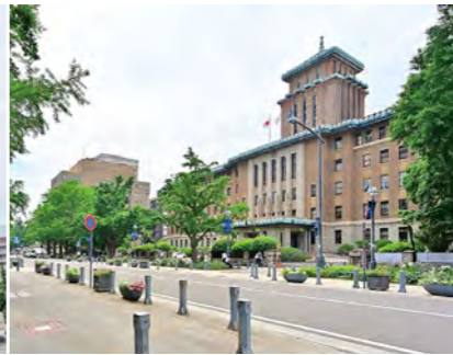
⑭神奈川県庁本庁舎。正面屋上の塔は「キングの塔」とも呼ばれる。国指定重要文化財。
