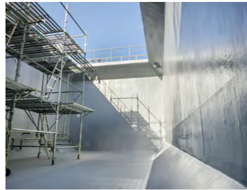
■物産フードサイエンス名古屋工場 第二曝気槽FRP改修工事(愛知) 断面修復用モルタル「シヨクイック」/1,200㎡ 防食被覆材「タフバリア」#200 D種/1,200㎡ 施工/株式会社
