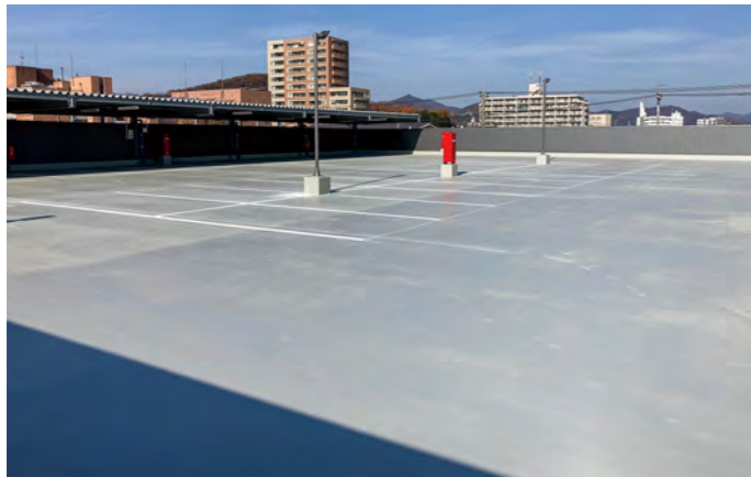
■某店舗屋上駐車場(群馬) 超硬化塗膜防水材「NTスプレータイプH」NC-SH30UTR工法/1,815㎡ 施工/㈱テッシン
