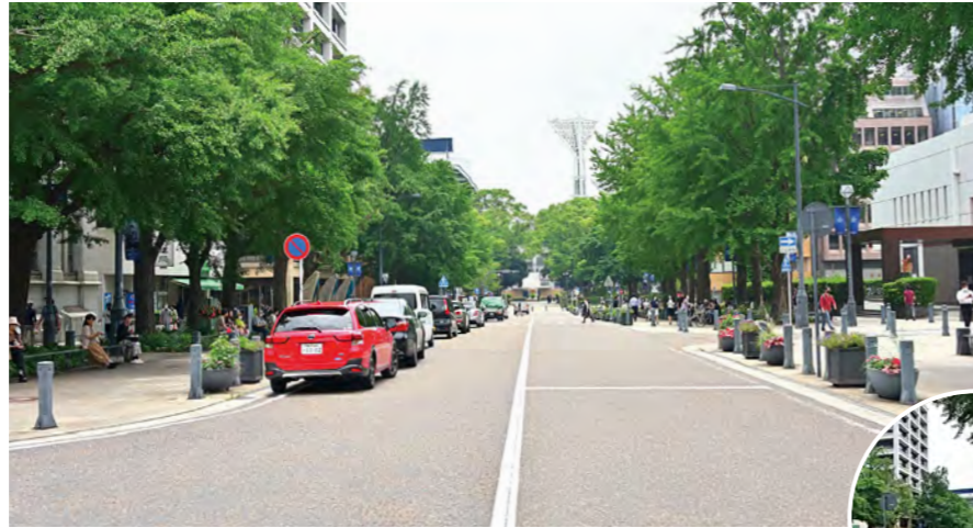
⑧日本大通り。慶応大火を機に大規模な区画整理が行なわれ、日本初の西洋式街路として完成した。車道幅12m、その両側の植樹帯・歩道幅も12mで、広い空間は防火帯も兼ねた。
