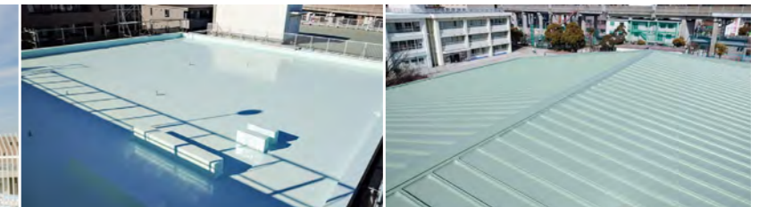
■川崎市某小学校(神奈川) 建築用塗膜防水材「ブルーフロンエコ」X-1断熱機械固定工法/910㎡ 超硬化塗膜防水材「NTスプレータイプS」鋼板屋根仕様/770㎡ 施工/福吉塗装(株)
