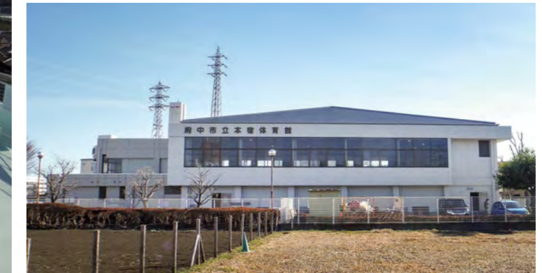
■本宿体育館外壁及び屋上防水等維持改修工事(東京) 建築外装用塗料「シルビアサーフ+シルビアWF#400」/800㎡ 超硬化塗膜防水材「NTスプレータイプS」NY-SS30ES工法/920㎡ 建築用塗膜防水材「ブルーフロンバリュー」X-2工法/400㎡ 設計/府中市役所 元請会社/田丸屋建設(株)
