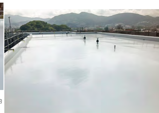
■長崎市某マンション屋上防水改修工事(長崎) 建築用塗膜防水材「ブルーフロンエコ」PKD工法(機械的 固定・断熱・遮熱工法)/400㎡ 施工/㈱中野防水工業
