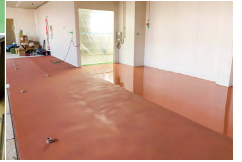
■寺田薬業工業株新築工事(京都) 塗り床材「ユータックE-30N」ハード流し展べ工法/300㎡ 施工/古賀工業株式会社
