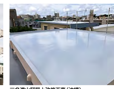
■名渡山邸屋上改修工事(沖縄) 建築用塗膜防水材「ブルーフロンバリュウ」 X-2工法/161.2㎡ 建設・施工/株式会社河川コーポレーション
