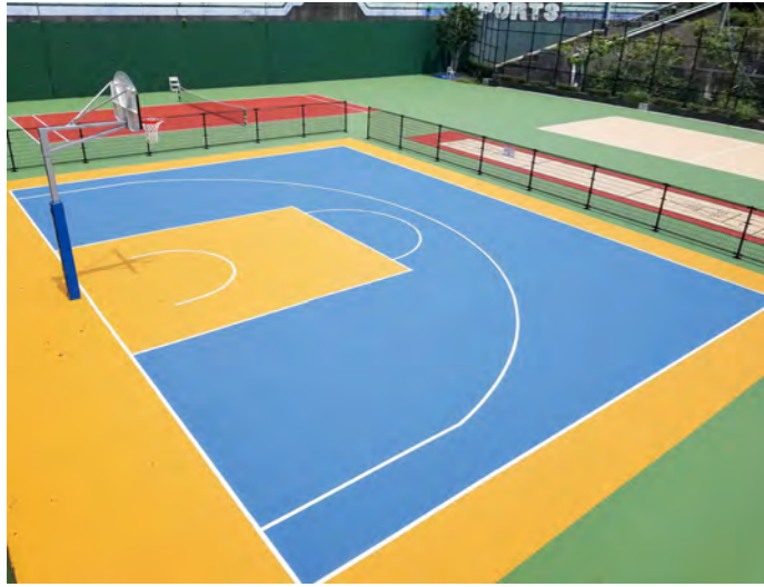
■焼津グランドホテル スポーツコート(静岡) カラー舗装材「水性ユータックAS」コーティング軽防滑仕様/1,070㎡ 施工/株式会社
