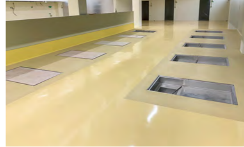
■株式会社 八尾久宝寺給食センター新築工事(大阪) 水性硬質ウレタン樹脂系塗り床材「ユータックコンプリート」CPG-4F工法/1,220㎡ 水性硬質ウレタン樹脂系塗り床材「ユータックコンプリート」CPGL-6N工法/190㎡ 建設/中川企画建設株式会社 施工/アサヒカラコン株式会社
