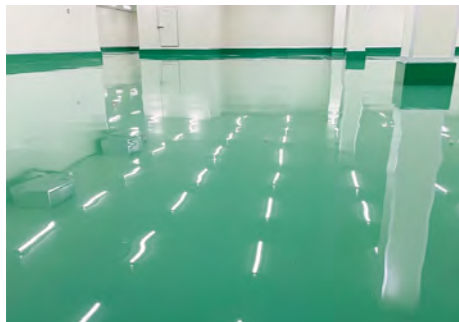
■某工場床(群馬) 塗り床材「ユータックE-30N」/300㎡ 施工/㈱タナカペインティング
