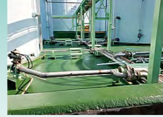
■V・J硫酸タンク防液提塗装工事(三重) 塗り床材「ユータックVE-100」2プライ工法ユータックR仕上げ/1452.6㎡ 塗り床材「ユータックVE-100」フレック工法ユータックR仕上げ/70.2㎡ 設計・建設/HMPLAN株式会社 施工/ライニング技術工業株式会社
