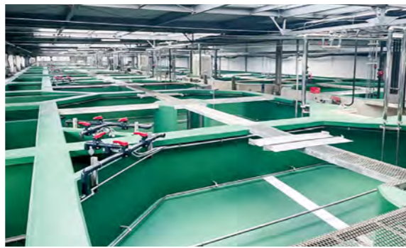
■某鮎飼育場(岐阜) FRP防水材「タフシール」TSF-JW工法/5,000㎡ 設計/岐阜県 建設/株式会社 施工/株式会社
