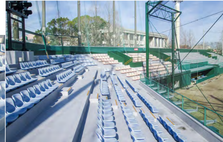
■鳥栖市民球場スタンド・内装改修工事(建築工事)(佐賀) FRP防水材「タフシール」TS-I工法/870㎡ 建設/今泉建設㈱ 施工/林保冷工業㈱
