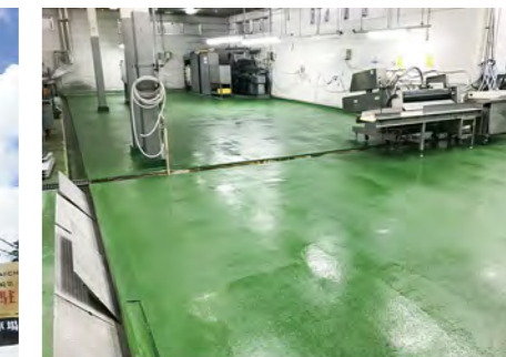
■鹿児島くみあいチキンフーズ株式会社川内食品 工場加工室塗り床改修工事(鹿児島) 水性硬質ウレタン樹脂系塗り床材「ユータ ックコンプライド」防滑工法/297㎡ 施工/株式会社河川コーポレーション
