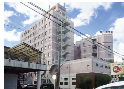
■第一ホテル新館10階屋上防水改修工事(宮崎) 建築用塗膜防水材「ブルーフロンバリュウ」X-1工法/305㎡ 建設・施工/有エイエフ工業
