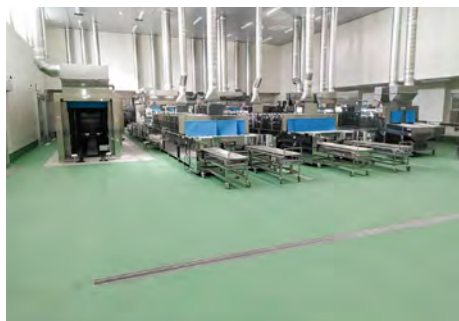
■安城北部学校給食共同調理場(愛知) 水性硬質ウレタン樹脂系塗り床材「ユータックコンプリート」CPL-6N/550㎡ 水性硬質ウレタン樹脂系塗り床材「ユータックコンプリート」CPMT-4N工法/40㎡ 塗り床材「ユータックE-30N」流し展べ防滑工法 T=2/900㎡ 設計/安城市 建設/株式会社 施工/株式会社、株式会社
