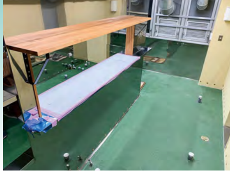
■藤沢鶴庵厨房床工事(神奈川) 水性硬質ウレタン樹脂系塗り床材「ユータックコンプリート」CPM-4N工法/約20㎡ 施工/株式会社、株式会社
