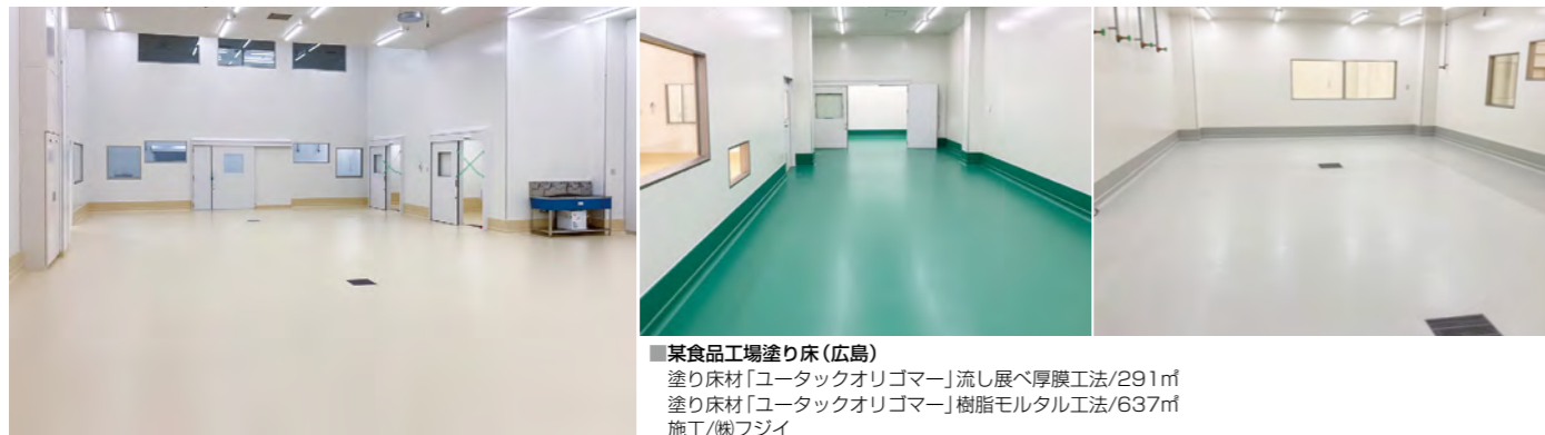
■某工場塗り床工事(徳島) 塗り床材「ユータックE-30N」流し展べ工法/900㎡ 施工/㈱下村塗装
