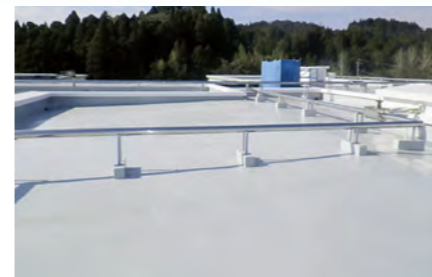
■宮崎市立加納小学校屋上防水改修工事(宮崎) 建築外装用塗料「ブルーフロンバリュウ」X-1工法/1,145㎡ 建設・施工/有エイエフ工業
