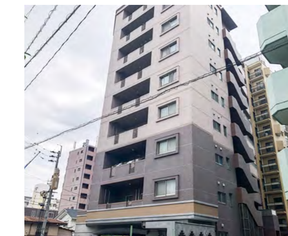
■ハイボネール水前寺二丁目大規模修繕工事(熊本) 建築外装用塗料「シルビアサーフ+シルビアWS#300」/2,127㎡ 建築外装用塗料「エポラオールプライマー+シルビアNADシリコン」 /73.3㎡ 建築用塗膜防水材「ブルーフロン」X-2工法/97㎡ 設計/有隣建築設計事務所 建設・施工/株式会社ミカド
