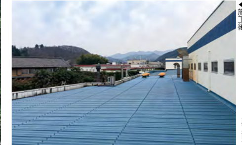
■日本イースード(株)本社工場(埼玉) 金属屋根用塗料「マッキンレーN」/500㎡ 施工/㈱日本アステック
