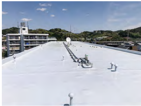
■某マンション屋上防水工事(愛知) 建築用塗膜防水材「ブルーフレコDX」PK-D30S工法/550㎡ 建築用塗膜防水材「ブルーフレコDX」PGT-D20S(立上り)/50㎡ 施工/株式会社
