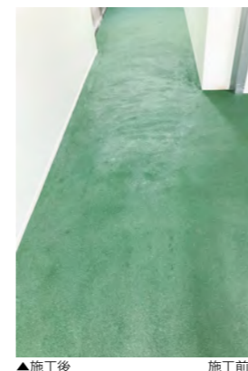
■某食品工場床改修 工事(宮崎) 水性硬質ウレタン 樹脂系塗り床材 「ユータックコンプ リット」CPL-6N 工法/30㎡ 建設・施工/株式会社 河川コーポレーション
