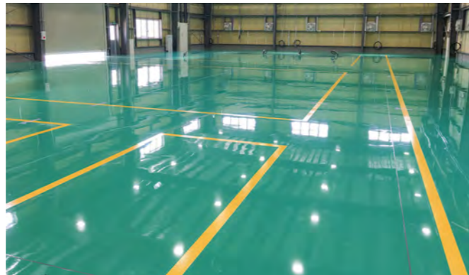
■某精密機器工場床(群馬) 塗り床材「ユータックE-30N」コーティング工法/800㎡ 施工/㈱栄塗技建埼玉
