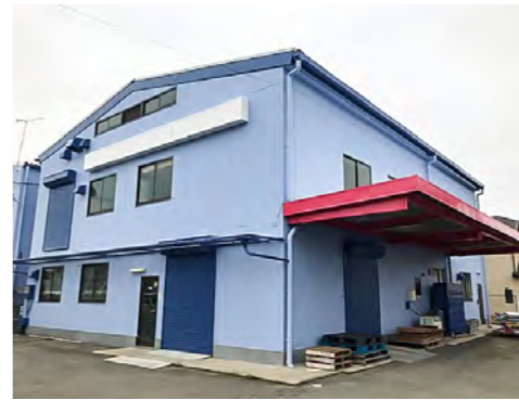
■株式会社 坂井倉庫(兵庫) 高弾性外壁防水塗料「ハイブルーフ」標準工法ハイブルーフ上塗フッ素仕上げ/760㎡ 施工/株式会社
