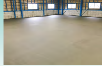
■某化粧品倉庫床(埼玉) 下地処理兼用プライマー「NTミラクルファイラー」 塗り床材「ユータックスーパーFハードN」ハード 流し展べ工法/500㎡ 施工/㈱栄塗技建埼玉
