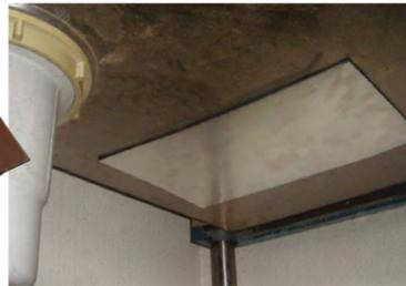
流し台の裏側から、圧着することにより、騒音を低減する効果が期待できます。ステンレス製流し台は水がシンクに当たる「ザーザー音」、また熱湯を流したときに素材膨張による「ポコーン」というような騒音が発生します。このような騒音は
