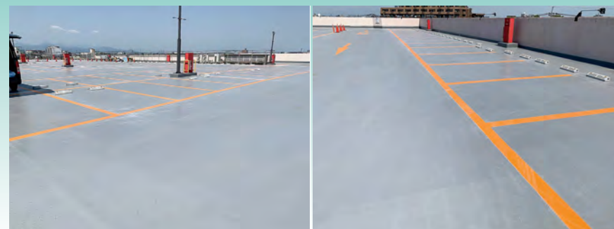
■MEGAドン・キホーテUNY本店(埼玉) 超速硬化ウレタ・ウレタン系塗膜防水材スプレーシステム「NTスプレータイプS」NC-SS30UTR工法/6,000㎡ 施工/㈱デッシン
