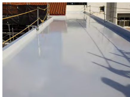
■ 福岡市立福岡女子高等学校校舎屋上改良工事 (福岡) 建築用塗膜防水材「ブルーフロンエコHG」PX- HG30G工法 (平場) /1,253.1㎡ 施工/㈱EST
