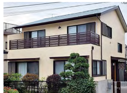
■内海様邸塗り替え改修工事(神奈川) 屋根用遮熱塗料「パラサーモフッ素」+下塗り「エポラ オールプライマー」/120㎡ 建築外装用塗料「パラサーモフッ素外壁用」+下塗り 「NTダンネツベース」/210㎡ 建築用塗膜防水材「ブルーフロンバリュー」PN-V30 ES工法/20㎡ 施工/㈱ナカムラ
