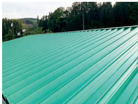
■新日本緑地㈱屋根改修工事(大分) プライマー「エポオールプライマー」+建築外装用塗料「リリーフNADシリコン」/800㎡ 施工/㈱高倉塗装
