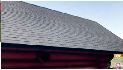
■竹田市某研修施設(大分) 「シングルプライマー」+「水性ルーフシリコンNEO(ブラック)」アスファルトシングル工法/1,300㎡ 施工/日装
