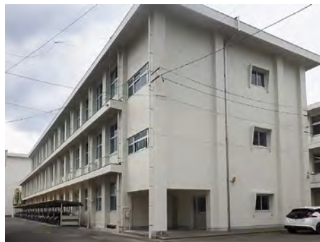
■宮崎県立宮崎工業高等学校(宮崎) 建築用塗膜防水材「ブルーフロンバリュー」X-1工法/540㎡ 建築用塗膜防水材「ブルーフロンバリュー」X-2工法(立上り)/76㎡ 施工/㈱エイエフ工業
