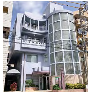
■令和3年度市営住宅外壁落下防止等改修工事(佐大熊改良7号棟)(鹿児島) ポリマーセメント系塗膜防水材「ブルーフロンアクア」仮防水兼下地調整仕様/236㎡ 建築用塗膜防水材「ブルーフロンエコHG」PK-HG30S工法(X-1機械的固定工法) 建設/㈱愛建工業 施工/㈱有村防水
