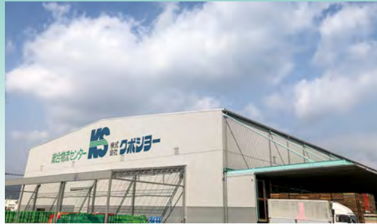
■㈱クボショー物流倉庫改修(佐賀) 金属屋根用塗料「ビチューロンシルバー」/8,300㎡ 建築外装用塗料「シルビアNADシリコン」(鋼板壁部)/3,600㎡ 建築外装用塗料「シルビアNADシリコン」(鉄骨部)/1,300㎡ 施工/林保冷工業㈱
