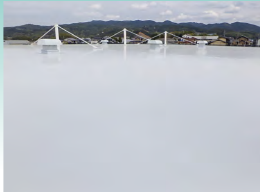
■マルゼングループ広川インター倉庫改修工事(福岡) 建築用塗膜防水材「ブルーフロンバリュー」密着工法/6,000㎡ 施工/㈱EST
