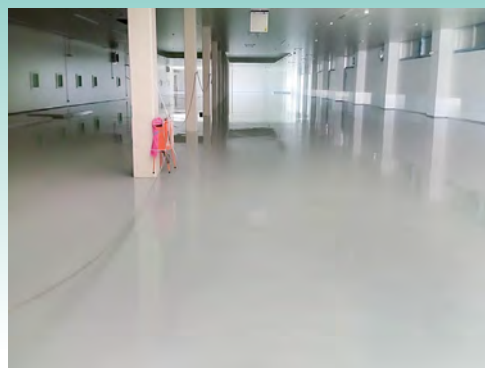
■ 某工場塗り床工事 (新潟) 塗床材「ユータックE-30N」ハード流し展べ工法 /2,000㎡ 施工/㈱タナカペインティング
