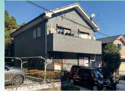
■都城市個人住宅(宮崎) 建築外装用塗料「シルビアセラティーN」/140㎡ 施工/㈱深港美装
