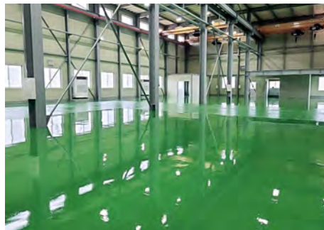
■杉原エンジニアリング本社新築工事(展示場)(長崎) 水性硬質ウレタン系塗り床材「ユータックコンプリート」CPGU-3F工法/688㎡ 水性硬質ウレタン系塗り床材「ユータックコンプリート」CPGU-3N工法/278㎡ 施工/㈱マルハギ創建
