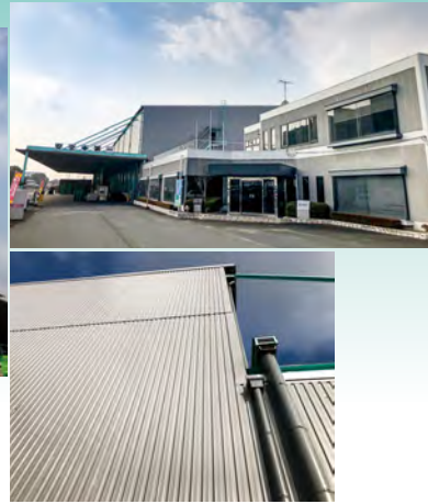
■㈱クボショー物流倉庫改修(佐賀) 金属屋根用塗料「ビチューロンシルバー」/8,300㎡ 建築外装用塗料「シルビアNADシリコン」(鋼板壁部)/3,600㎡ 建築外装用塗料「シルビアNADシリコン」(鉄骨部)/1,300㎡ 施工/林保冷工業㈱
