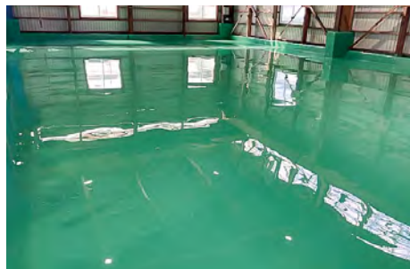
■林精鋼鉄塗り床工事(群馬) 塗り床材「ユータックE-30N」ハード流し展べ工法/350㎡ 施工/㈱井上建装
