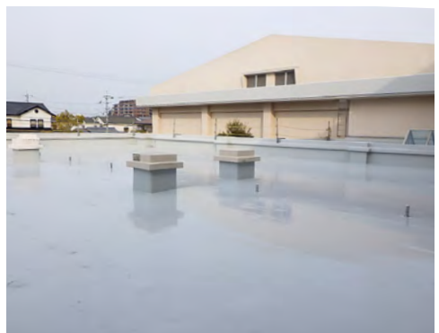
■ 福岡市立飯倉中央小学校屋上改修 (福岡) 建築用塗膜防水材「ブルーフロンエコDX」PK工法 (平場) /460㎡ 建築用塗膜防水材「ブルーフロンエコHG」PM工法 (立上り) /100㎡ 施工/㈱EST
