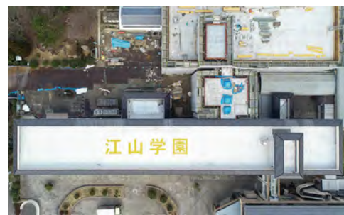
■ 江山学園新築工事屋上ヘリサイン (鳥取) プライマー「NT塩ビシートプライマー」+ 建築用塗膜防水材用トップコート「ブルーフロンGRトップ」 施工/山陰東陽化成㈱
