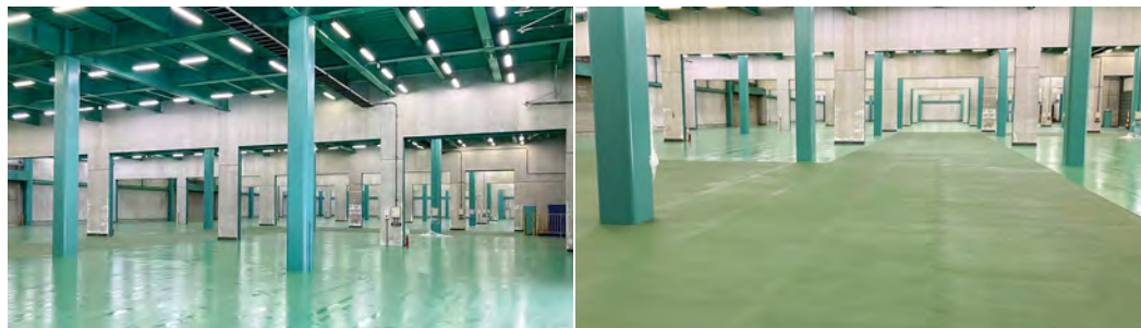
■ホームロジスティクス所沢DC(埼玉) 塗り床材「ユータックR」/10,000㎡ 水性硬質ウレタン系塗り床材「ユータックコンプリート」CPM-5N工法/650㎡ 施工/㈱アイエフ
