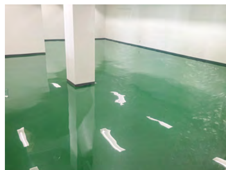
■ 株信栄テクノス帯電防止床改修工事 (京都) 塗床材「ユータッククリーンE厚膜」SD-1工法/150㎡ 建設/㈱BSKシステム 施工/㈱Ha-ya-te
