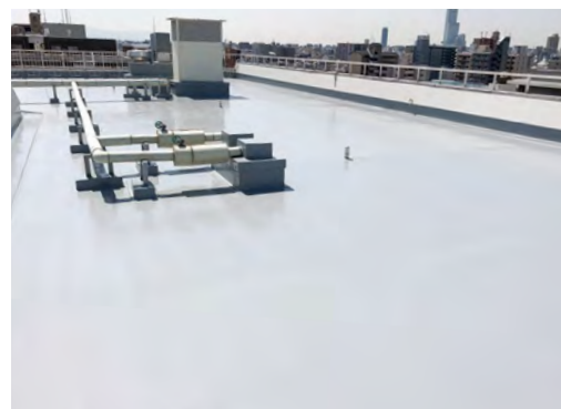
■ メトロハイム今里防水改修工事 (大阪) 建築用塗膜防水材「ブルーフロンエコ」X-1工法/500㎡ 建設/㈱ commons 施工/山下塗装
