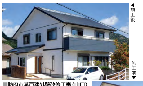
■ 防府市某戸建外壁改修工事 (山口) 建築外装用塗料「シルビアセラテ ィーN」5分艶仕上げ/200㎡ 施工/㈱日光
