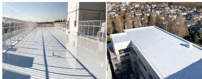
■川崎市某小学校②(神奈川) 建築用塗膜防水材「ブルーフロンエコ」X-1断熱機械固定工法/1,380㎡ 建築用塗膜防水材「ブルーフロンエコ」X-2工法/424.5㎡ 施工/㈱山口塗装
