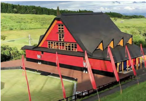
■竹田市某研修施設(大分) 「シングルプライマー」+「水性ルーフシリコンNEO(ブラック)」アスファルトシングル工法/1,300㎡ 施工/日装
