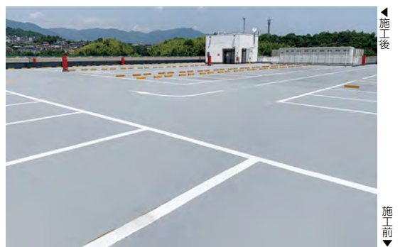
■ 某商業施設屋上駐車場防水現場 (広島) 超速硬化ウレタ・ウレタンゴム系塗膜防水 材スプレーシステム「NTスプレータイプH」 NC-SH30UTR工法/2356.6㎡ 超速硬化ウレタ・ウレタンゴム系塗膜防水 材スプレーシステム「NTスプレータイプH」 NC-SH20UTR工法 (立上り) /156.5㎡ 施工/㈱ポリテクノ
