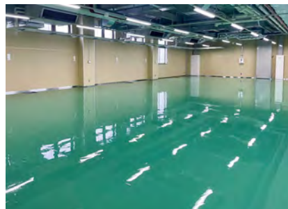
■三進興産㈱(埼玉) 塗り床材「ユータックE-30N」ハード流し展べ 工法/850㎡ 施工/㈱井上建装
