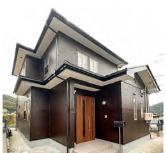
■ T様邸戸建外壁改修工事 (山口) 建築外装用塗料「シルビアセラテ ィーN」 /200㎡ 施工/光塗装㈱
