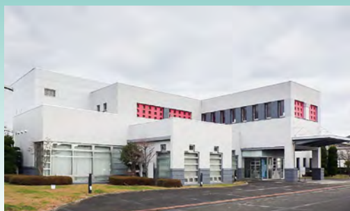
■天童市美術館外装改修工事(山形) アクリルゴム系壁面防水化粧材「ハイブルーフ」標準工法 (玉吹大模様)/1,000㎡ 施工/㈱太田塗装店
