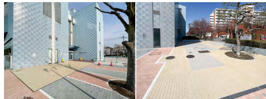
■荒川遊園B地区外1箇所整備その他工事(東京) 塗り床材「ユータックオリゴマー」景観舗装工法/235㎡ 塗り床材「ユータックオリゴマー」流し展べ防滑工法/210㎡ 建設/北部緑地㈱ 施工/共栄造園㈱
