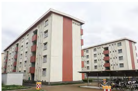
■宮崎市花ヶ島団地(宮崎) 建築用塗膜防水材「ブルーフロンバリュー」X-1工法(平場)/570㎡ 施工/㈱エイエフ工業
