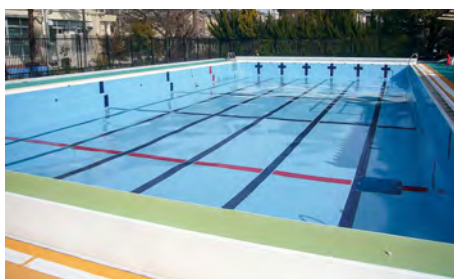
■ 京都市立花園小学校プール改修工事 (京都) プール用塗料「プールエース」PEU-1工法/450㎡ 建設/㈱日建 施工/㈱マエダ化研
