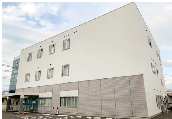
■足利銀行宇都宮東支店外壁改修工事(栃木) 建築外装用塗料「シルビアWS300」/1,000㎡ 建築外装用塗料「シルビアNADシリコン」/200㎡ 陶磁器タイル用クリアー塗料「タイルピカ」艶消し仕上げ/100㎡ 建設/㈱カナメ 施工/㈱タナカペインティング
