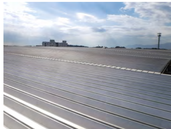
■秋本食品㈱本社・湘南工場屋根改修工事(神奈川) 金属屋根用塗料「ピチューロンシルバー」/6,000㎡ 建築用塗膜防水材「ブルーフロンバリュー」PN-V20G 工法/800㎡ 施工/㈱内野塗装
