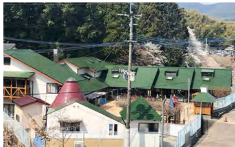
■武雄市某保育園屋根改修工事(佐賀) 屋根用塗料「リリーフNADフッ素」/1,000㎡ 施工/肥州塗装
