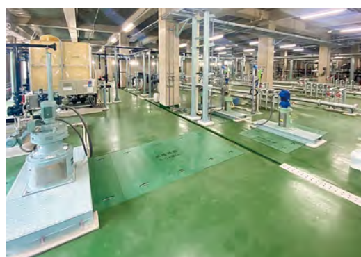
■ 恵下埋立地 (仮称) 浸出水処理施設等建設工事 (広島) 塗床材「ユータックE-40」コーティング工法/1,200㎡ 塗床材「ユータックVE-100」1プライライニング工法/200㎡ 施工/丸福建材工業㈱
