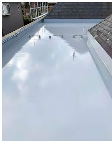
■栃木教会(栃木) 建築用塗膜防水材「ブルーフロンバリュー」 X-1工法、X-2立上り工法/150㎡ 施工/㈱タナカペインティング
