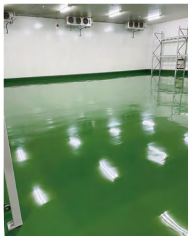
■株式会社 覆かせ玄米ファクトリー(茨城) 水性硬質ウレタン系塗り床材「ユータックコ ンプリート」CPS-3F工法/300㎡ 施工/㈱タナカペインティング
