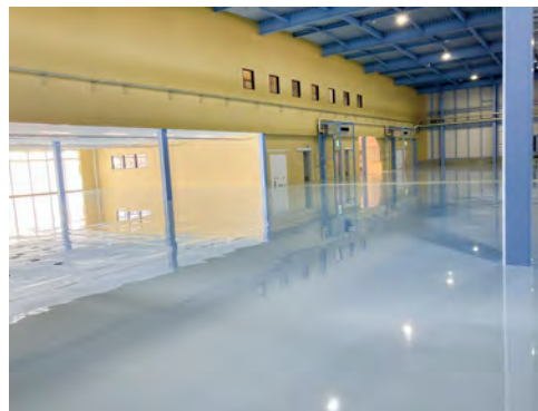
■光生工場新築工事(愛知) 塗り床材「ユータックE-30N」流し展べ工法/2,000㎡ 建設/まるひ建設株式会社 施工/安田塗装工業株式会社
