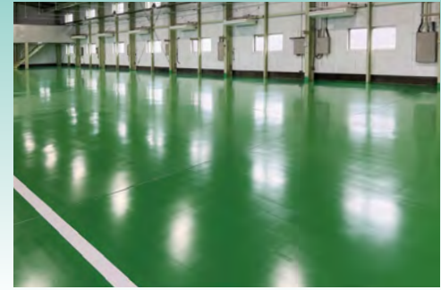
■苫倉庫塗り床工事(岡山) 塗り床材「ユータッククリーンE」SD-2工法/1,000㎡ 施工/古賀工業(株)
