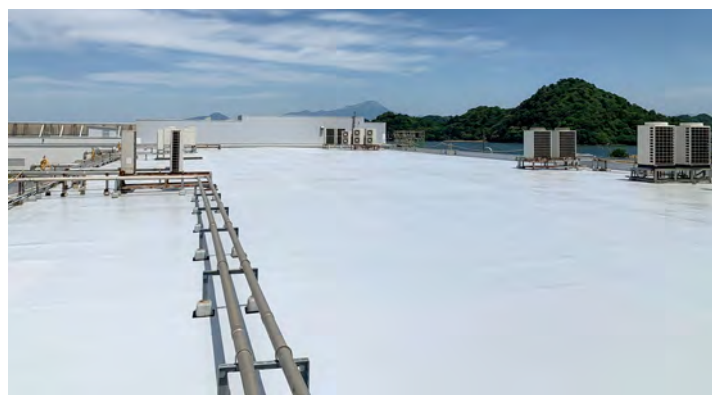
■某工場屋根防水改修工事(島根) 超速硬化ウレタ・ウレタン系塗膜防水材スプレーシステム「NTスプレータイプS」NM-SS30S工法/5,015㎡ 施工/(有)板持塗装店
