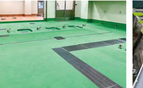
■某施設厨房床新築工事(鹿児島) 水性硬質ウレタン系塗料「ユータックコンプリート」CPL-6N工法/200㎡ 施工/鹿児島ビルド(有)
