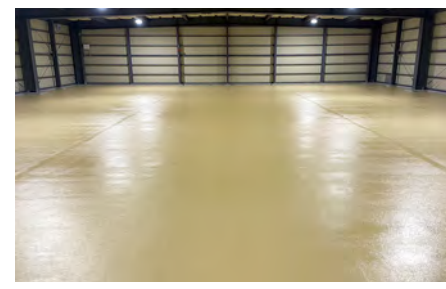
■某バン工場倉庫床改修工事(鹿児島) 超速硬化ウレタ・ウレタン系塗膜防水材スプレーシステム「NTスプレータイプH」/500㎡ 施工/鹿児島ビルド(有)
