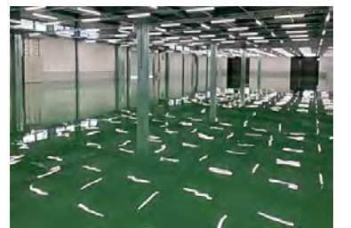
■某工場新築工事(滋賀) 塗り床材「ユータックE-30N」流し展べ工法/2,580㎡ 施工/株式会社納所床工業
