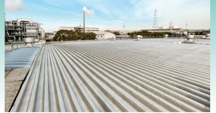
■某工場屋根改修工事(愛知) 金属屋根用塗料「ビチューロンシルバー」/10,000㎡ 施工/尚秋春建築
