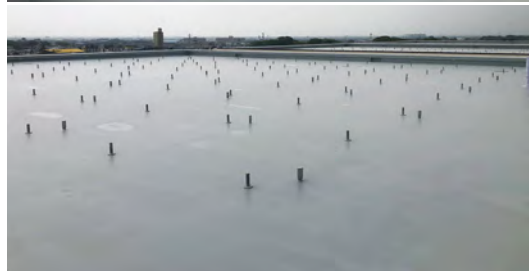
■ヤマコ佐賀工場冷凍倉庫屋上防水改修工事(A、B、C、D棟)(佐賀) 建築用塗膜防水材「ブルーフロンエコHG」X-1工法/3,399.1㎡ 建築用塗膜防水材「ブルーフロンエコHG」X-2工法/2,210.7㎡ 建設/㈱竹中工務店 施工/戎工業(株)
