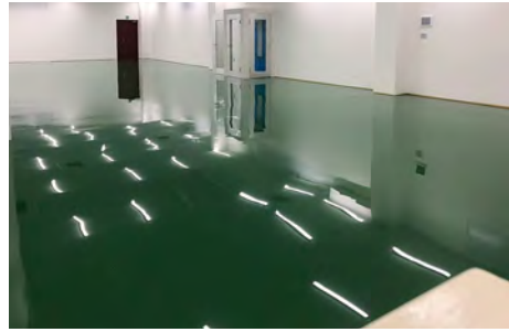
■共栄産業交野工場改修工事(京都) 塗り床材「ユータッククリーンE」SD-1工法/380㎡ 施工/アサヒカラコン(株)
