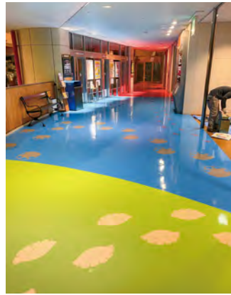
■心斎橋ビッグステップB1F通路改修工事(大阪) 塗り床材「ユータックR」コーティング工法/120㎡ 施工/アサヒカラコン(株)
