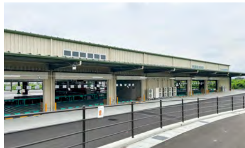
■JAフルーツ山梨塩山地区統合共選所新築工事(山梨) 屋根用遮熱塗料「パラサーモシリコン」/3,800㎡ 建築外装用遮熱塗料「パラサーモシリコン外壁用」/1,000㎡ 施工/尚加賀美塗装店
