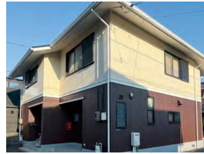
■某アパート外壁改修工事(山口) 建築外装用遮熱塗料「シルビアセラティーN遮熱」/300㎡ 施工/光塗装(株)
