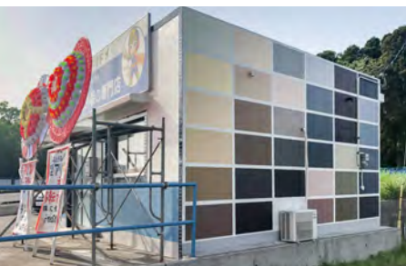
■アリドメ新事務所外壁・防水改修工事(鹿児島) アクリルゴム系壁面防水化粧材「ハイブルーF」/200㎡ 建築用塗膜防水材「ブルーフロンエコHG MID」密着工法/500㎡ 施工/㈱アリドメ
