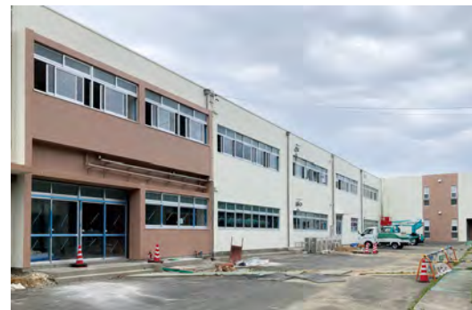
■福江小学校教室棟長寿命化改修工事(愛知) アクリルゴム系壁面防水化粧材「ハイブルー」大波工法 水性シリコン仕上げ/1,160㎡ 建設/株式会社井組 施工/株式会社井塗装工業
