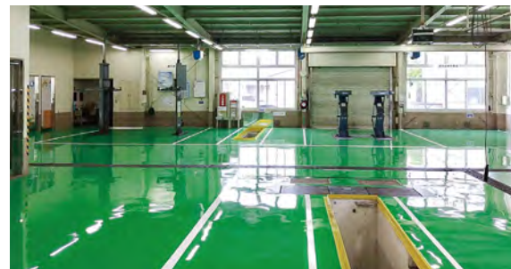
■某自動車整備場(滋賀) 塗り床材「ユータックスーパーFハードN」ハード流し展べ工法/282㎡ 塗り床材「ユータックスーパーFハードN」ハード流し展べ防汚工法/42㎡ 施工/株式会社Ha-ya-te
