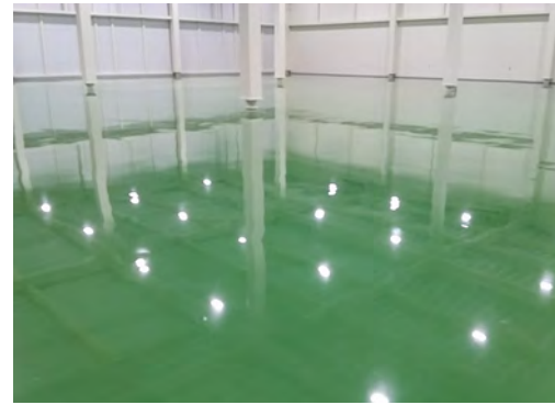
■ロジテックINAソリューションズ第2工場西側増築工事(長野) 塗り床材「ユータックE-30N」ハード流し展べ工法/1,019㎡ 施工/株式会社五十鈴
