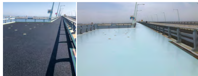
■東道新北九州空港線新北九州空港連絡橋歩道舗装補修工事(2工区)(福岡) 建築用塗膜防水材「ブルーフロンエコHG」/680㎡ 建設/鈴木建設(株) 施工/九州ニチレキ工事(株)
