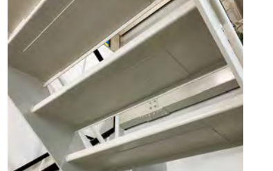
■美工社事務所内鉄骨階段(福井) 防音材「防音くん鉄骨階段用」 施工/株式会社美工社
