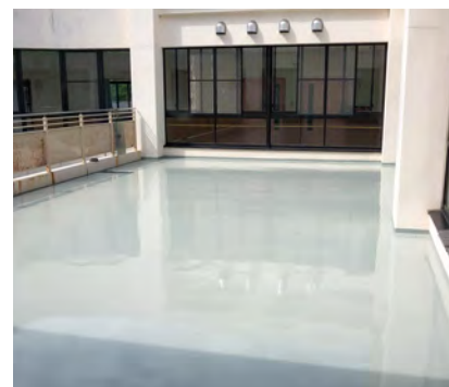
■小林市某施設(宮崎) 建築用塗膜防水材「ブルーフロンバリュー」X-2工法/200㎡ 施工/㈱森田塗装店
