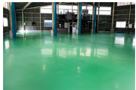
■福岡九州クボタ塗り床工事(福岡) 水性硬質ウレタン系塗料「ユータックコンプリート」CPS-3F工法/380㎡ 建設/㈱エムビーエス 施工/㈱OTK
