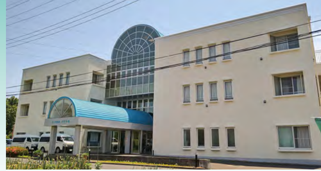
■某老人介護施設(埼玉) 建築外装用塗料「シルビアサーフ」「シルビアWU-200」「エヌティオ」/2,400㎡ 屋根用遮熱塗料「パラサーモン」/290㎡ シート防水材用保護塗料「ルーフガード」/1,500㎡ 施工/協和創建株式会社
