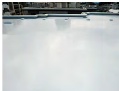
■スカイマンション高宮屋上防水改修工事(福岡) 建築用塗膜防水材「ブルーフロンバリュー」PKD-V30S工法/310㎡ 建設/㈱ダイニチ 施工/㈱安河内工業
