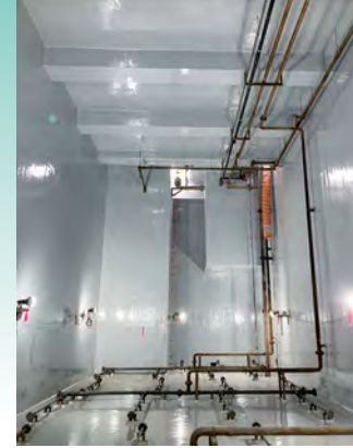
■水処理施設調整槽防水改修工事(愛知) 下水道処理施設用内面防水被覆材「タフバリア#150」B-4工法/1,000㎡ 建設/株式会社川工務店 施工/SUGISEI
