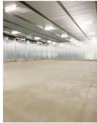
■西村物産 有田倉庫新築工事(大阪) 水性硬質ウレタン系塗り床材「ユータックコンプリート」CPGM-4N工法/550㎡ 施工/アサヒカラコン(株)
