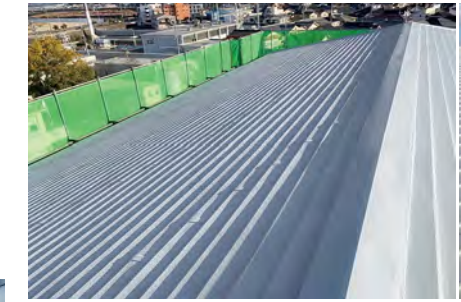
■某学校屋内運動場屋上防水改修工事(広島) 超速硬化ウレタ・ウレタン系塗膜防水材スプレーシステム「NTスプレータイプS」NY-SS20S工法/652㎡ 施工/(株)ティーエス・ハマト、(有)ビルドウェザー
