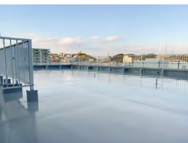
■コーラルハイツ葉山改修工事(長崎) 建築外装用塗料「シルビアセラティールN」/2,000㎡ 建築用塗膜防水材「ブルーフロンバリュー」X-1工法/700㎡ 施工/㈱ヌリケン・プラス
