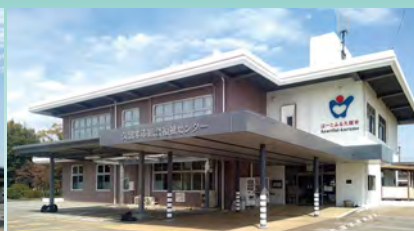
■久留米市総合福祉センター改修工事(福岡) 省エネ外断熱塗装システム「NTダンネツコート」[水性パラサーモ外壁用]/1,250㎡ 建設/㈱テラシマ 施工/㈱H&Y
