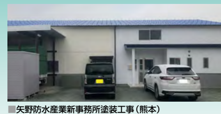
■矢野防水産業新事務所塗装工事(熊本) 建築外装用遮熱塗料「シルビアセラティールN遮熱」R-822P/420㎡ 屋根用塗料「水性ルーフセラ」ロイヤルブルー/300㎡ 施工/矢野防水産業(株)
