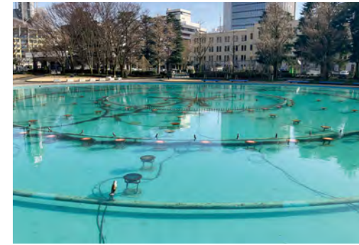
■県庁前公園県単独都市公園施設整備噴水池塗装修繕工事(富山) プール用塗料「プールエース」#500/1,000㎡ 施工/株式会社サナダ塗装工業
