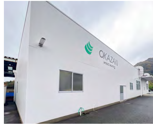
■岡崎木材工業外壁改修工事(山口) 建築外装用遮熱塗料「シルビアセラティーN遮熱」/1,300㎡ 施工/光塗装(株)
