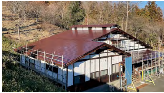
■おがのみどりの交流館屋根塗装工事(埼玉) 屋根用遮熱塗料「エポラオールプライマー遮熱ホワイト」「スーパーパラサーモシリコン」/539㎡ 施工/株式会社日本アステック
