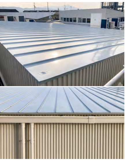
■某施設改修工事(徳島) 屋根用遮熱塗料「スーパーパラサーモシリコンS」/200㎡ 建築外装用遮熱塗料「パラサーモシリコンS」外壁用/600㎡ 施工/(有)中村建装
