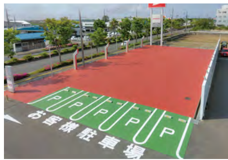
■泉北豊田き点局建設工事(大阪) アクリルゴム系壁面防水化粧材「ハイブルーF」大波工法/546㎡ 施工/㈱永井英塗装
