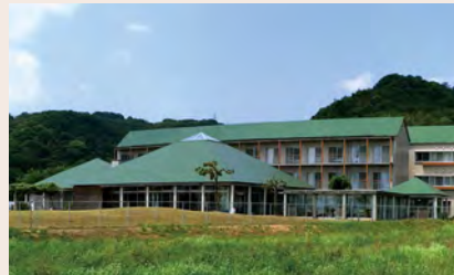
屋根用遮熱塗料「水性バラサーモ」（某介護老人保健施設）
