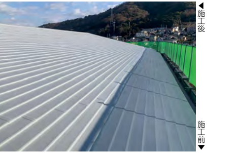
↑施工後 ↓施工前
