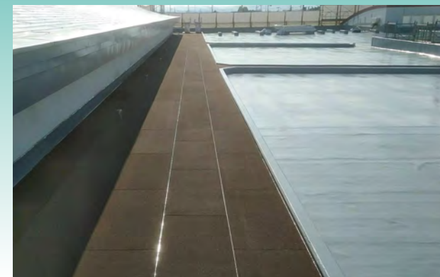
■平川市某施設屋上(青森) 超速硬化ウレタ・ウレタン系塗膜防水材スプレーシステム「NTスプレータイプS」X-1工法「ブルーフロンGRトップ遮熱」仕上げ/2,800㎡ 超速硬化ウレタ・ウレタン系塗膜防水材スプレーシステム「NTスプレータイプS」NY工法「ブルーフロンGRトップ遮熱」仕上げ/520㎡ 施工/株式会社B・Fリバイブ、東北技建株式会社
