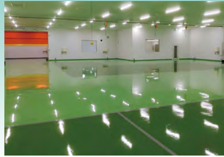
■塩野電気商会亀岡工場新築工事(京都) 塗り床材「ユータックE-30N」ハード流し展べ工法「ユータックR」仕上げ/900㎡ 施工/アサヒカラコン(株)
