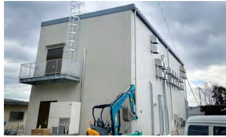
■泉北豊田き点局建設工事(大阪) アクリルゴム系壁面防水化粧材「ハイブルーF」大波工法/546㎡ 施工/㈱永井英塗装
