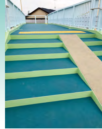
■朝日歩道橋補修工事(愛知) 塗り床材「ユータックE-30(K)」樹脂モルタル工法/200㎡ 建設/サンエイ株式会社 施工/新生建工株式会社
