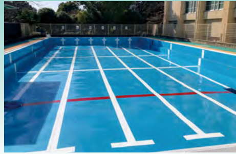
■某小学校プール改修工事(京都) プール用塗料「プールエース#300」PEU-1 RA-E工法/450㎡ 施工/㈱日建、(有)マエダ化研
