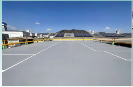
■某自動車整備場屋外駐車場防水修繕工事(広島) 超速硬化ウレタ・ウレタン系塗膜防水材スプレーシステム「NTスプレー タイプH」NC-SH30OUTR工法/367㎡ 施工/(有)信誠外装、(有)ビルドウェザー
