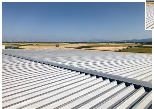
■JAさがみどり地区杵島東部カントリー改修工事(佐賀) 金属屋根用塗料「マッキンレーN」/3,700㎡ 施工/オオグシペイント
