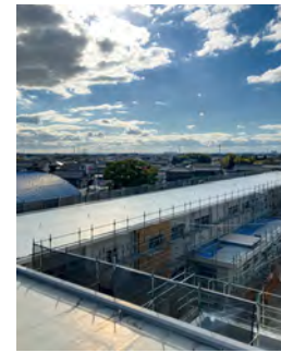
■安城市立明和小学校校舎外部保全工事(愛知) 建築用塗膜防水材「ブルーフロンエコDX」X-1工法「ブルーフロンEGトップSi遮熱」ライトグレー/210㎡ 建築用塗膜防水材「ブルーフロンエコDX」X-2工法「ブルーフロンEGトップSi遮熱」ライトグレー/80㎡ 建築用塗膜防水材「ブルーフロンエコDX NS」X-2工法立上り「ブルーフロンEGトップSi遮熱」ライトグレー/170㎡ 建設/株式会社鳥居工務店 施工/新生建工株式会社
