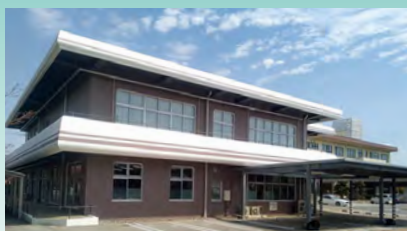
■久留米市総合福祉センター改修工事(福岡) 省エネ外断熱塗装システム「NTダンネツコート」[水性パラサーモ外壁用]/1,250㎡ 建設/㈱テラシマ 施工/㈱H&Y
