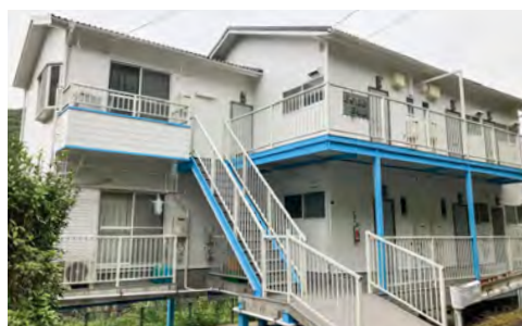
■S様邸3番館(長崎) 建築外装用塗料「シルビアセラティーンN」/320㎡ 施工/ミリッペ
