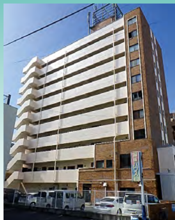
■メナードビル外壁改修工事(山口) 建築外装用塗料「シルビアセラティーンN」 /4,000㎡ 施工/㈱日光
