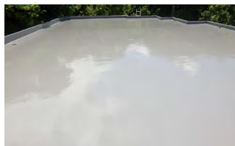
■某小中学校教員宿舎防水改修工事(鹿児島) 建築用塗膜防水材「ブルーフロンエコHG」X-2工法/200㎡ 施工/㈱有村防水
