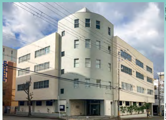
■多田利ビル外壁改修工事(大阪) 建築外用塗料「シルビアサーフ」 +「シルビアWS-300」、 建築外用塗料「シルビアNADシリ コン」/3,000㎡ 施工/㈱マエダ化研
