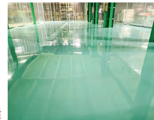
■平塚市某工場(神奈川) 塗り床材「ユータックE-30N」ハード流し展べ工法/430㎡ 建設/㈱日宝美装 施工/㈱ナカムラ
