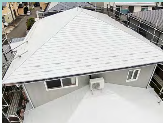
■真下様邸屋根塗装工事(青森) 屋根用遮熱塗料「パラサーモフッ素」(下塗り「エポラオールプライマー」遮熱ホワイト)/128㎡ 施工/㈱佐々木商会
