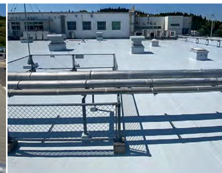
■某工場屋上防水改修工事(鹿児島) 超速硬化ウレタ・ウレタン系塗膜防水材スプレーシステム「NTスプレータイプS」NM-SS30G工法/1,200㎡ 施工/㈱南日建塗工業、鹿児島ビルド(有)
