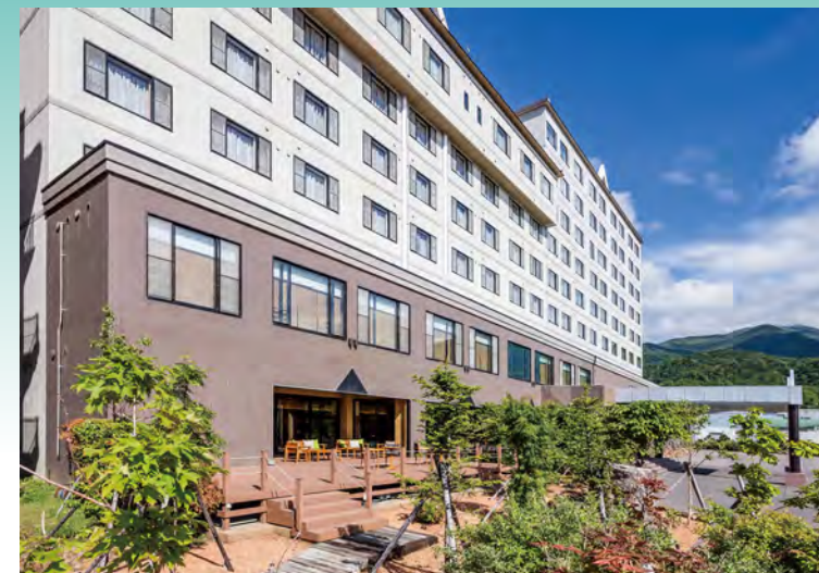
■KIKI知床（北海道） アクリルゴム系壁面防水化粧材「ハイブルーフ」/1,100㎡ 施工/㈱星塗装工業
