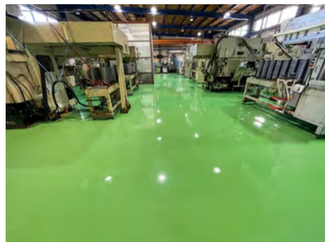
■某工場床改修工事(岐阜) 塗り床材「ユータックE-30N」樹脂モルタル流し展べ工法 /325㎡ 施工/㈱愛知レジン
