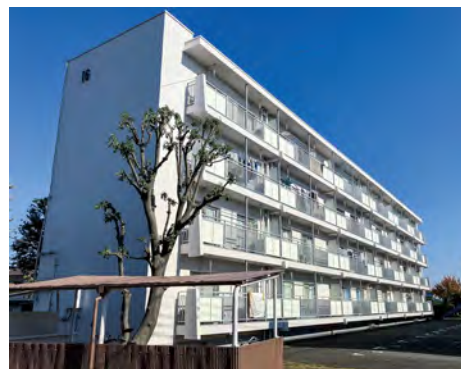
■市営住宅外壁及び屋上防水等改修工事(第16、第17、第18小柳町住宅)(東京) 建築外装用塗料「シルビアサーフ」+「シルビアWF-400」/4,000㎡ 建築外装用塗料「シルビアクリーン」/850㎡ 建築外装用塗料「シルビナDシリコン」/1,430㎡ 建築用塗膜防水材「ブルーフロンエコ」X-2工法/740㎡ 設計/府中市 元請/㈱アール企画
