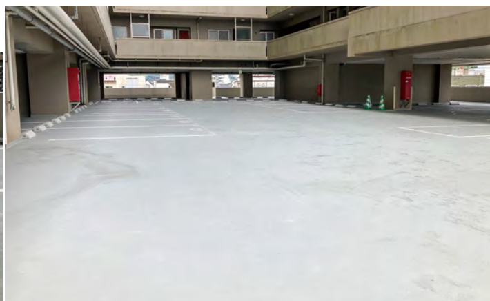
■ロフティ日田駅前テリオ3階駐車場改修工事(大分) 超速硬化ウレタ・ウレタン系塗膜防水材スプレーシステム「NTスプレータイプH」NC-SH30UTR工法/2,035㎡ 施工/㈱キューボウ
