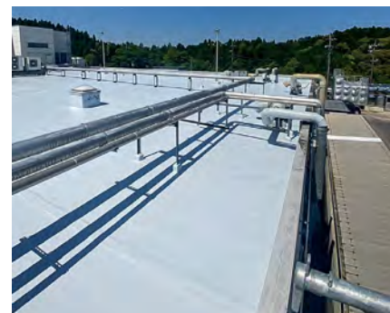
■某工場屋上防水改修工事(鹿児島) 超速硬化ウレタ・ウレタン系塗膜防水材スプレーシステム「NTスプレータイプS」NM-SS30G工法/1,200㎡ 施工/㈱南日建塗工業、鹿児島ビルド(有)
