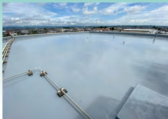
■某施設屋上(静岡) 建築用塗膜防水材「ブルーフロンバリュー」PN-V20G工法、PG-V20G工法/3,130.5㎡ 施工/㈱アヅマ
