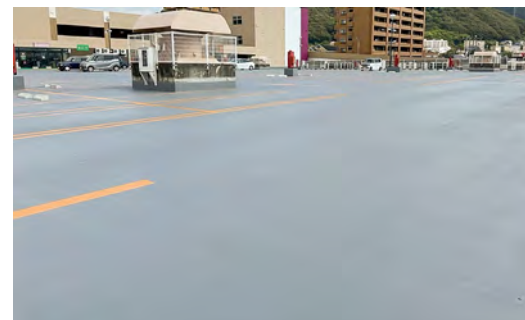
■某大型ショッピングモール駐車場防水改修工事(広島) 超速硬化ウレタ・ウレタン系塗膜防水材スプレーシステム「NTスプレータイプH」NC-SH30UTR工法/7,687㎡ 施工/㈱ビルドウェザー
