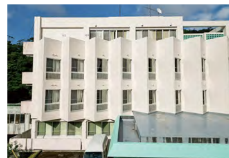
■特別養護老人ホーム「虹の丘」西面外壁改修(鹿児島) アクリルゴム系壁面防水化粧材「ハイブルーF」/875㎡ 施工/㈱有村防水
