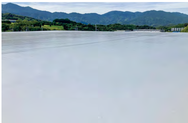
■(㈱福岡市民ホールサービス舞台機材センター)屋上防水改修工事(福岡) 建築用塗膜防水材「ブルーフロンエコHG」PRV-HG30S工法/2,282㎡ 建設/㈱へいせい 施工/㈱キューボウ
