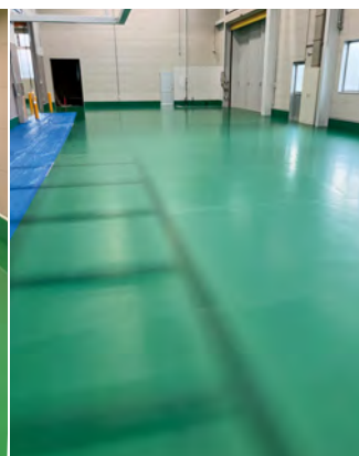
■丸幸製網所新築工事(愛知) 塗り床材「ユータックE-30 N」流し展べ工法「ユータッ クR」仕上げ/2,150㎡ 塗り床材「ユータックFエコ」 流し展べFT工法/350㎡ 塗り床材「ユータックコンプ リート」CPS-3S/300㎡ 設計/㈱大河内設計 建設/まるひ建設㈱ 施工/真和建装㈱
