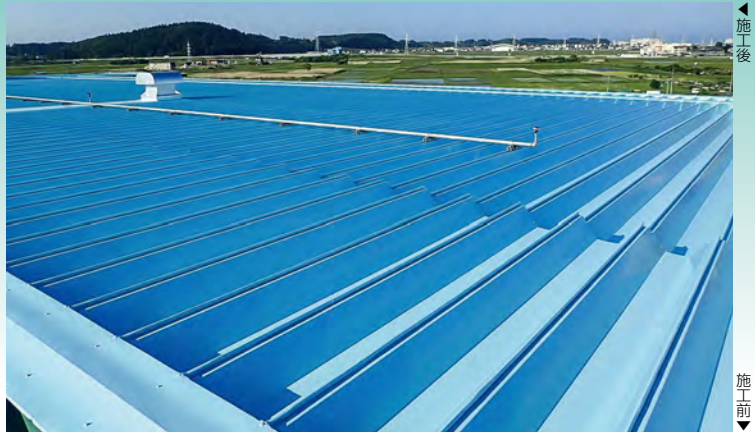
■第2物流センター屋根塗装工事(青森) 屋根用遮熱塗料「パラサーモシリコン」(下塗り「エポラオールプライマー」遮熱ホワイト)/2,600㎡ 施工/㈱佐々木商会
