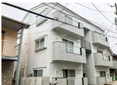
■S様邸8番館(長崎) 建築外装用塗料「シルビアセラティーンN」/415㎡ 施工/ミリッペ
