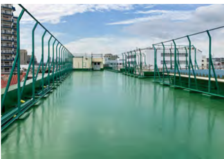
■六郷小学校屋上防水改修その他工事(東京) 建築用塗膜防水材「ブルーフロンエコDX」PG-D30GE工法/2,920㎡ 設計/大田区 元請/三ツ木建設工業㈱
