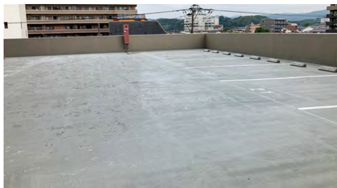
■ロフティ日田駅前テリオ3階駐車場改修工事(大分) 超速硬化ウレタ・ウレタン系塗膜防水材スプレーシステム「NTスプレータイプH」NC-SH30UTR工法/2,035㎡ 施工/㈱キューボウ
