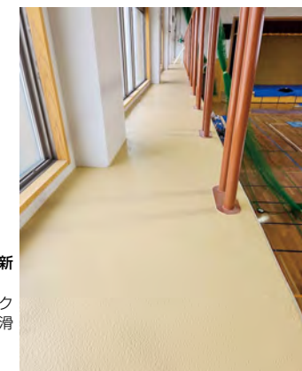
■カスノモータース京都新築工事(京都) 塗り床材「ユータックスーパーハードN」流し展べ工法「ユータックR」仕上げ/400㎡ 施工/アサヒカラコン㈱
