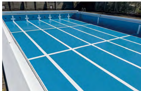
■青梅市立吹上小学校プール(東京) プール用塗料「プールエース#300」PEU-1 RA-RC工法/385㎡ 元請/㈱原美装 施工/㈱井上建装
