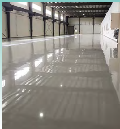
■某半導体工場塗り床工事(熊本) 塗り床材「ユータックE-30N」流し展べ工法/3,900㎡ 施工/㈱駿河コーポレーション
