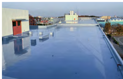
■上藤沢中学校校舎外壁等改修工事(埼玉) 建築用塗膜防水材「ブルーフロンエコDX」X-1工法/1,370㎡ 建築用塗膜防水材「ブルーフロンエコDX」X-2工法/890㎡ 設計/所沢市 元請/石田鉄工建設㈱
