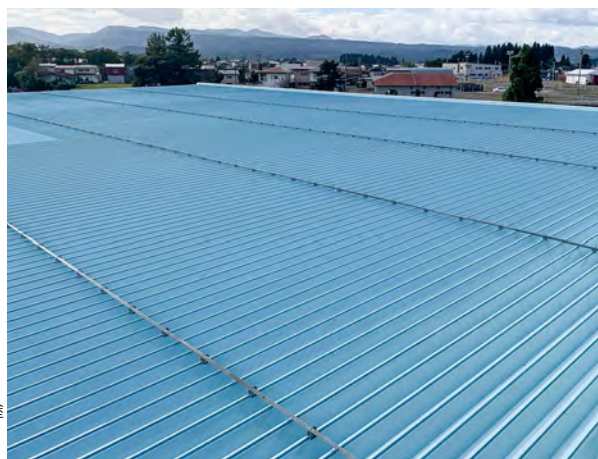
■某工場屋根改修工事(秋田) 屋根用遮熱塗料「パラサーモシリコン」(下塗り「エポラオールプライマー」)/3,200㎡ 施工/㈱共立塗装
