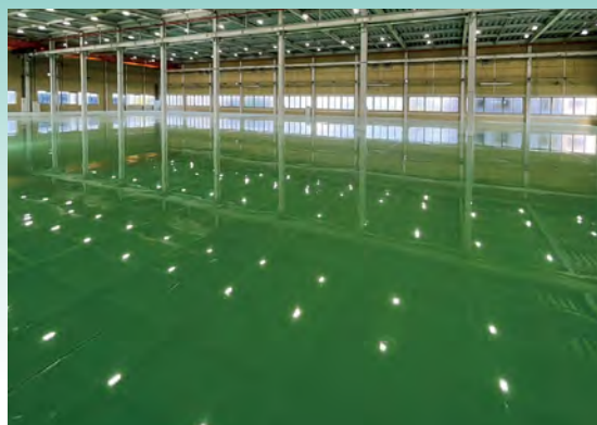
■某工場新築工事(愛知) 塗り床材「ユータックE-30Nローラー用」コーティング工法/2,425㎡ 施工/東亜塗装㈱
