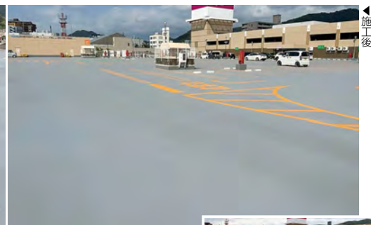
■某大型ショッピングモール駐車場防水改修工事(広島) 超速硬化ウレタ・ウレタン系塗膜防水材スプレーシステム「NTスプレータイプH」NC-SH30UTR工法/7,687㎡ 施工/㈱ビルドウェザー
