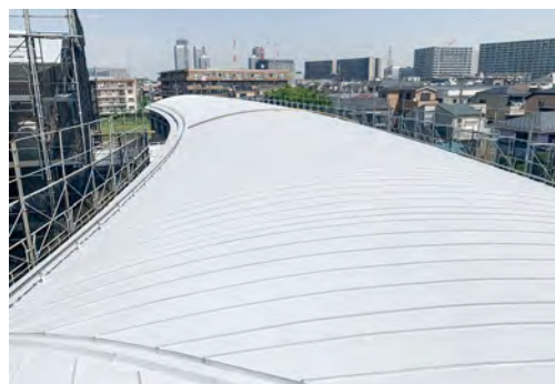
■川崎市某学校(神奈川) 超速硬化ウレタ・ウレタン系塗膜防水材スプレシステム「NTスプレタイプS」NY-SS20ESS工法/3,957㎡ 建築用塗膜防水材「ブルーフロンエコ」X-1工法/384.1㎡ 建築用塗膜防水材「ブルーフロンエコ」X-2工法/359.6㎡ 外壁タイル改修工法「タイルレジスト」/2,479㎡ 建設、施工/福吉塗装㈱
