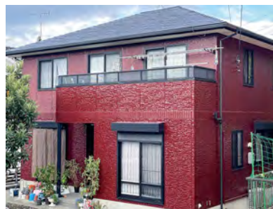
■山下工場長邸(広島) 建築外用塗料「シルビアNADフッ素」+「シルビアUVカットフッ素クリアー」(下塗り「エポラオールプライマー」)/166㎡ 屋根用遮熱塗料「パラサーモシリコン」(下塗り「エポラマイルドプライマー-S」)/96㎡ 施工/㈱信誠外装
