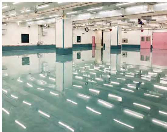
■㈱リコー厚木事業所(神奈川) 塗り床材「ユータッククリーンE厚膜」SD-1工法/570㎡ 建設/曙建設㈱ 施工/㈱ワールドバック
