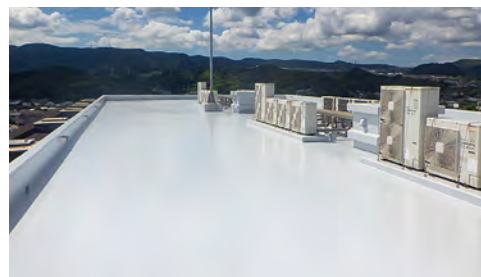
■某病院屋上防水改修工事(鹿児島) 建築用塗膜防水材ウレタン圧送システム SPNPM-D30G工法 /1,300㎡ 施工/鹿児島ビルド(有)
