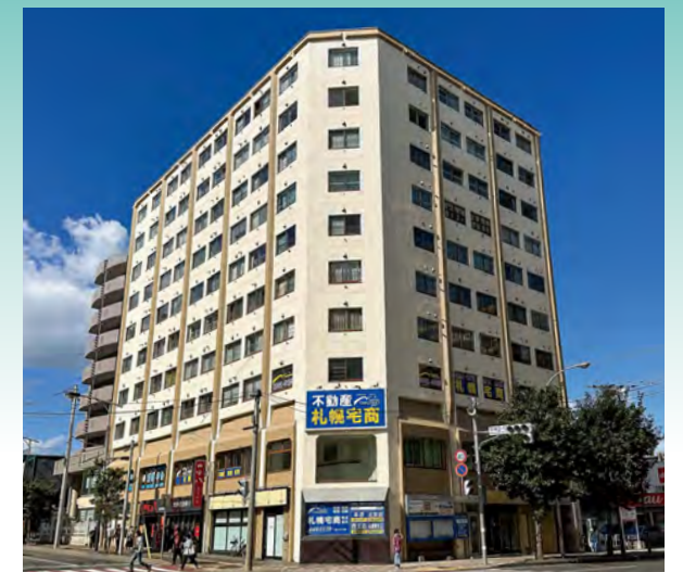
■チサンマンション札幌第6（北海道） アクリルゴム系壁面防水化粧材「ハイブルーフ」/3,234㎡ 施工/㈱星塗装工業
