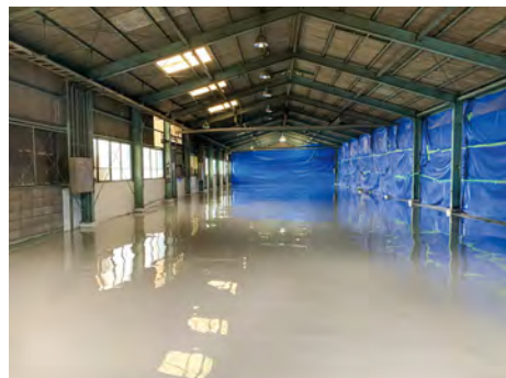
■某倉庫床改修工事(岐阜) 塗り床材「ユータックE-30N」樹脂モルタル流し展べ工法 /480㎡ 施工/㈱愛知レジン
