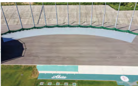
■某工場屋根改修工事(秋田) 屋根用遮熱塗料「パラサーモシリコン」(下塗り「エポラオールプライマー」)/3,200㎡ 施工/㈱共立塗装
