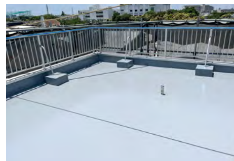
■大西組名神口営業所屋上防水工事(大阪) 建築用塗膜防水材「ブルーフロンエコ」X-1工法/100㎡ 施工/㈱建塗工房
