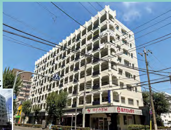
■グレース東武高島平(東京) 建築外装用塗料「シルビアWS-300」/4,514㎡ 建築外装用塗料「NTダンネツベース」/753㎡ アクリルゴム系壁面防水化粧材「ハイブルーフ」/237㎡ 建築外装用塗料「シルビナノキクリーン」/577㎡ 建築外装用塗料「シルビナDウレタンN」/鉄骨階段ほか鉄部等 建築用塗膜防水材「ブルーフロンバリュー」PM-V20G工法/158㎡ 設計/RC建築デザイン㈱ 施工/ニットクメンテ㈱
