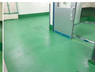
■ウツオ化工 加美工場改修工事(大阪) 塗り床材「ユータックスーパーハード N」流し展べ工法/870㎡ 施工/アサヒカラコン㈱
