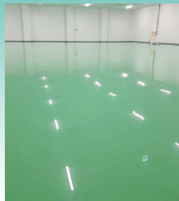
■某半導体工場塗り床工事(熊本) 塗り床材「ユータックE-30N」流し展べ工法/2,000㎡ 施工/㈱駿河コーポレーション
