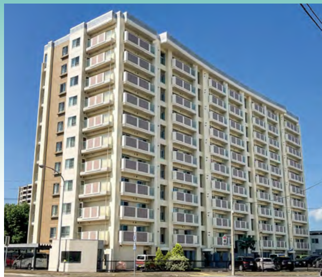
■ロジェブリエ5条通（北海道） 建築外装用塗料「シルビアセラティ-N」/6,962㎡ 建築外装用塗料「シルビアクリーン」/1,478㎡ 施工/㈱アイ・ディー・エフ
