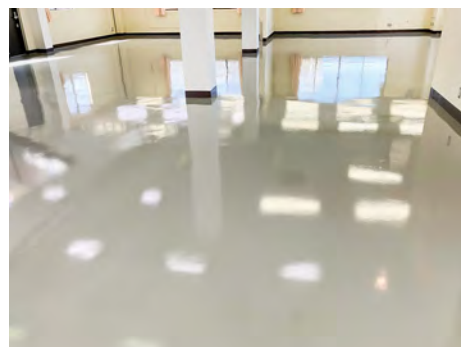
■某工場床(山梨) 塗り床材「ユータッククリーンE GL」SD-2工法/236㎡ 建設/井口工業㈱ 施工/㈱中沢実業
