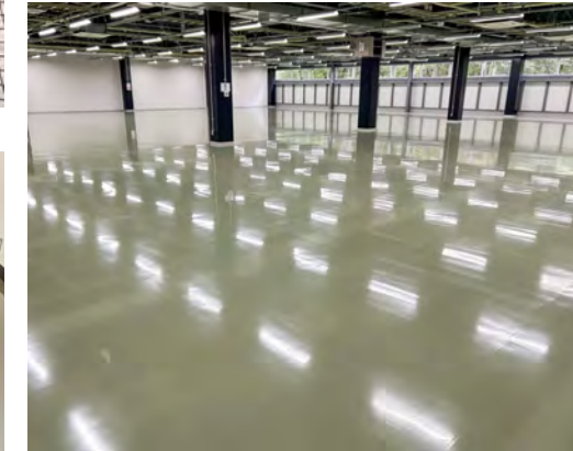
■茅野市某工場(長野) 塗り床材「ユータッククリーンE GL」SD-2工法/1,110㎡ 施工/㈱アークシステム
