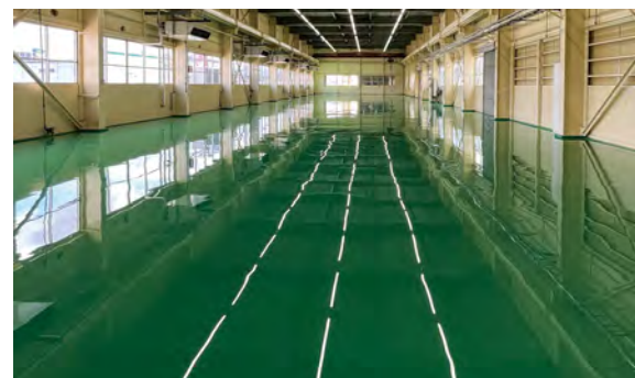
■某化学工場床新築2期工事(富山) 塗り床材「ユータックE-30N」樹脂モルタル流し展べ工法/1,500㎡ 施工/㈱愛知レジン
