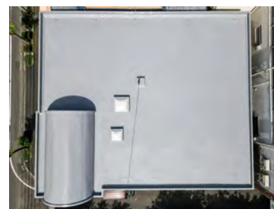
■某指定避難所屋上防水等改修工事(鹿児島) 建築用塗膜防水材「ブルーフロンエコHG」「ブルーフロンエコHG MID」X-2工法/355.9㎡ 施工/㈱有村防水
