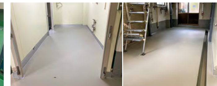
■富田酒造床・溝改修工事(大阪) 塗り床材「ユータックコンプリート」CPS-4F工法/110㎡ 塗り床材「ユータックE-30N」流し展べ工法/20㎡ 施工/㈱Ha・ya・te
