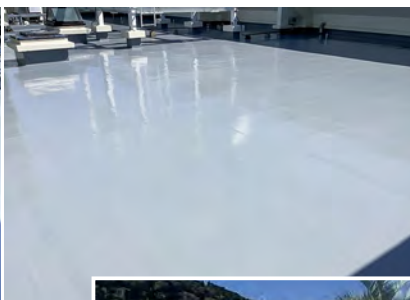
■GOOD LINK改修工事(福岡) 建築外装用塗料「シルビアセラティーンN」/480㎡ 建築用塗膜防水材「ブルーフロンバリュー」X-2工法/130㎡ 陶磁器タイルクリヤー塗料「タイルピカ」/40㎡ 施工/㈱H&Y
