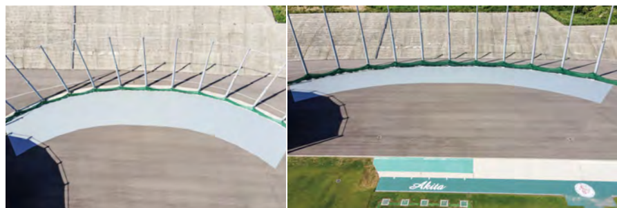
■秋田県総合射撃場(秋田) 塗り床材「ユータックE-30(K)」/2,300㎡ 塗り床材「ユータックS」/2,300㎡ 建設/菊地建設㈱ 施工/㈱佐藤塗装
