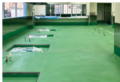
■某小学校給食室新築工事(大阪) 塗り床材「ユータックコンプリート」CPGM-5N工法/110㎡ 塗り床材「ユータックE-30N」流し展べ防滑工法/150㎡ 施工/㈱マエダ化研
