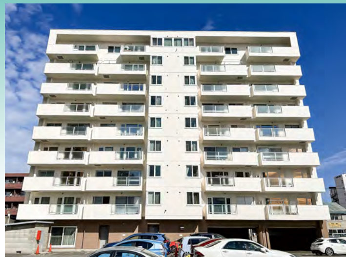
■ヴィラロードス（北海道） 建築外装用塗料「シルビアセラティ-N」/2,976㎡ 建築外装用塗料「シルビアクリーン」/715㎡ 施工/㈱アイ・ディー・エフ
