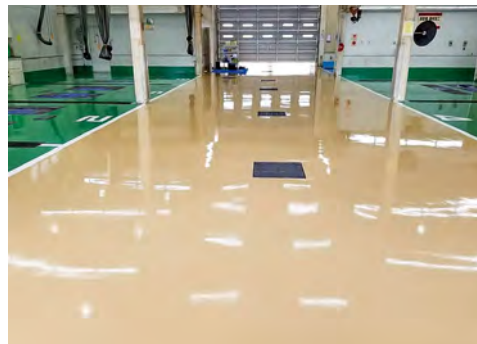
■ダイハツ洲本整備ビル改修工事(兵庫) 塗り床材「ユータックスーパーハードN」流し展べ工法「ユータックR」仕上げ/300㎡ 施工/古賀工業㈱
