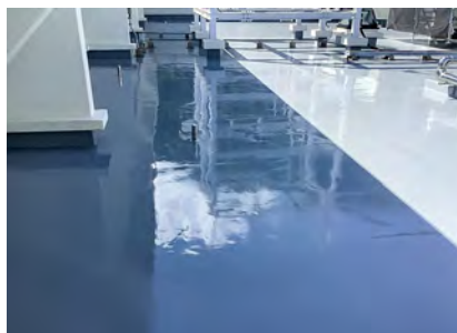
■宮崎県立高等水産研究所本館屋根防水工事(宮崎) 建築用塗膜防水材「ブルーフロンバリュー」X-1工法/450㎡ 施工/㈱エイエフ工業
