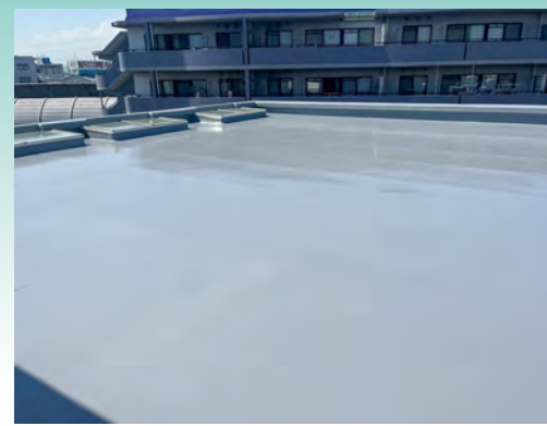
■ミュージックコート屋上防水工事(大阪) 建築用塗膜防水材「ブルーフロン」PRV-G工法/200㎡ 施工/㈱建塗工房
