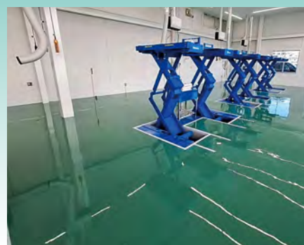
■Honda Cars明舞学園南店整備ビ－ト新築工事(兵庫) 塗り床材「ユータックスーパーFハードN」＋「ユータッ クR」/220㎡ 施工/古賀工業㈱
