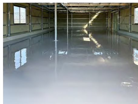
■株SUNAO FARM塗り床工事(福岡) 塗り床材「ユータックE-30N」流し展べ工法/158.4㎡ 施工/株福岡ペイントArt
