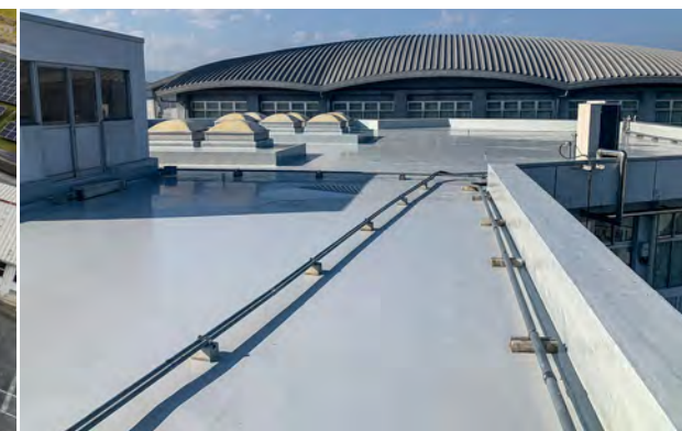
■阿波市立阿波中学校(徳島) 建築用塗膜防水材「ブルーフロンエコDX」X-1工法/1,750㎡ 建築用塗膜防水材「ブルーフロンエコDX」X-2工法/530㎡ 建築用塗膜防水材「ブルーフロンエコDX」PME-HG25S工法/300㎡ 施工/㈱菅原塗装
