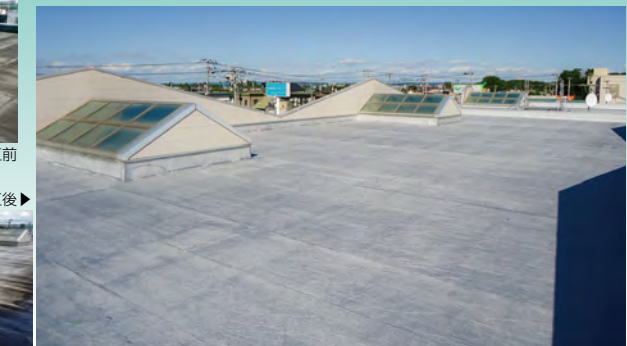
■自由が丘ストリート(北海道) シート防水材用保護塗料「ルーフガード」/603㎡ 施工/㈱千葉塗装店
