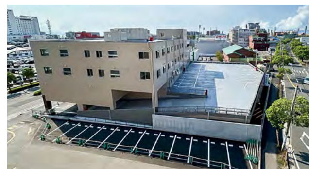
■新成病院新築工事(鹿児島) 建築用塗膜防水材「ブルーフロンエコDX」X-1工法(圧送)/830㎡ 建築用塗膜防水材「NTスプレータイプH」NC工法(駐車場防水工法)/780㎡ 設計/中野設計(株) 建設/内村建設(株)、坂本建設(株) 施工/鹿児島ビルド(株)
