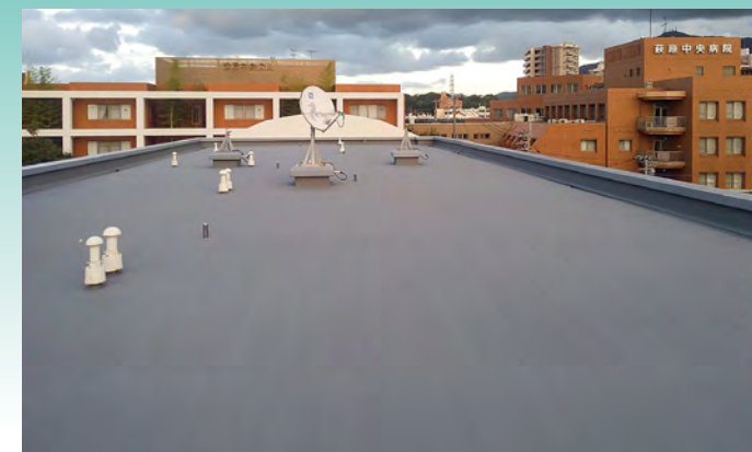
■某現場(長崎) 建築用塗膜防水材「ブルーフロンバリューDX」X-1工法/1,700㎡ 施工/株エイケン
