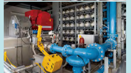
▲浸透圧発電施設(上)。下の写真で奥に見えるのが浸透膜設備、左にあるのが水車発電機。
