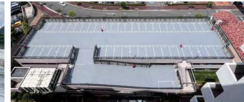
■某マンション駐車場防水改修工事(広島) 超速硬化ウレ－・ウレタンゴム系塗膜防水材スプレーシステム「NTスプレー タイプH」NC-SH30UTR 工法/849㎡ 超速硬化ウレ－・ウレタンゴム系塗膜防水材スプレーシステム「NTスプレー タイプH」NC-SH30UTR 工法重防滑仕様/303㎡ 施工/㈱三洋技建広島支店、(有)ビルドウェザー
