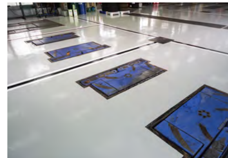
■ビットオフ音更店(北海道) 超速硬化ウレタ・ウレタン系塗膜防水材スプレーシステム塗り床材「ユータックR」コーティング工法/233㎡ 施工/㈱千葉塗装店
