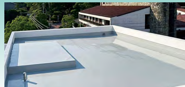
■某現場(長崎) 建築用塗膜防水材「ブルーフロンバリューDX」X-1工法/200㎡ 施工/株スリケン・プラス
