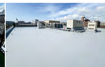
■某現場(長崎) 建築用塗膜防水材「ブルーフロンバリューDX」X-1工法/1,700㎡ 施工/株エイケン
