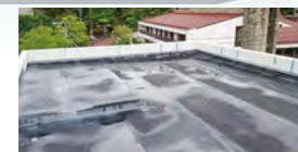
■某現場(長崎) 建築用塗膜防水材「ブルーフロンバリューDX」X-1工法/200㎡ 施工/株スリケン・プラス
