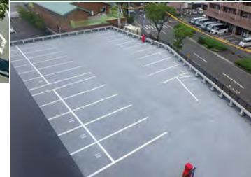
■新成病院新築工事(鹿児島) 建築用塗膜防水材「ブルーフロンエコDX」X-1工法(圧送)/830㎡ 建築用塗膜防水材「NTスプレータイプH」NC工法(駐車場防水工法)/780㎡ 設計/中野設計(株) 建設/内村建設(株)、坂本建設(株) 施工/鹿児島ビルド(株)
