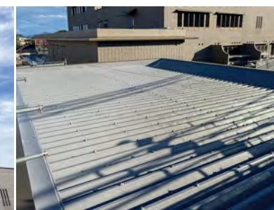
■某施設大規模改修工事(広島) 建築用塗膜防水材「ブルーフロンエコDX」X-1工法/1401.3㎡ 建築用塗膜防水材「ブルーフロンエコDX」X-2工法/699.2㎡ 超速硬化ウレ－・ウレタンゴム系塗膜防水材スプレーシステム「NTスプレー タイプS」NY-SS20S工法/762.2㎡ 施工/㈱ハムラ
