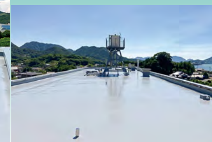
■某高校屋上防水改修工事(広島) 建築用塗膜防水材「ブルーフロンエコDX」X-1工法/683㎡ 建築用塗膜防水材「ブルーフロンエコDX」X-2工法/516㎡ 施工/㈱ハムラ
