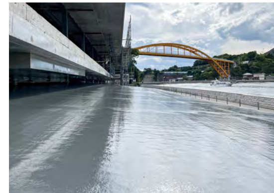
■某福祉施設新築工事(広島) 超速硬化ウレ－・ウレタンゴム系塗膜防水材スプレーシステム「NT スプレー タイプH」NN-SH20G工法/100㎡ 施工/㈱ハムラ
