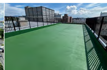
■某現場(長崎) 建築用塗膜防水材「ブルーフロンバリューDX」X-1工法/1,700㎡ 施工/株エイケン
