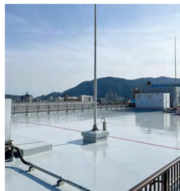
■某製作所屋上防水改修工事(広島) 建築用塗膜防水材「ブルーフロンエコDX」X-1工法/1,202㎡ 建築用塗膜防水材「ブルーフロンエコDX」X-2工法/274㎡ 施工/㈱ハムラ
