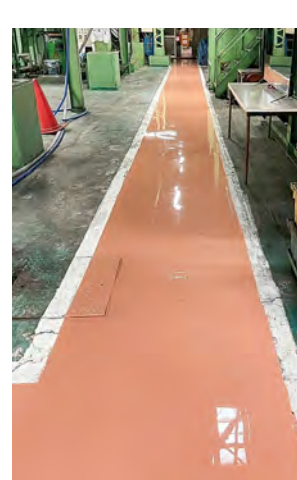
■㈱ムサシ本社物流センター新築工事(兵庫) 塗り床材「ユータックスーパーFハードN」/200㎡ 施工/古賀工業㈱
