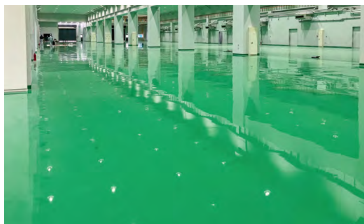
■三菱電機株伊丹製作所(兵庫) 塗り床材「ユータッククリーンE」SD-1工法/3,000㎡ 施工/アサヒカラコン㈱
