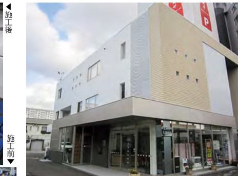
■久慈商店ビル(北海道) アクリルゴム系壁面防水化粧材「ハイブルーフ」/330㎡ 施工/中村塗装工業㈱
