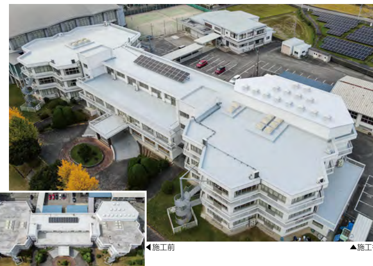
■阿波市立阿波中学校(徳島) 建築用塗膜防水材「ブルーフロンエコDX」X-1工法/1,750㎡ 建築用塗膜防水材「ブルーフロンエコDX」X-2工法/530㎡ 建築用塗膜防水材「ブルーフロンエコDX」PME-HG25S工法/300㎡ 施工/㈱菅原塗装
