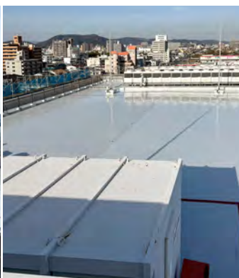
■某製作所屋上防水改修工事(広島) 建築用塗膜防水材「ブルーフロンエコDX」X-1工法/1,202㎡ 建築用塗膜防水材「ブルーフロンエコDX」X-2工法/274㎡ 施工/㈱ハムラ
