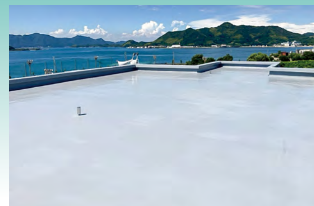
■某高校屋上防水改修工事(広島) 建築用塗膜防水材「ブルーフロンエコDX」X-1工法/683㎡ 建築用塗膜防水材「ブルーフロンエコDX」X-2工法/516㎡ 施工/㈱ハムラ
