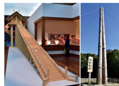
左/島根県立古代出雲歴史博物館に常設展示されている、古代出雲大社本殿を再現した10分の1の模型。右/「平成の大遷宮」の奉祝事業として再現された、古代出雲大社高層神殿を支えた三本柱の柱立て。
