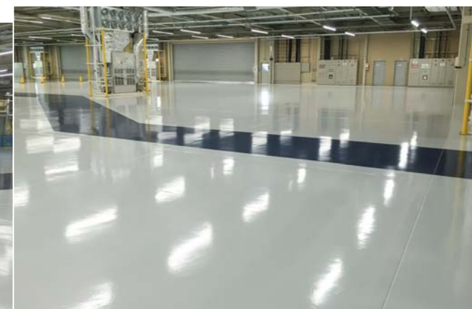
■某工場床改築工事に伴う塗り床改修塗装(三重) 塗り床材「NT水性速乾プライマー」「ユータックWE-400N」/11,000㎡ 塗り床材「NT水性速乾プライマー」「ユータックE素地調整材ECO」「ユータックWE-400N」/5,000㎡ 施工/㈱愛和
