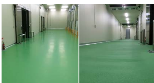
■熊本原肉生業新築工事(熊本) 塗り床材「ユータックコンプリート」CPS-3F工法/440㎡ 塗り床材「ユータックコンプリート」CPM-3N工法/540㎡ 塗り床材「ユータックコンプリート」CPL-6N工法/320㎡ 設計/㈱景観都市設計 建設/㈱小竹組 施工/㈱駿河コーポレーション
