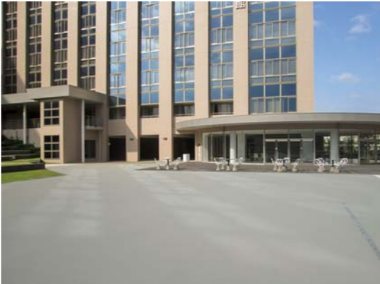
■九州産業大学榎田スタンド広場床塗装補修工事(福岡) 塗り床材「ユータックテクノ」コーティング防汚工法/1,200㎡ 施工/㈱ダイニチ
