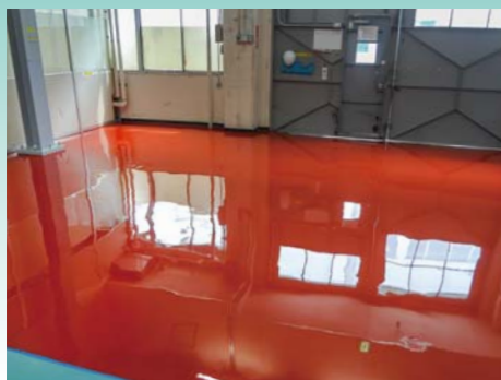
■パナソニック彦根工場(滋賀) 塗り床材「ユータックコンプリートG薄膜」/110㎡ 施工/アサヒカラコン(株)
