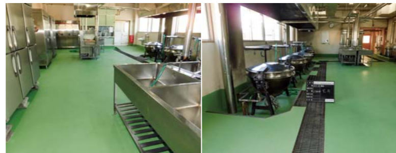
■むつ市私立大平小学校給食室(青森) 塗り床材「ユータックコンプリート」 /123㎡ 施工/㈱長牛塗装店
