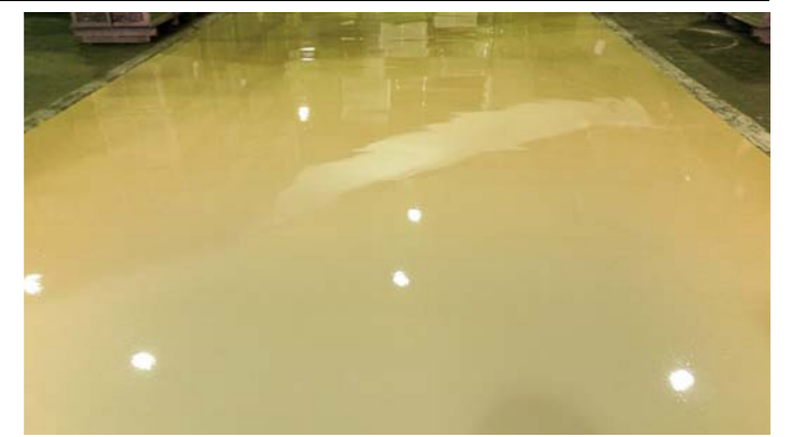
▲現場施工/ユータックスーパーFハードの上にユータックTMプロテクトを塗布
