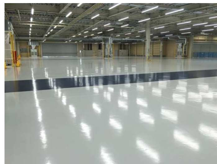
■某工場床改築工事に伴う塗り床改修塗装(三重) 塗り床材「NT水性速乾プライマー」「ユータックWE-400N」/11,000㎡ 塗り床材「NT水性速乾プライマー」「ユータックE素地調整材ECO」「ユータックWE-400N」/5,000㎡ 施工/㈱愛和
