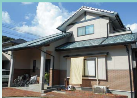
■周南市戸建外壁(山口) 建築外装用塗料「シルビアセラティーN」水性プライマー工法標準仕様/150㎡ 施工/㈱日光
