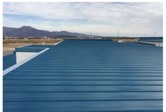
■㈱ジェイ・オー・ファーマ(島根) 屋根用遮熱塗料「スーパーパラサーモシリコン」エコマリンブルー/5,800㎡ 建設/岩崎建設(有) 施工/吉田塗装
