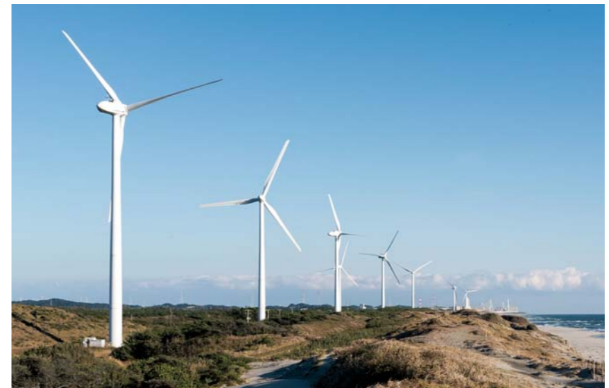
▲御前崎風力発電所の風車
