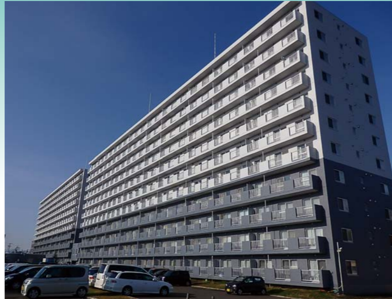
■サーム野幌駅第2期大規模修繕工事(北海道) 高弾性外壁防水塗材「ハイブルー大波工法」/5,787㎡ 建築用塗膜防水材「ブルーフロンX-2工法」/1,050㎡ 設計監理/一級建築士事務所土谷設計 施工/㈱星塗装工業
