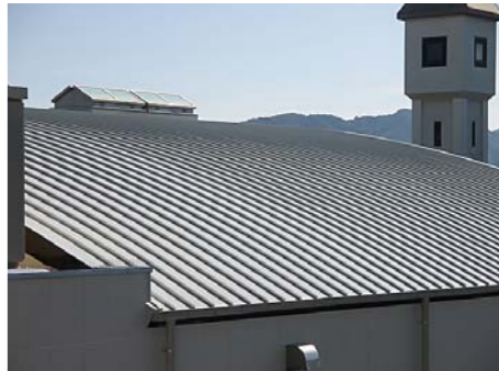
■医療法人社団高仁会ケアセンター等外壁改修工事(佐賀) 屋根用遮熱塗料「パラサーモシリコン」/1,170㎡ 施工/㈱ニシイ
