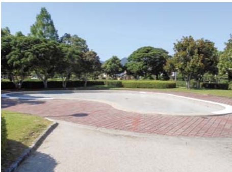
■山口維新公園徒渉池(山口) プール用塗料「プールエース」コンクリート・モルタル製プール標準施工仕様/339㎡ 施工/今村塗装(株)
