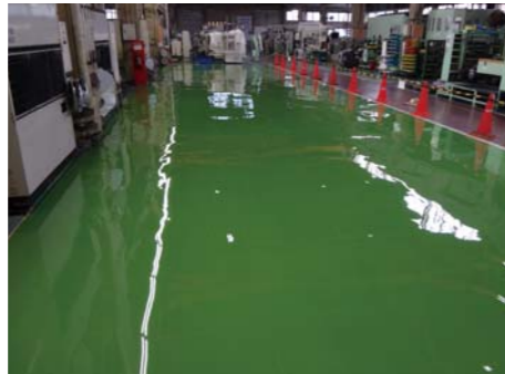
■光洋機械工業八尾工場(大阪) 塗り床材「ユータックコンプリートG薄膜」/200㎡ 建設/㈱三米建設 施工/アサヒカラコン(株)
