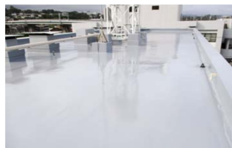
■シーサイドハイツ早川(神奈川) 建築用塗膜防水材「ブルーフロン」PK-V30G工法/450㎡ 建設(元請負)/武田塗装㈱ 施工/㈱ピーワークス
