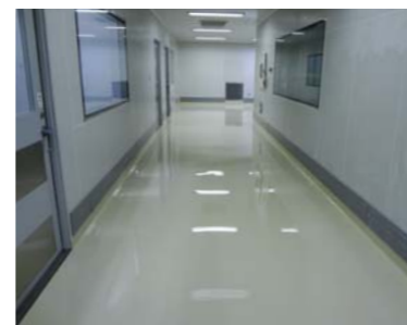
■参天製薬能登工場クリーンエリア通路(石川) 塗り床材「ユータックE-30N」ハード流し展べ工法/240㎡ 建設/小倉建設㈱ 施工/アサヒカラコン㈱
