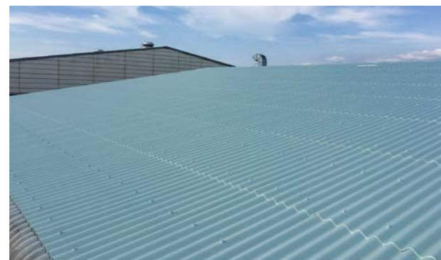
■㈱小松製作所第1棟、第2棟屋根塗装工事(長野) 屋根用遮熱塗料「パラサーモシールド」「スーパーパラサーモシリコンS」仕様/3,400㎡ 施工/倉又工業㈱
