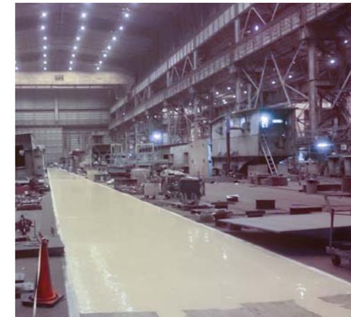
■津市某造船工場床改修工事(三重) 塗り床材「ユータックE-30N」流し展べ工法/1,400㎡ 施工/ライニング技術工業㈱
