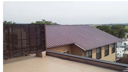
■松本市某老人ホーム屋根改修工事(三重) 屋根用遮熱塗料「パラサーモシリコン」/1,100㎡ 施工/㈱土谷塗装工業所
