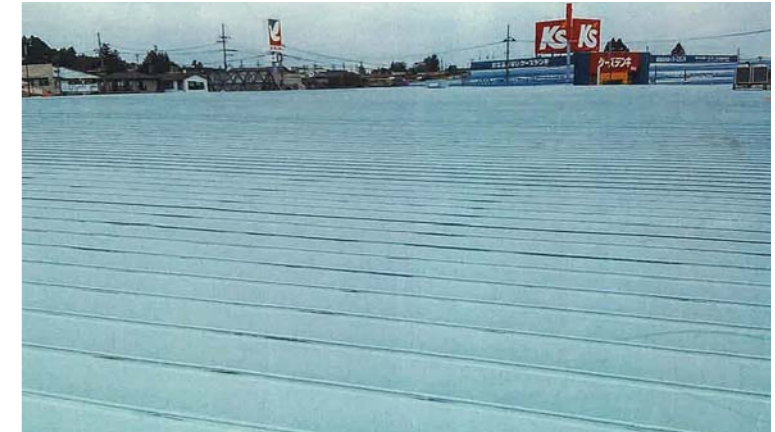
■ヨークベニマル築館店(宮城) 非鉄金属用プライマー「エボラ#3プライマー」+屋根用遮熱塗料「パラサーモシリコン」/7,460㎡ 建設/前田建設工業㈱東北支店 施工/㈱ワタナベ建築
