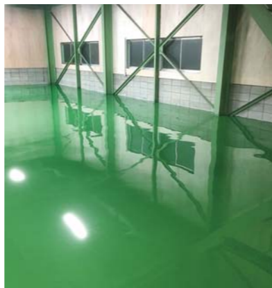
■山田梱包(株)(大阪) 塗り床材「ユータックスーパーハードN」/300㎡ 施工/古賀工業(株)
