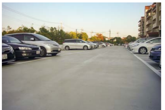
■グランコリーナ西神南大規模修繕工事・外部駐車場塗床工事(兵庫) 塗り床材「ユータックスーパーハードN」流し展べ防汚工法、「ユータックR」仕上げ/1,100㎡
