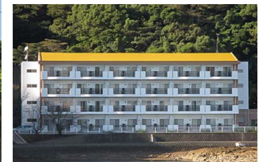
■内浦住宅(長崎) 建築外装用遮熱塗料「シルビアセラティーN遮熱」/2,373㎡ 施工/山外工業(株)
