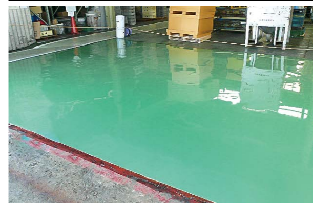
▲試験施工/当社平塚工場にてユータックTMプロテクトを塗布
