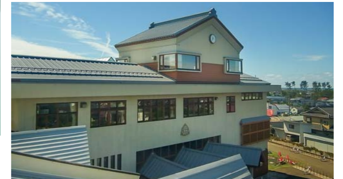
■能代市立東雲中学校屋根改修工事(秋田) 屋根用塗料「マッキンレー」/3,000㎡ 施工/能代塗装
