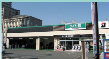
■タイヤ館鶴見花博店改修工事(大阪) 塗り床材「ユータックスーパーハードN」/230㎡ 建設/㈱コーケン 施工/古賀工業(株)
