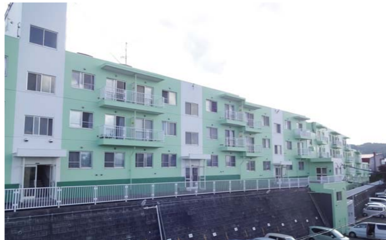
■桜見晴らしグランドハイツ大規模修繕工事(北海道) 外装用微弾性塗料「シルビアサーフ」/2,428㎡ 高弾性外壁防水塗材「ハイブルー上塗」/2,428㎡ 施工/㈱星塗装工業
