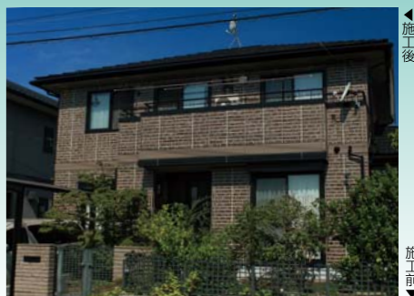
■宇部市戸建外壁(山口) 建築外装用塗料「シルビアセラティーN」水性プライマー工法標準仕様/150㎡ 施工/共立(株)
