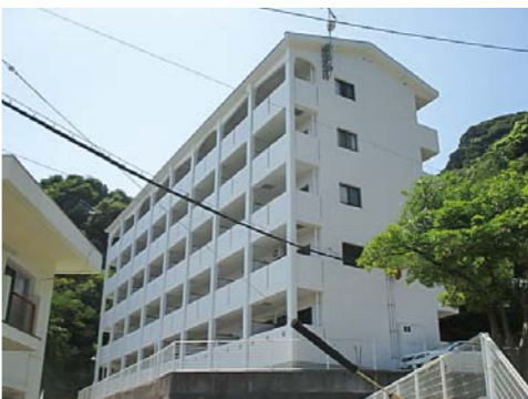
■大島造船所L棟(長崎) 建築外装用遮熱塗料「シルビアセラティーN遮熱」/2,763㎡ 施工/山外工業(株)
