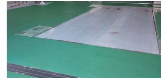
■松坂市衛生センター(三重) 塗り床材「ユータックE樹脂モルクリヤー」ユータックE-30N/700㎡ 施工/ライニング技術工業㈱
