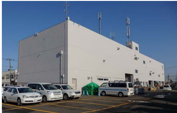
■北海道電工株式会社札幌支店倉庫棟改修工事(北海道) 高弾性外壁防水塗材「ハイブルー大波工法」/1,773㎡ 施工/㈱星塗装工業
