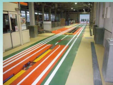
■(福井車検場) 福井事務所審査機器更新に伴う床面等改修工事(福井) 塗り床材「ユータックE-30N」ハード流し展べ防滑工法、ライン「ユータックR」/250㎡ 建設/村中建設㈱ 施工/㈱マエダ化研
