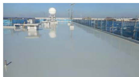
■川口市営前川4丁目住宅(埼玉) 建築用塗膜防水材「ブルーフロン」PN-E30EF/950㎡ 建設(元請負)/㈱カイシン 施工/㈱ハスナ
