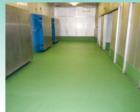
■JA飛騨椎茸製造所高圧蒸気滅菌室・荷入室(岐阜) 塗り床材「ユータックコンプリート」CPS-4F/180㎡ 施工/㈱愛知レジ
