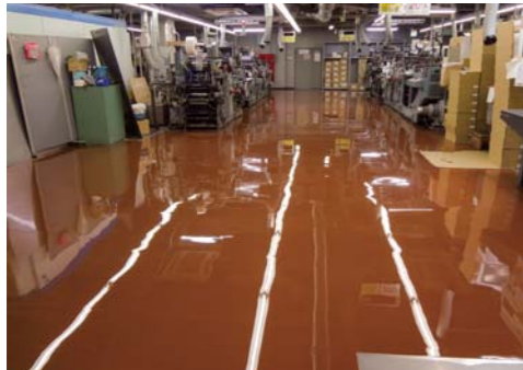
■ハート封筒八尾工場(大阪) 塗り床材「ユータックE-30N」ハード流し展べ工法/200㎡ 建設/山崎工務店 施工/アサヒカラコン(株)
