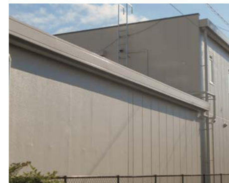
■某銀行改修工事(三重) 建築外装用塗料「シルビアセラティール」/850㎡ 施工/㈱土谷塗装工業所
