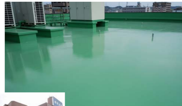
■県民共済八乙女店(宮城) 建築用塗膜防水材用上塗り塗料「ブルーロンGRトッ プ」/800㎡ 塗り床材「ユータックA-N」/100㎡ 施工/㈱フジワラ翔
