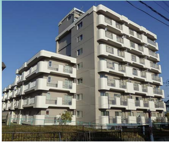
■エステート宮の沢大規模修繕工事(北海道) 高弾性外壁防水塗材「ハイブルー大波工法」/2,483㎡ 建築用塗膜防水材「ブルーフロン」295㎡ 施工/㈱星塗装工業
