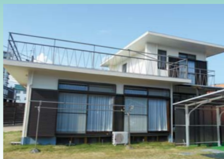
■防府市戸建外壁(山口) 建築外装用断熱塗料「NTダンネツコート」遮熱水性トップ仕上げ仕様/150㎡ 施工/松田美装
