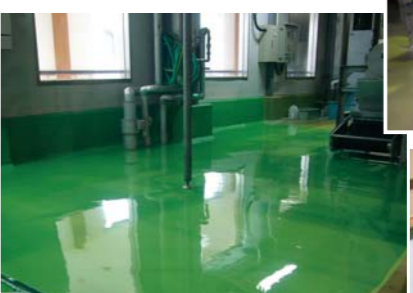
■霧島酒造株式会社比田工場(宮崎) 塗り床材「ユータックコンプリートG薄膜」「ユータックコンプリート」立上がり用/500㎡ 施工/古賀工業(株)
