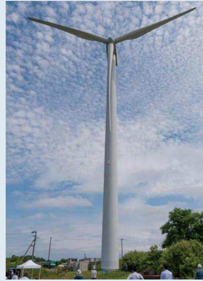
市民風車「わんず」。全長100m、ブレード長35m、定格出力1,500kW。
