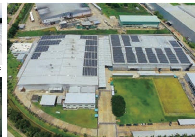
太陽光発電を導入した工場（海外関係会社）
