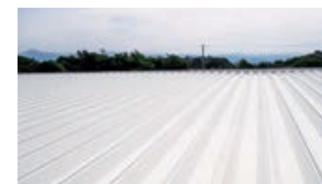
遮熱・断熱効果のある塗料で建物の空調効果を高めCO 2 排出量を削減
