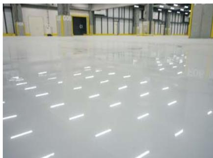
▲塗り床材「ユータックE-30N」採用例(ヤマト運輸
