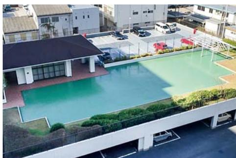
▲建築用塗膜防水材「ブルーフロンEGトップ4F」採用例
