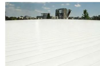
▲屋根用遮熱塗料「パラサーモシリコン」採用例（モリパーク・アウトドアヴィレッジ）
