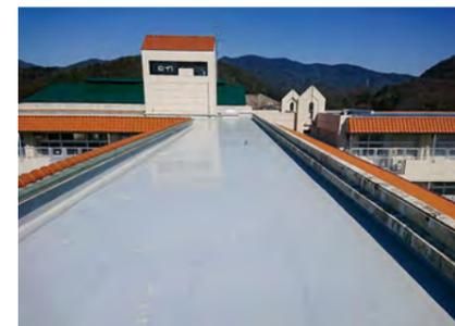
▲建築用塗膜防水材「ブルーフロンエコDX」採用例(某学校屋上)
