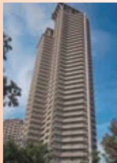
▲ニットクメンテ(株)によるマンション改修工事
