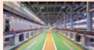
▲塗り床材「ユータックE-40」（北海道新幹線函館総合車両基地）
