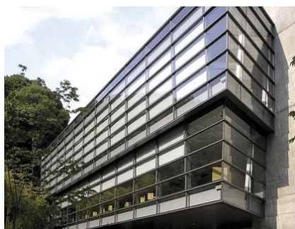
速硬化性弾性FRP防水材「タフシール防水工法」 (坂の上の雲ミュージアム)
