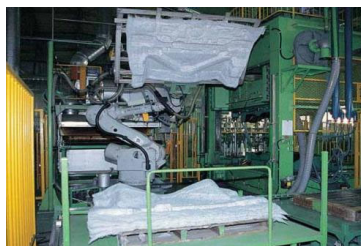
リサイクル繊維を利用した生産設備
